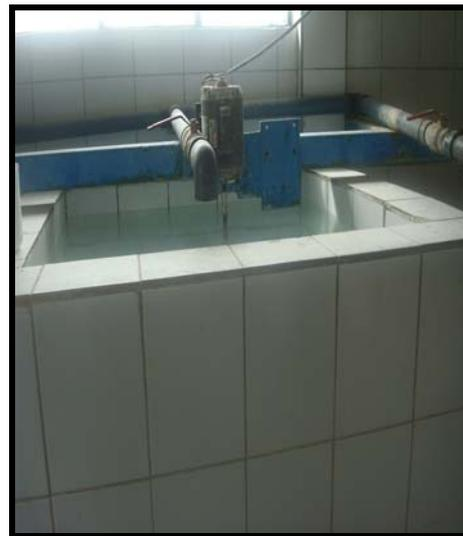
**Ilustración 11.** Preparación de sulfato de aluminio.
