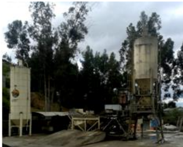
Figura 1: Fotografía de la Planta Hormigonera Guapán
