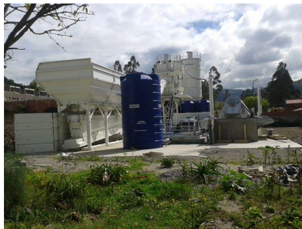
Figura 2: Nueva Planta de Hormigón;
