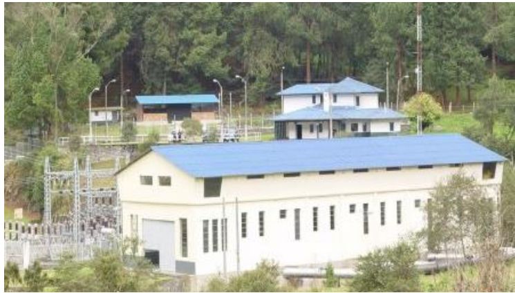
Figura 3.2: Central Hidroeléctrica Ing. Fernando Malo (Saucay) [1].
