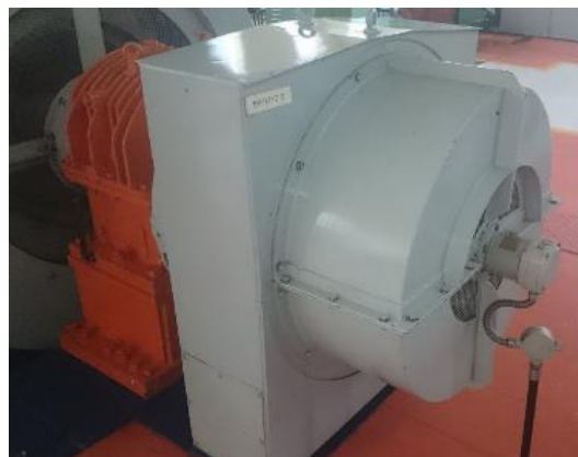
Figura 4.12: Excitador principal y piloto (PMG) del grupo de generación 2 (Imagen tomada en el sitio).
