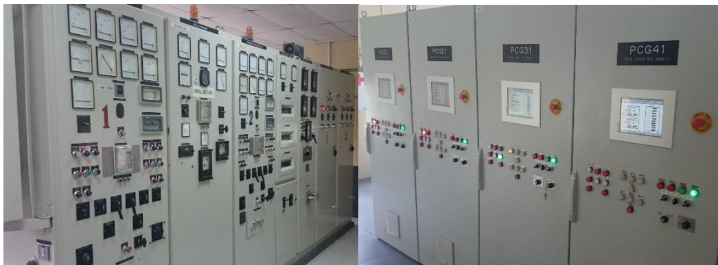
Figura 8.20: Tableros de control antiguos (izquierda) y modernos (derecha) (Imagen tomada en el sitio).
