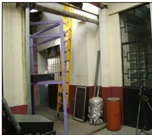
Fig.4c.- Pasillo que conduce al cuarto de calderos.
