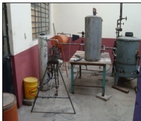
Fig.26b.- Acceso al Cuarto de Calderos.
