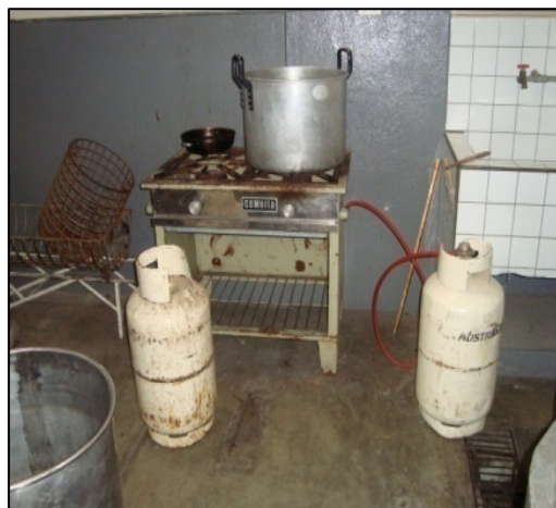
Fig.20d.- Cilindros de GLP sin protección junto a fuentes de ignición en el Laboratorio de Cárnicos.
