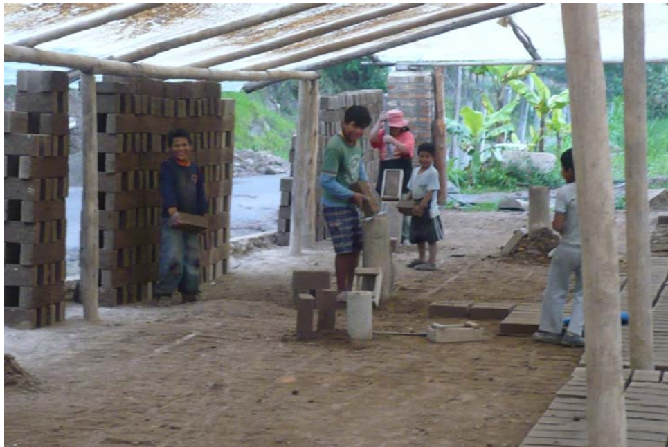
Fotografía 12: Formas de trabajo (Ladrillera de Susudel)
