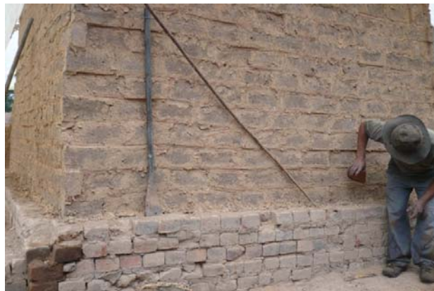
Fotografía 11: horno rectangular (Ladrillera de Susudel)
