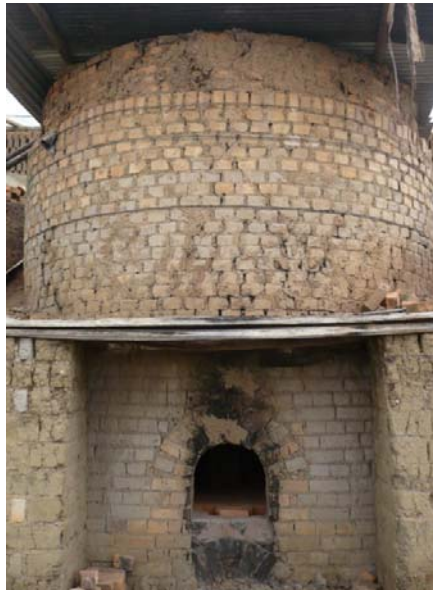
Fotografía 10: horno circular (Ladrillera de Susudel)
