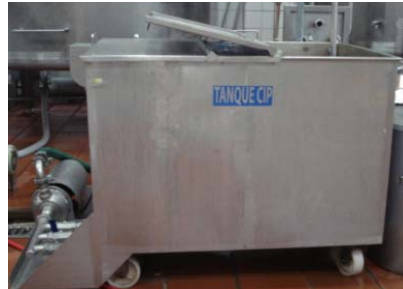
Tanque CIP en el área de pasteurización
