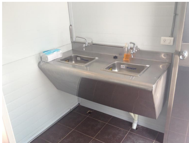
Ilustración 62: Tuberías expuestas Fuente: Propia
