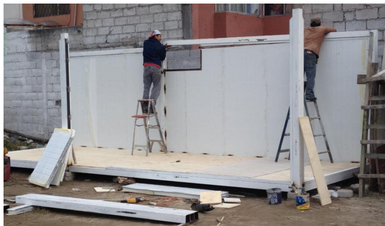
Ilustración 64: Colocación de estructura Fuente: Life Futbol Sport
