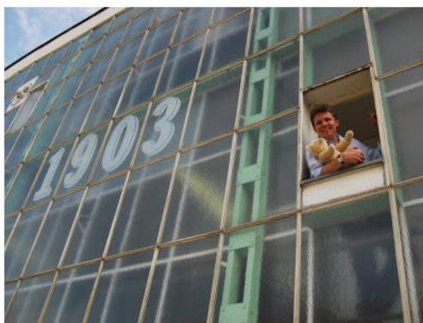
Ilustración 2: Vista de la nave en donde el vidrio está colocado sobre las columnas Fuente: http://facadesconfidential.blogspot.com/2011/
