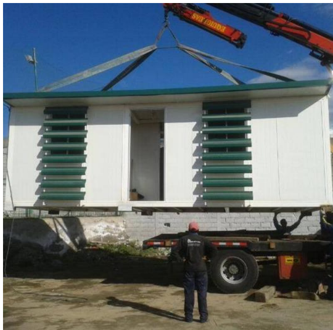
Ilustración 69: Izado y traslado de las oficinas Fuente: Life Futbol Sport
