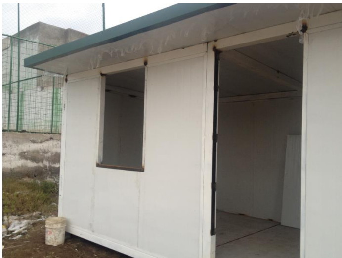
Ilustración 66: Ventanas cortadas y soldadas a 45° Fuente: Life Futbol Sport / Propia
