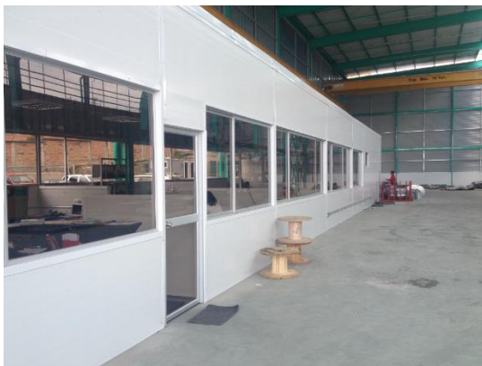
Ilustración 57: Paneles horizontales, canal U Fuente: Propia
