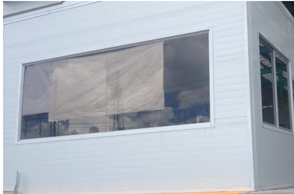
Ilustración 58: Ventanas en sistema de paneles tipo sándwich Fuente: Propia
