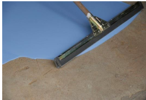
Ilustración 100: Pavimento de resinas de poliuretano autonivelante
