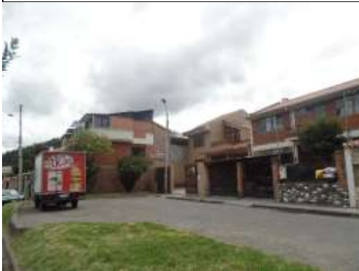
Vivienda unifamiliar en el cantón Cuenca
