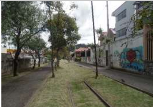
Conservación parcial de rieles en el cantón Cuenca
