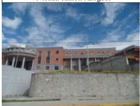
Infraestructura pública Azogues
