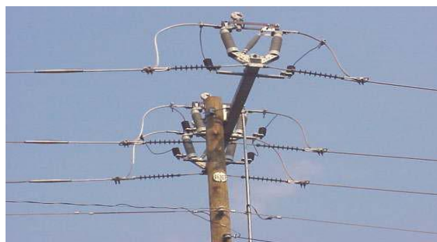
Figura 3.15. Cuchilla seccionadora [1]
