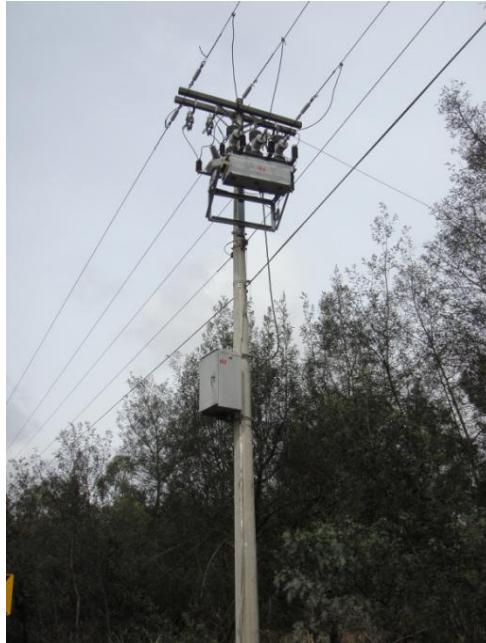
Figura 3.14. Elementos de un Reconector [Autor]
