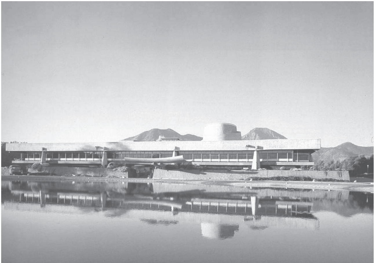
Imagen 60. Edificio del CEPAL (Comisión Económica para América Latina, Naciones Unidas), Vitacura, Santiago, 1966. Arq. Emilio Duhart Harosteguy.
