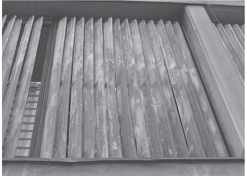
Imagen 148. Detalle del cerramiento muro cortina. Estado actual.
