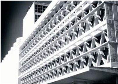
Imagen 143. Edificio de los molinos, Complejo Industrial Carozzi.
