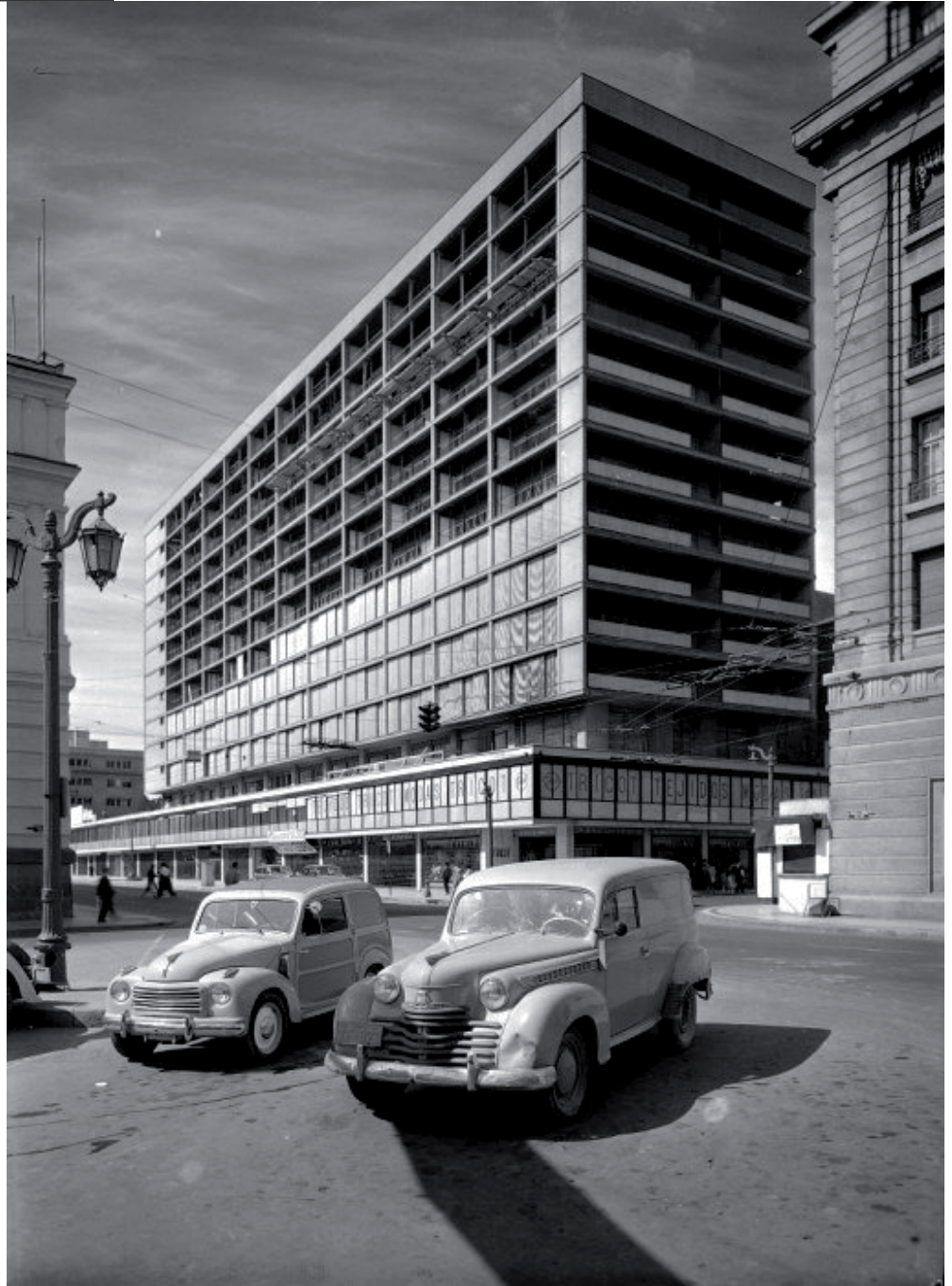
Imagen 79. Edificio Plaza de Armas, toma desde la plaza del mismo nombre.
