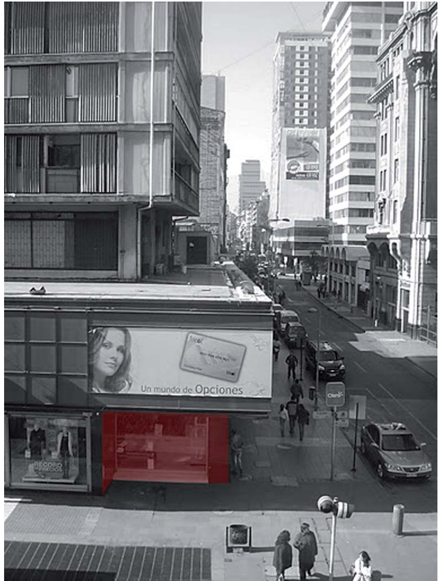
Imagen 98. Vista de la esquina sur-oeste del Edificio Plaza de Armas, en el cual se muestra la substracción de la esquina del basamento al nivel del recorrido urbano.
