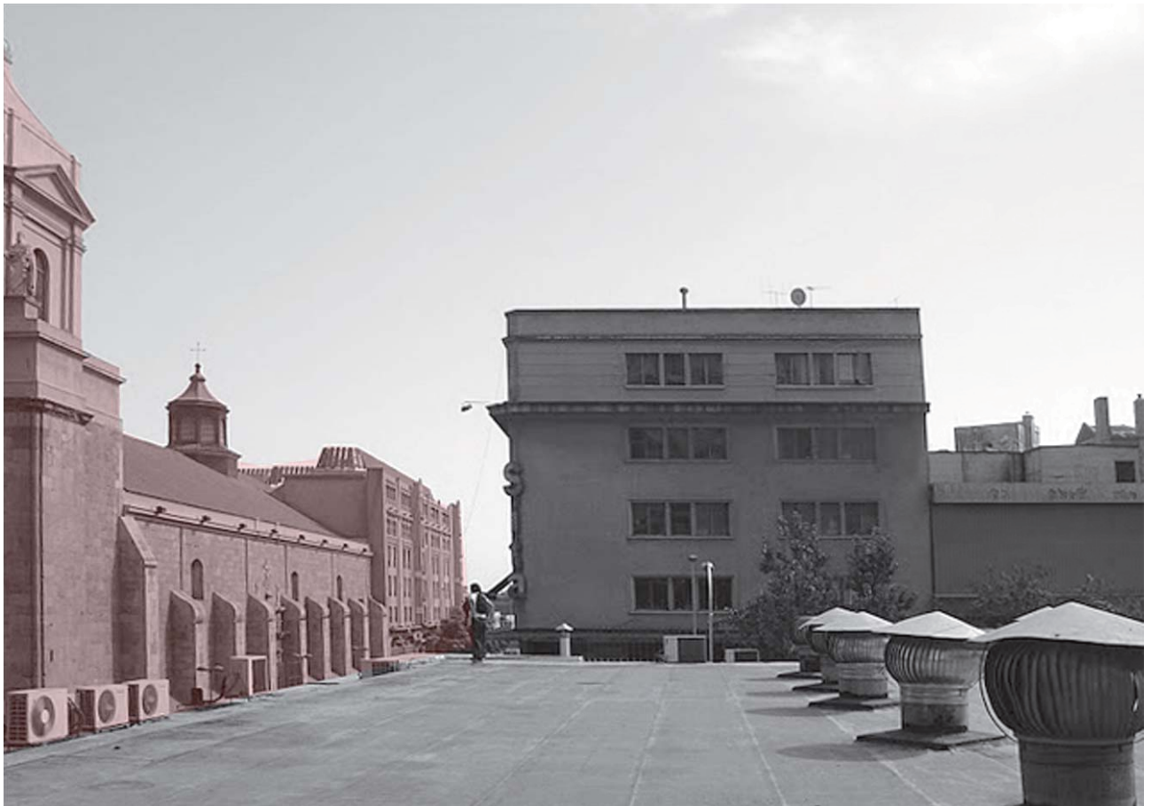
Imagen 130. Vista desde la terraza hacia la Iglesia de Santo Domingo.
