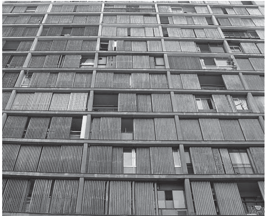
Imagen 149. Vista del cerramiento muro cortina, desde el exterior de la edificación al nivel de la calle.
