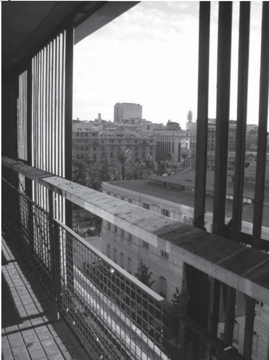
Imagen 147. Vista del cerramiento muro cortina, desde el balcón en la fachada oeste.
