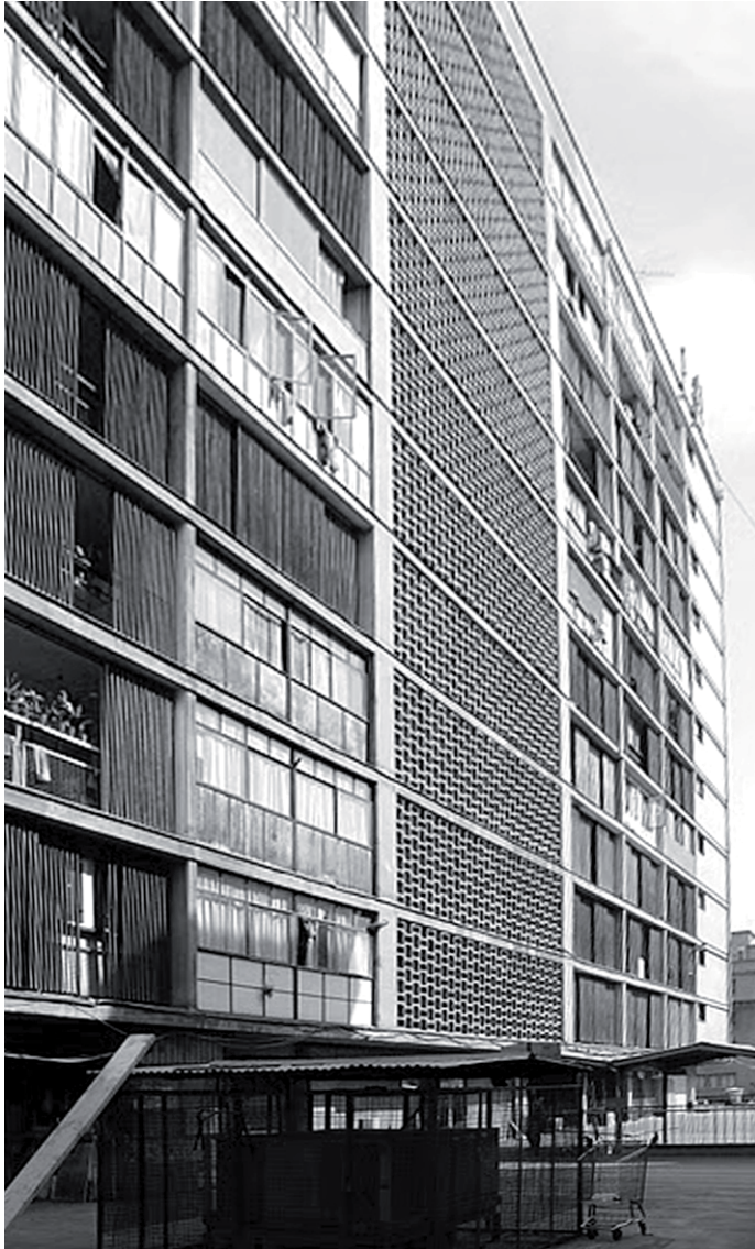
Imagen 150. Vista del muro cortina de la fachada este con la textura de cuadrículada de la caja de escaleras.
