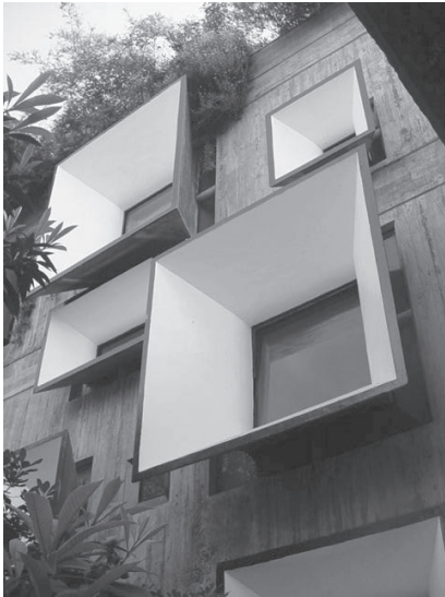
Imagen 61. Detalle de ventanas del Edificio del CEPAL, Vitacura, Santiago, 1966. Arq. Emilio Duhart Harosteguy.
