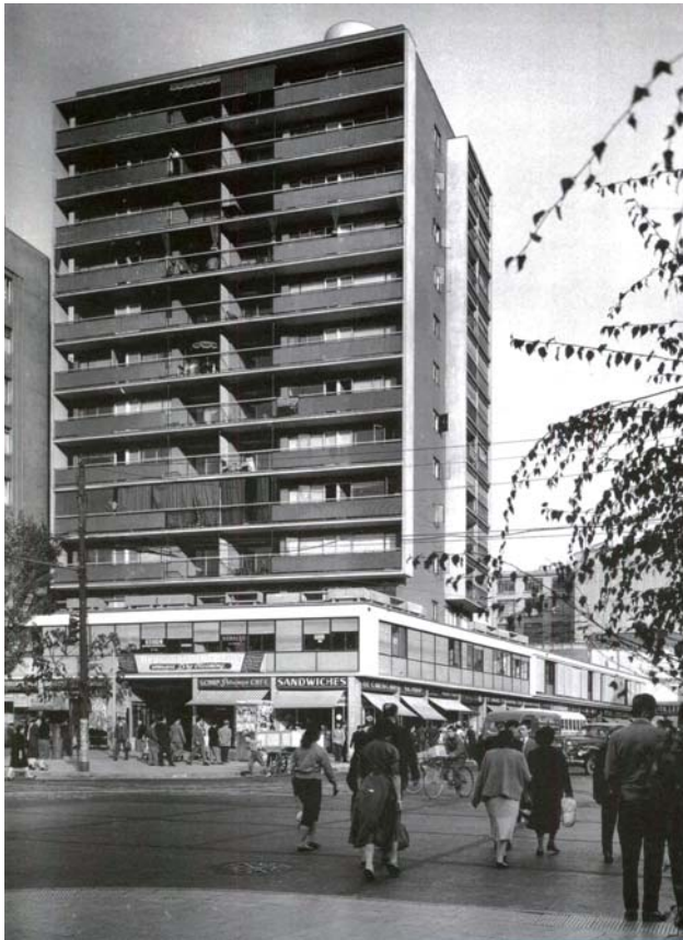
Imagen 114. Edificio Arturo Prat. Vista fachada norte.
