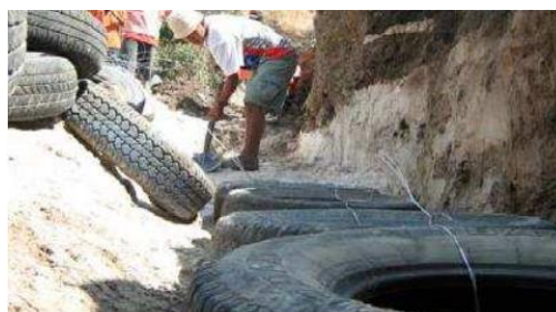
Ilustración 16: Amarre de llantas en cada fila. Fuente: (Horigome, 2010)
