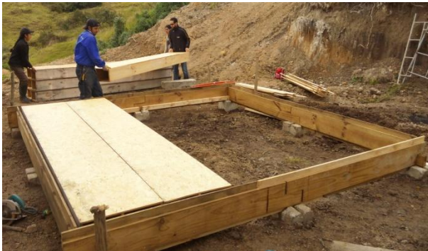
Trasladado de placas prefabricadas Foto: Felipe Cobos H
