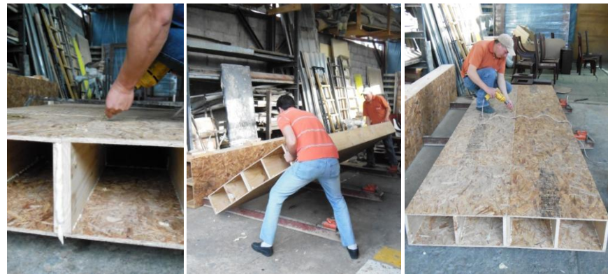
Foto. 24 Unión superior e inferior con tornillos cincados alternados (derecha e izquierda)
