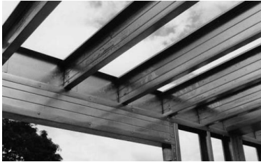
Fig. 38 Posicionamiento de las vigas de entrepiso en las cenefas 17
