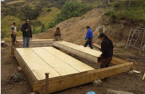
Placas prefabricadas apoyadas en piezas de madera ancladas a vigas de madera.
