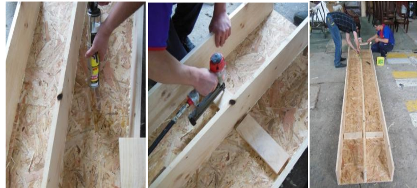
Foto 5. Refuerzo en unión posterior de tableros superiores
