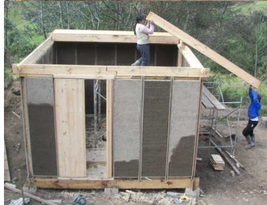
Armado de placas entrepiso
