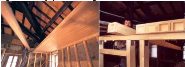
Fig. 119 Manipulación placa Box Element Lignatur
