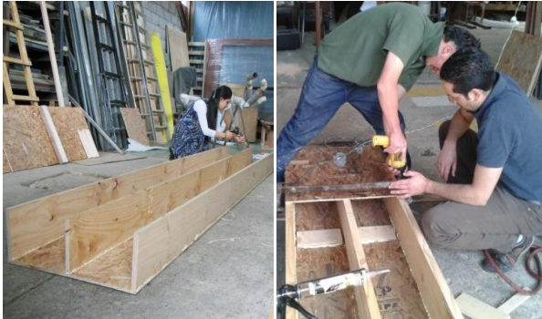
Foto 6. Estructura invertida y fijación de pieza inferior de 60x60cm
