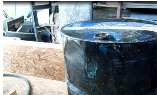
Foto 34. Agua rebosada de tanque con vibrado.
