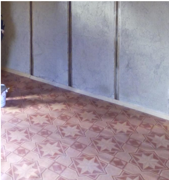
Forjado soporte de revestimiento
