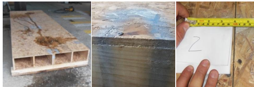
Foto 36. Unión no alterada entre elementos y entre placas
