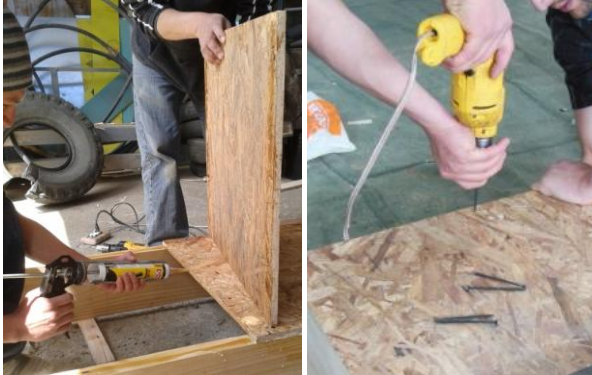
Foto 2. Fijación pieza superior de 60x60 cm, tornillos y adhesivo
