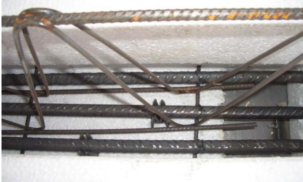
Fig. 58 Pieza de poliestireno soporte de armadura 25
