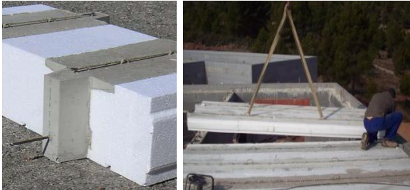
Fig. 57 Apoyo con salientes e izado de placa Modultherm 25
