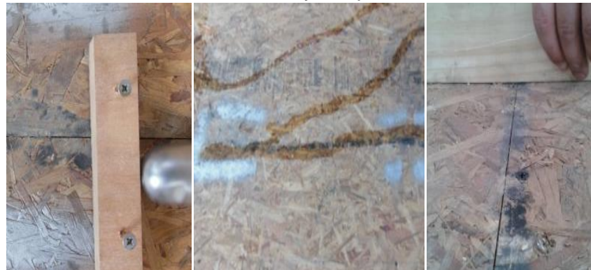
Foto 37. Zona de impacto, hundimiento de 2 mm
