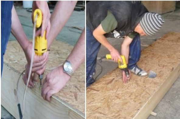
Foto 3. Fijación pieza superior de 240x60cm, tornillos c/15cm
