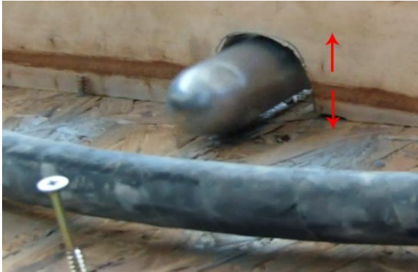
Foto 33. Elemento vibrador anclado a estructura
