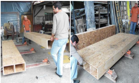
Foto 22. Colocación de placa sobre prensas
