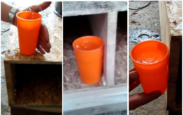
Foto 35. Cada zona del forjado estuvo sometida a la fuerza de impacto del vibrador.
