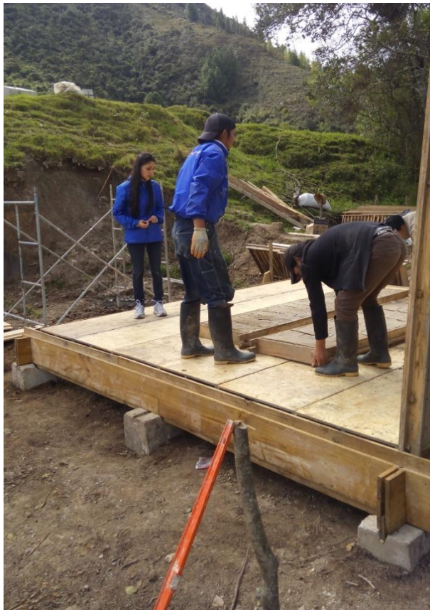
Superficie para armado de muros
