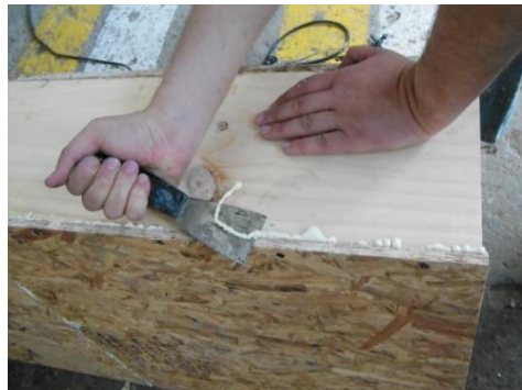
Foto 9 Limpieza de residuos en las caras de la placa
