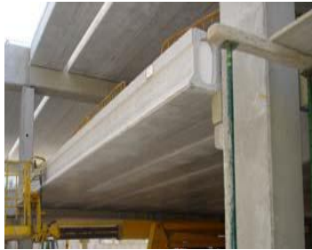
Fig. 53 Estructura de apoyo de placa alveolar 23
