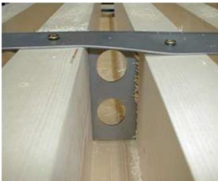
Fig. 34 Conectores metálicos unidos a la estructura de madera 15
