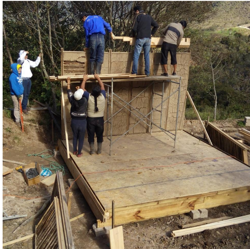
Uso de andamios para armar viga superior
