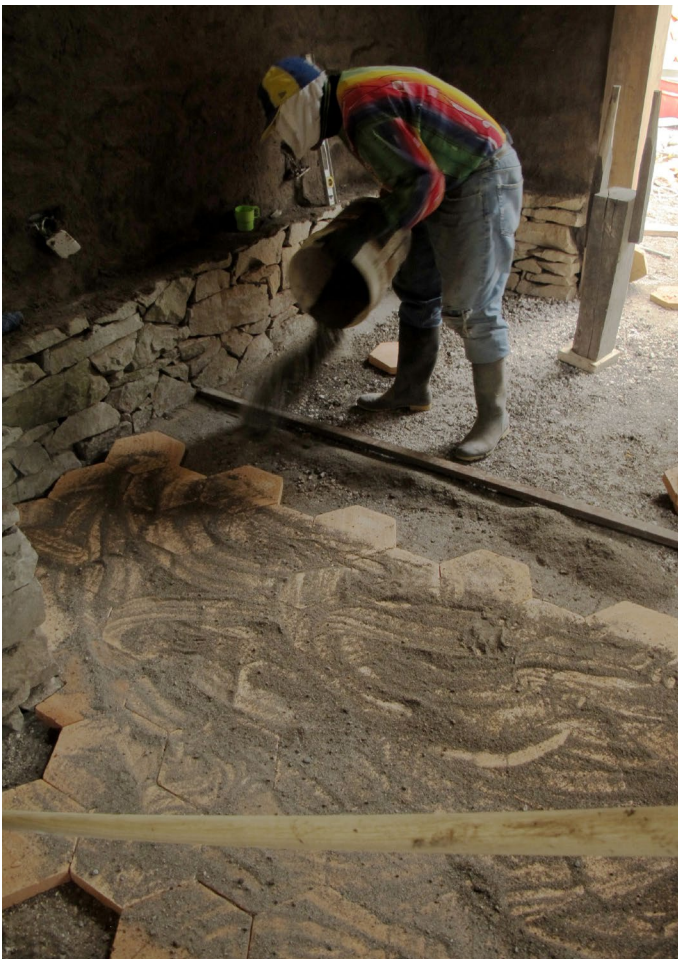
Foto_185: Colocación del piso de ladrillo.
