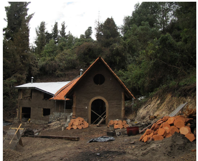
Foto_183: para el piso de ladrillo se necesita arena.
