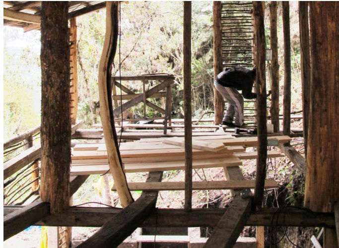
Foto_194: Inicio de la colocación del piso.
