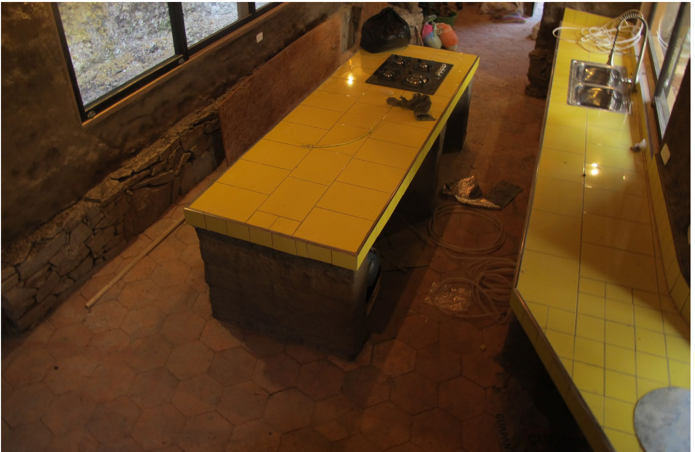
Foto_187: Acabado del piso de ladrillo.
