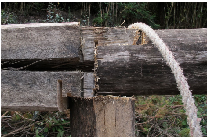
Foto_98: Unión de dos vigas sobre una columna.
