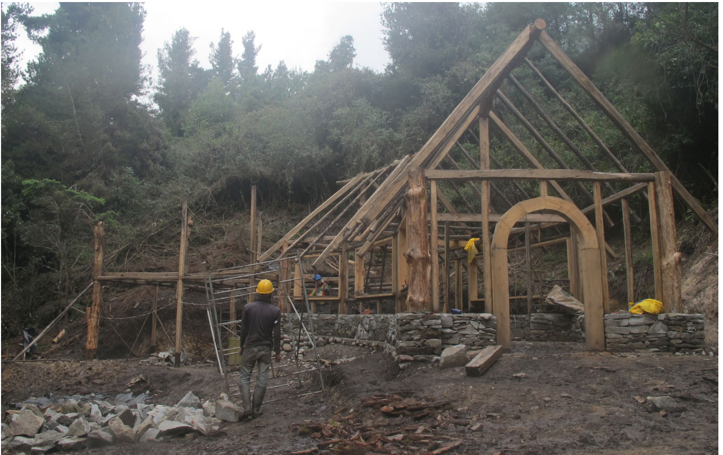
Foto_105: La estructura que soporta la cubierta también fue construida con madera y se armó en 2 etapas, primero la cubierta que iba a tener teja, y segundo el techo vivo. La diferencia en este punto está en el entriollado que necesita la teja.
