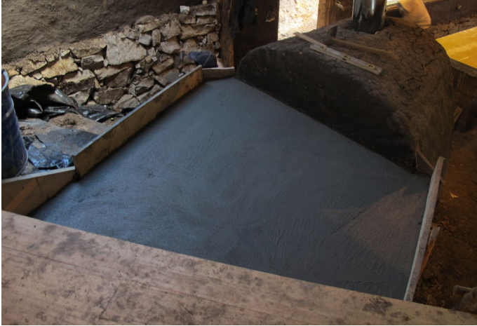
Foto_191: Base de hormigón para la baldosa.
