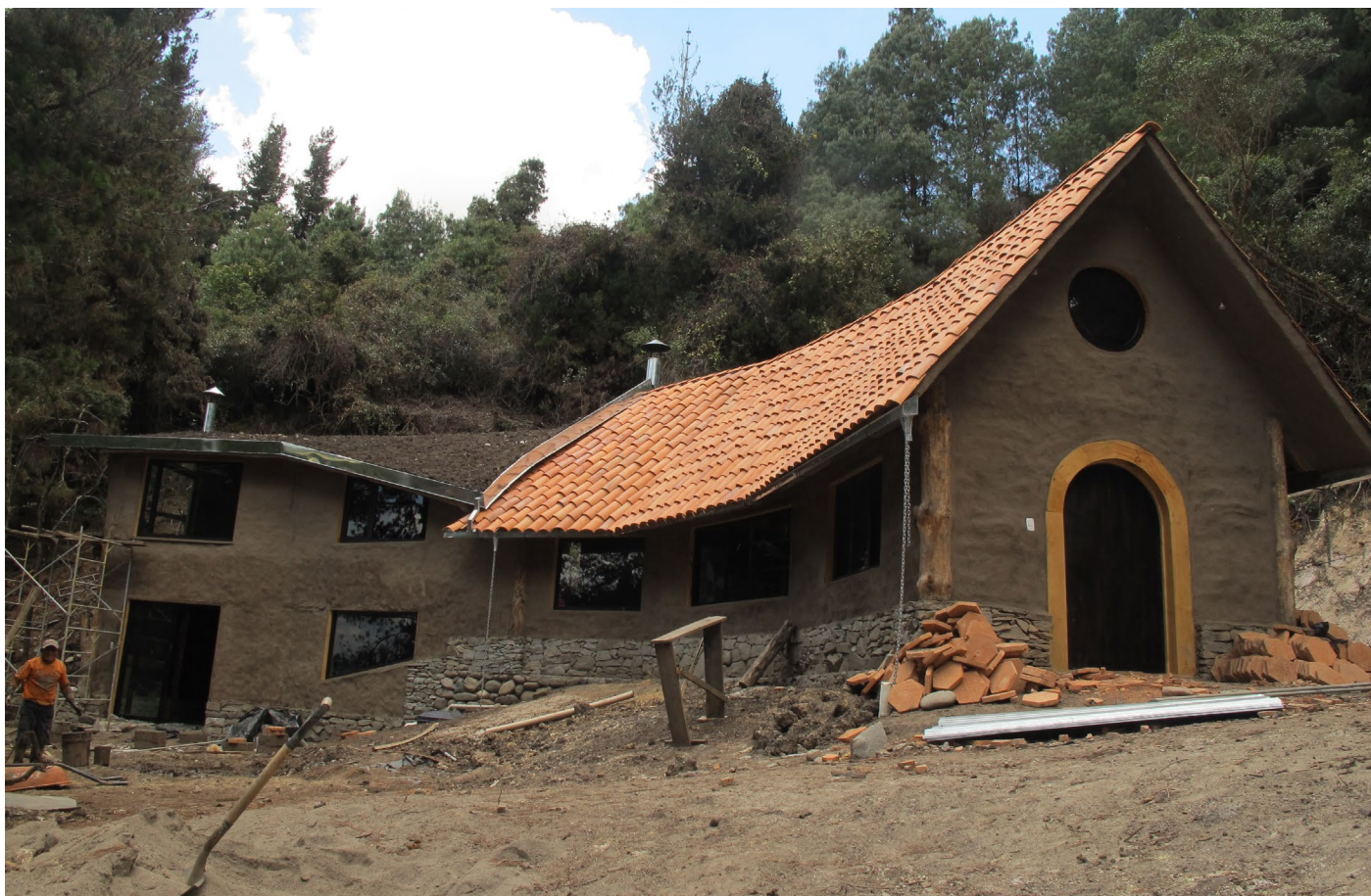
Foto_219: Luego de colocar las puertas y ventanas, se debe empezar la limpieza de la construcción para iniciar con el tratamiento para patios y jardines.
