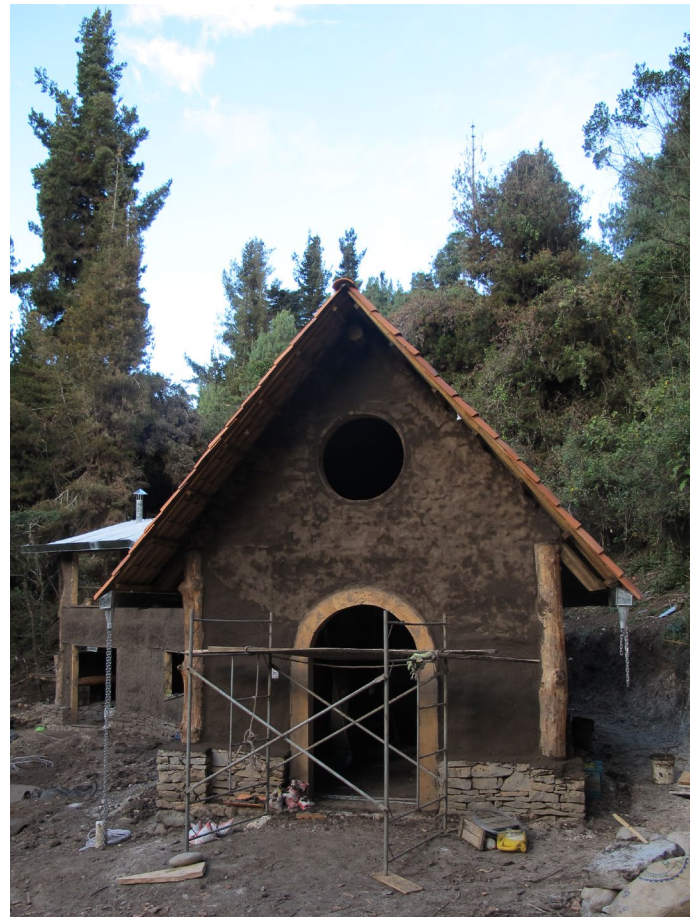
Foto_210: Secado del revoque fino.
