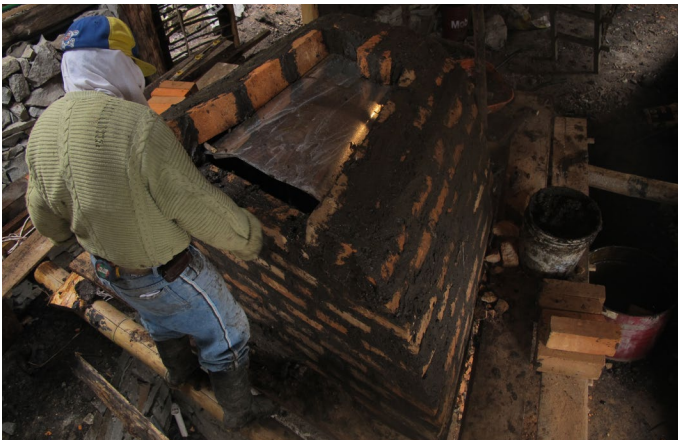
Foto_234: Salida del ducto.
