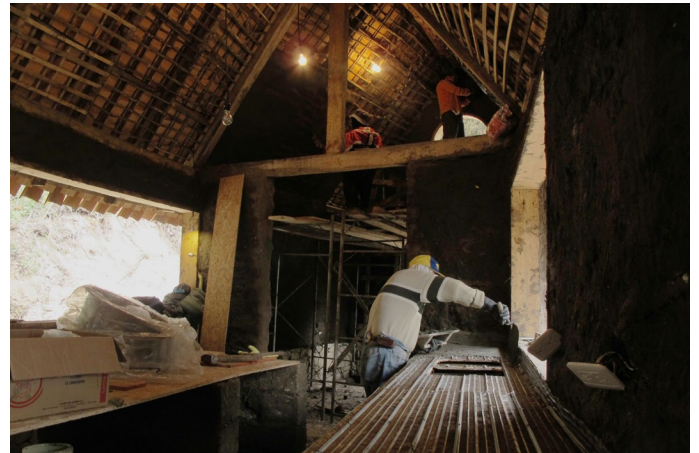
Foto_203: Construcción del mueble para el lavaplatos.
