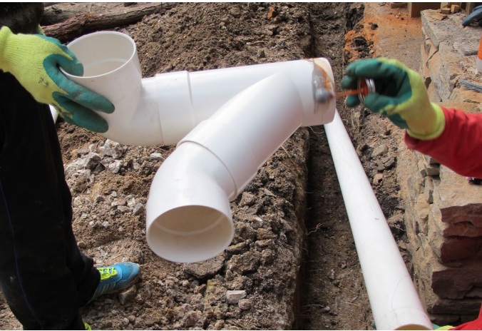
Foto_143: Pegado de las uniones del desagüe.
