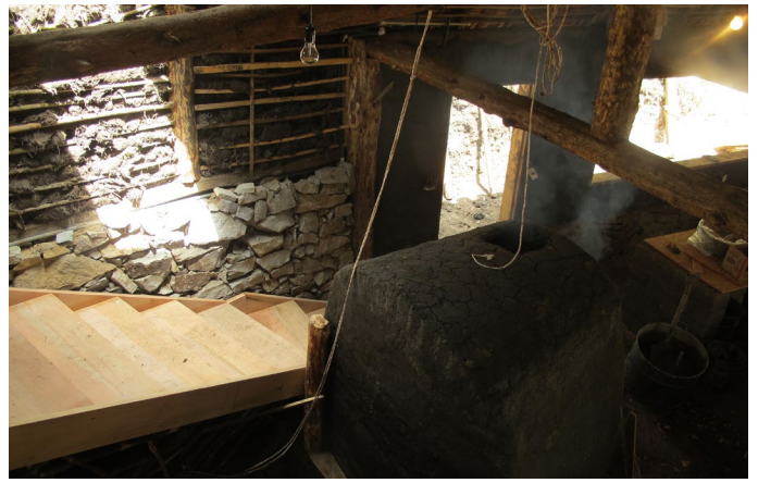
Foto_236: Puede prender el horno para agilitar el secado.
