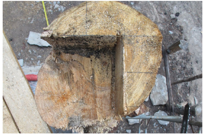
Foto_83: Destajes y uniones fueron realizados en obra.
