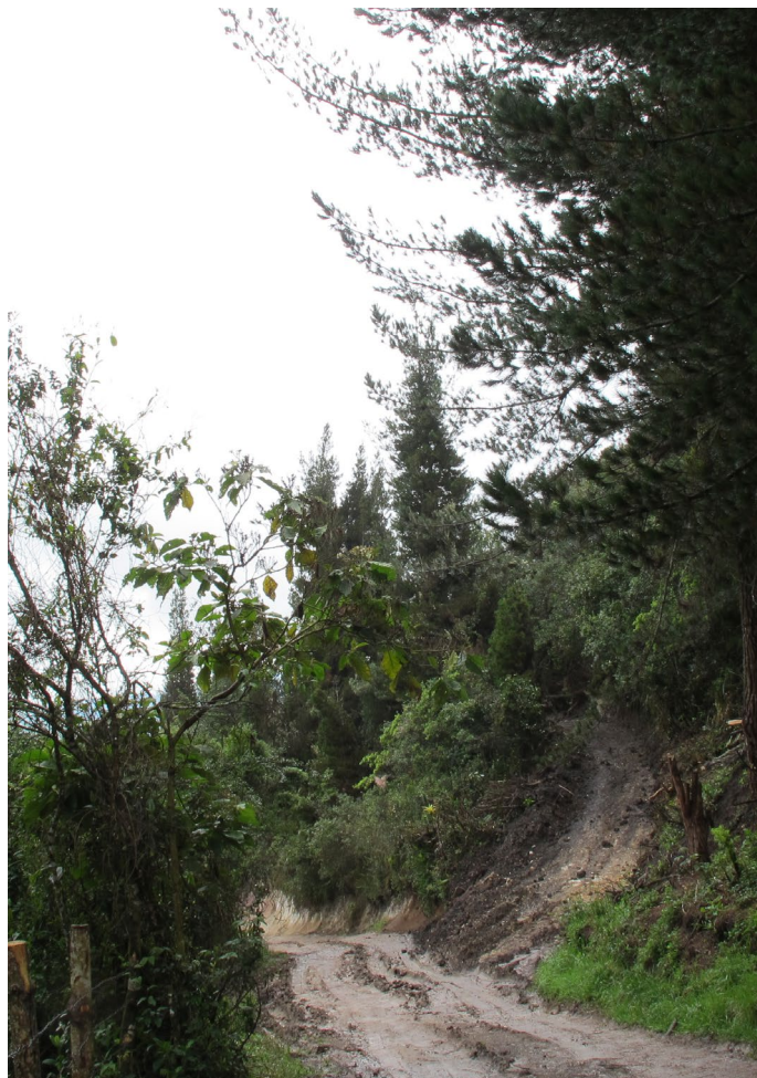
Foto_27: El camino se encontraba en mal estado.
