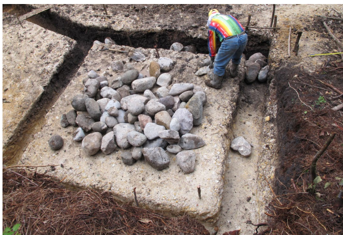
Foto_65: Relleno con piedra.
