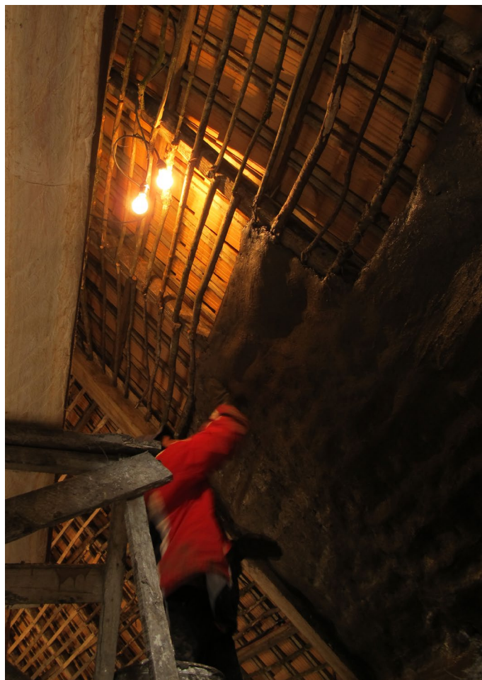
Foto_199: Proceso del cielo raso de barro.
