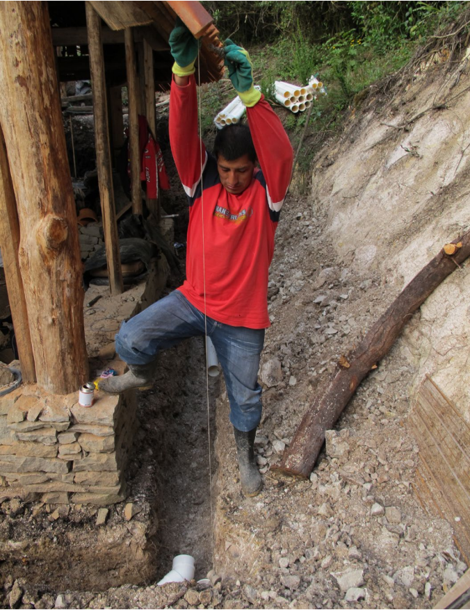
Foto_142: Se calcula en los bajantes de la cubierta la caída del agua a plomo para determinar la ubicación de la tubería.
