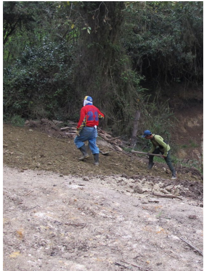
Foto_28: Material de mejoramiento para el camino.
