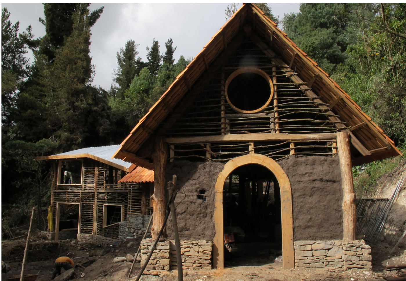
Foto_169: Revoque grueso.
