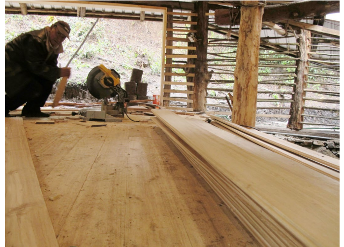
Foto_197: Armado del piso de eucalipto en obra.
