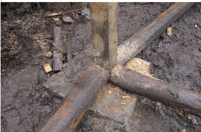
Foto_90: Unión de 3 vigas, con la columna y el cemento.
