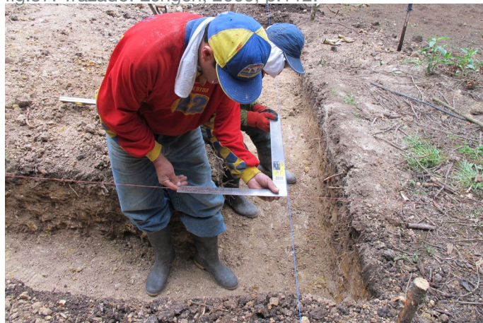
Foto_62: Perpendicularidad de la piola con la escuadra.
