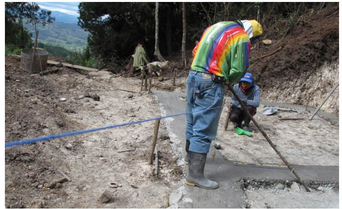
Foto_72: Los ejes para ubicar las columnas.
