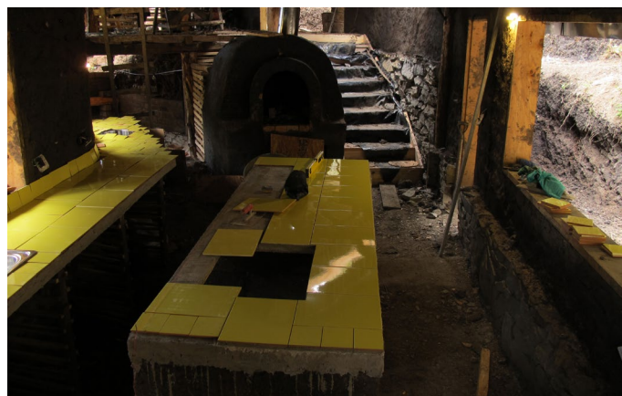
Foto_208: Proceso constructivo.
