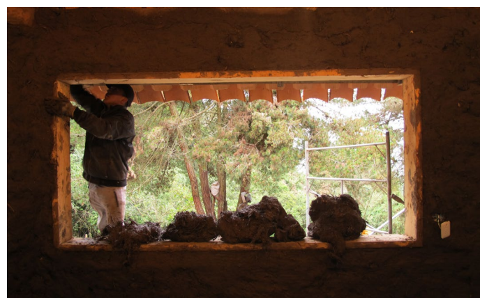
Foto_172: Trabajo en obra.
