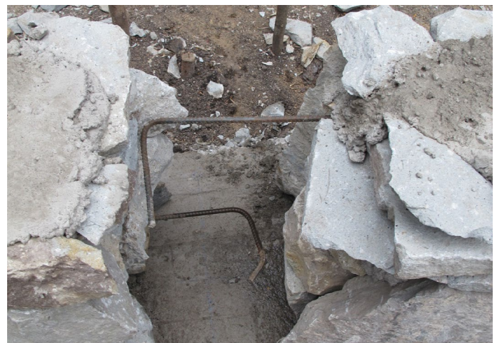
Foto_74: Varillas de hierro para sostener la columna.
