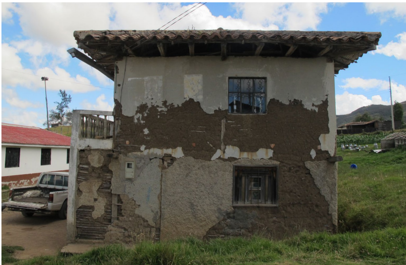
Foto_14: Construcción de bahareque, Victoria del Portete, Tarqui.
