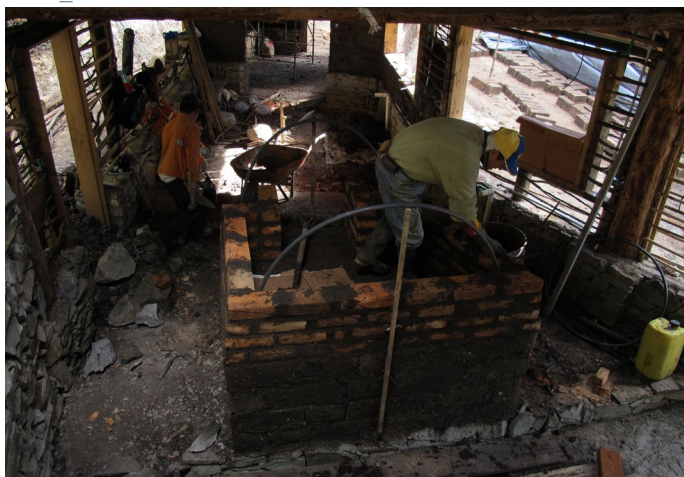
Foto_230: Construcción del horno.
