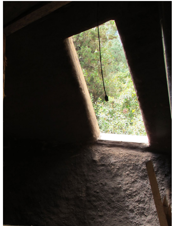
Foto_38: Ventana en la cubierta.
