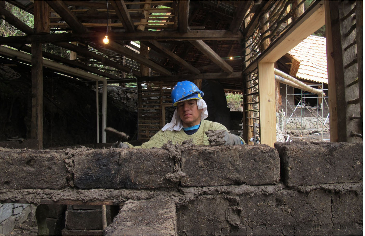
Foto_176: Los bloques después de secarse, se colocan en fila, procurando utilizar la misma mezcla del revoque grueso para todas las juntas. Si se arman las paredes sin un secado adecuado, se pueden llegar a caer o pandear.
