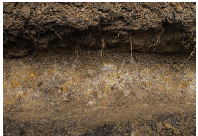
Foto_53: Zanja de cimentación.
