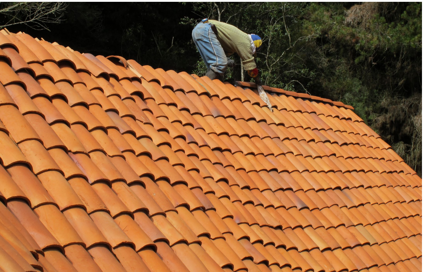
Foto_120: Al terminar de colocar toda la teja, se deja un espacio en la parte superior que permita el acceso y la colocación del cemento asfáltico y las tejas del cumbrero.
