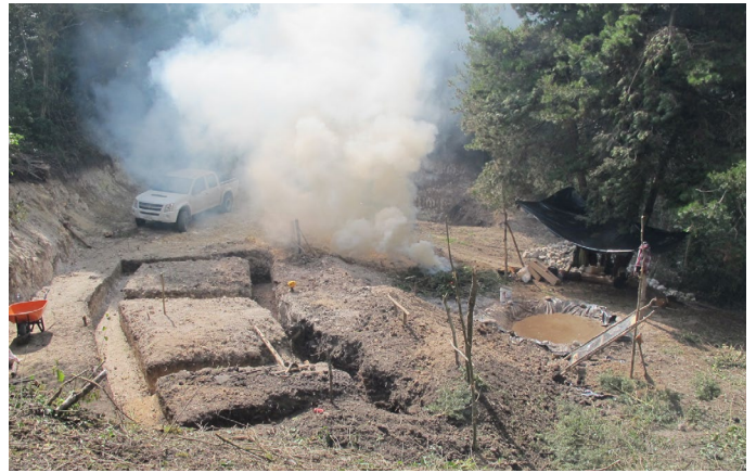
Foto_64: Zanja de la cimentación.
