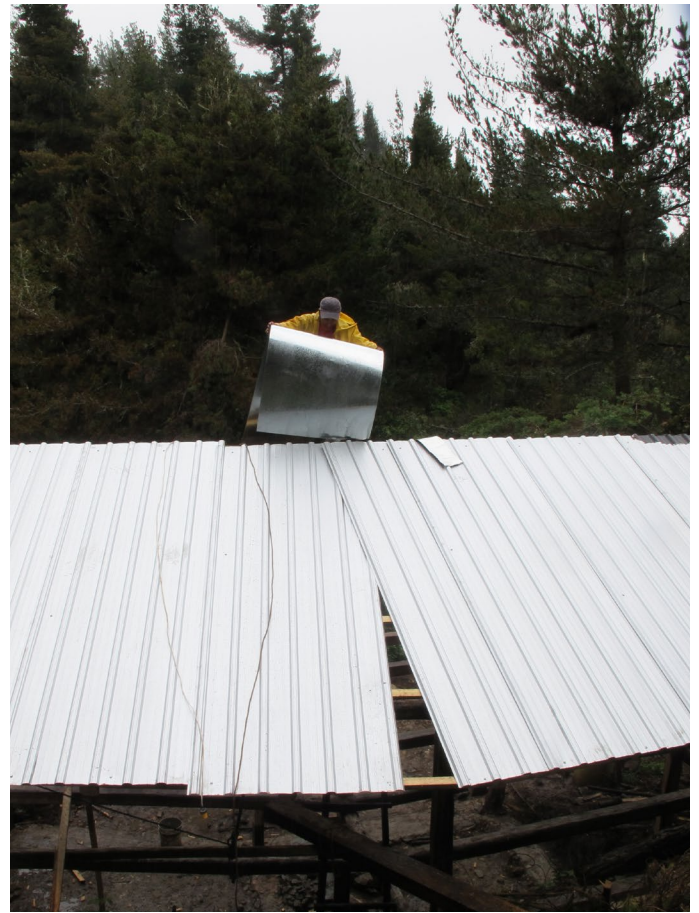
Foto_124: Para las curvas se utilizaron planchas de tool.
