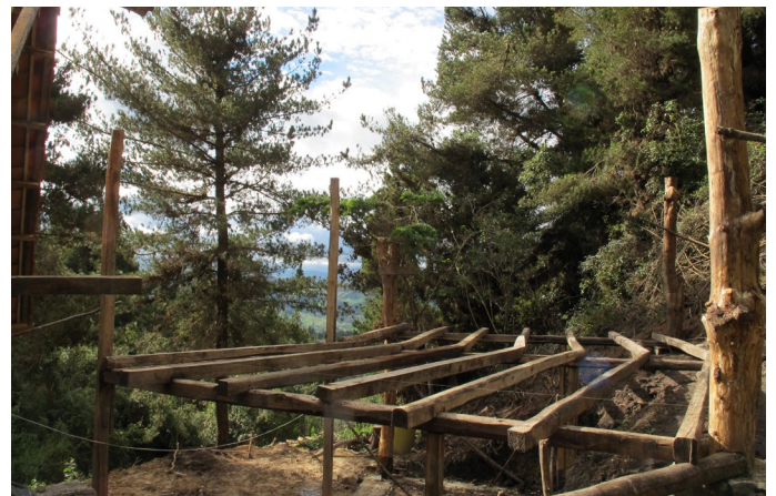
Foto_94: Estructura base para el nivel superior.
