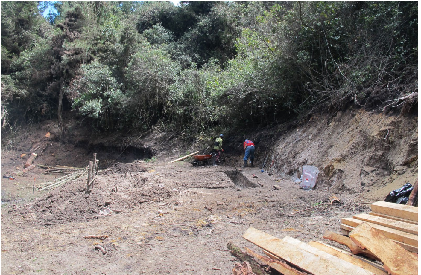
Foto_45: Los primeros días de la construcción.
