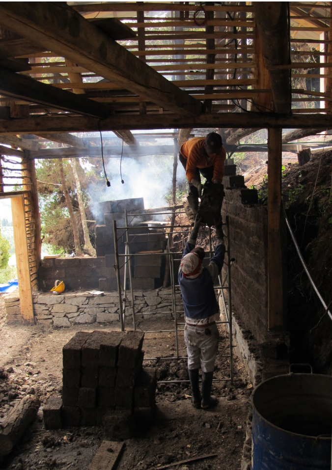
Foto_177: Colocación de adobes.
