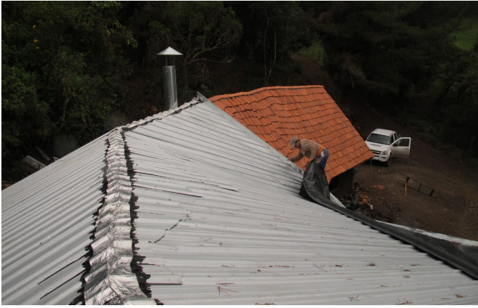
Foto_128: Se sella el cumbrero con cemento asfáltico.
