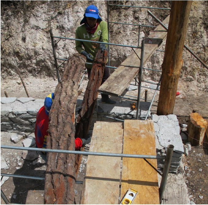
Foto_81: Andamios para el armado de la estructura.
