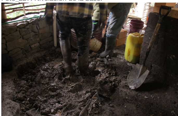
Foto_228: Preparación de la mezcla.
