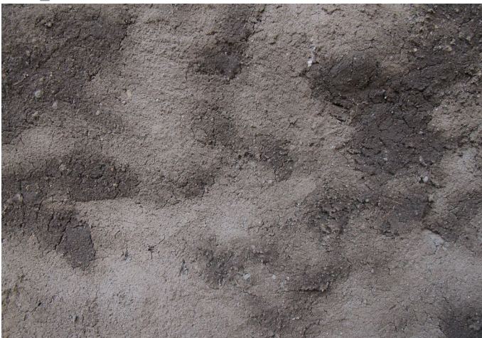
Foto_209: Secado del revoque fino.
