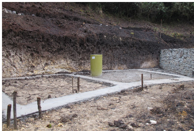
Foto_70: La cimentación terminada.
