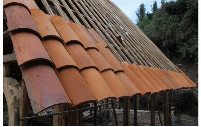
Foto_112: Sobre las tirillas se colocan las tejas.
