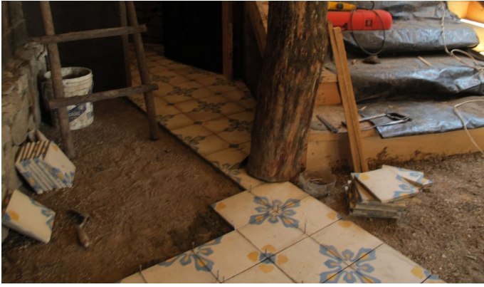
Foto_190: Colocación de la baldosa.
