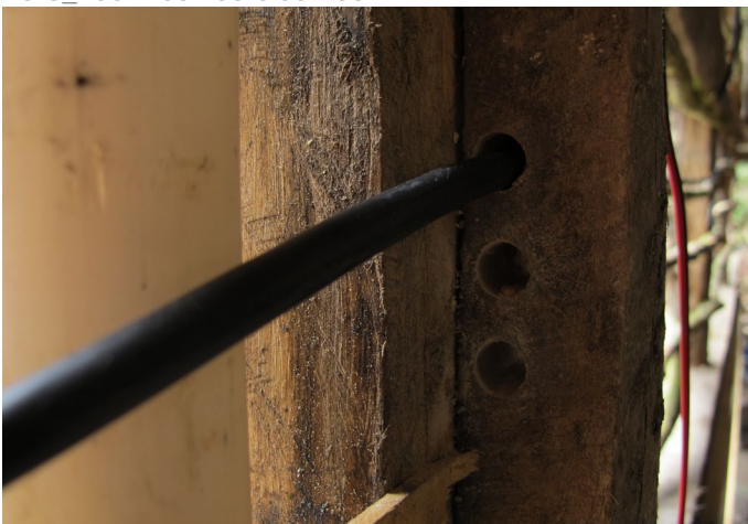
Foto_156: Detalle de cómo quedan enbebidas las instalaciones.
