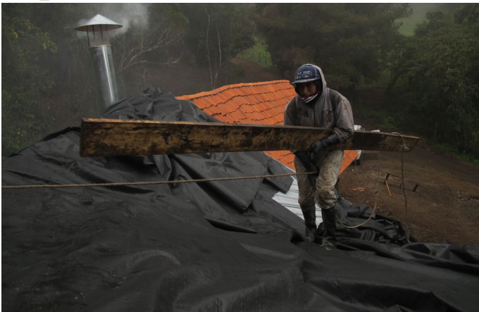
Foto_129: Se coloca la geomembrana.
