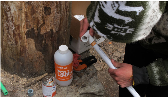
Foto_133: Las uniones limpiadas y soldadas.
