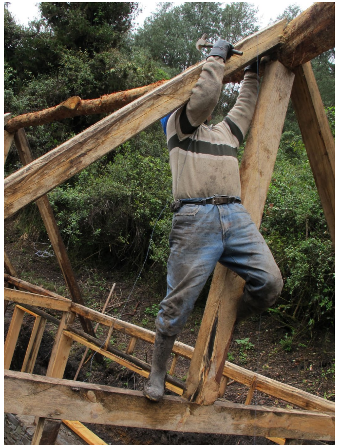
Foto_101: Colocación de las vigas centrales de la cubierta.
