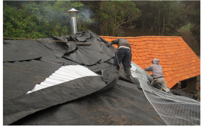
Foto_131: Se coloca la malla de gallinero.
