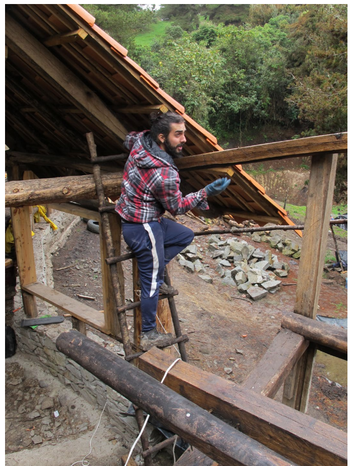
Foto_100: El trabajo en obra.
