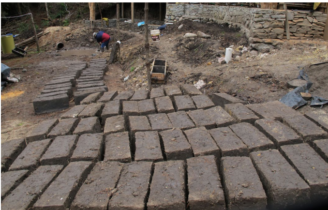
Foto_174: Proceso del secado de adobes.
