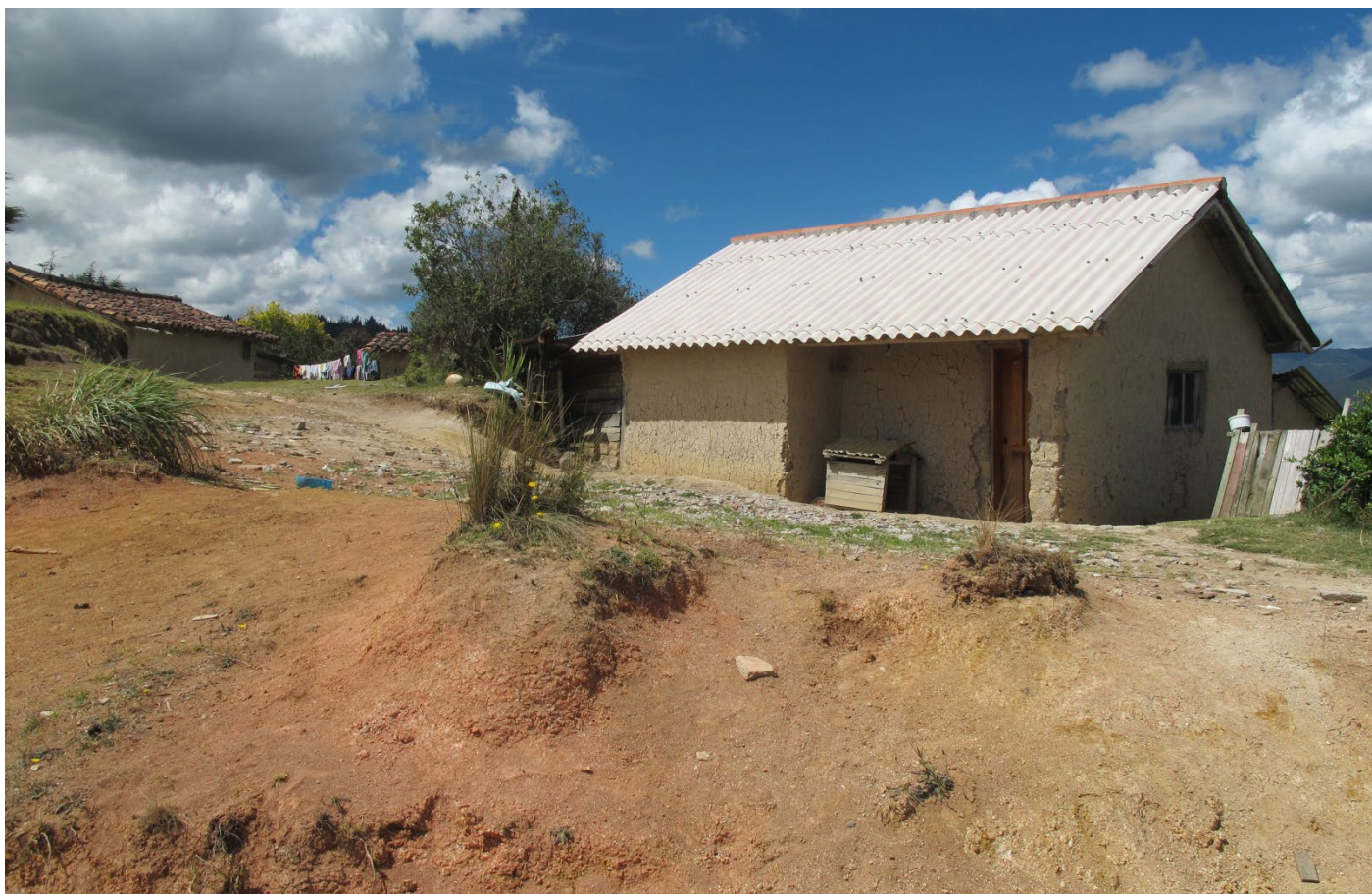
Foto_9: Construcción de adobe, San Vicente, Tarqui.
