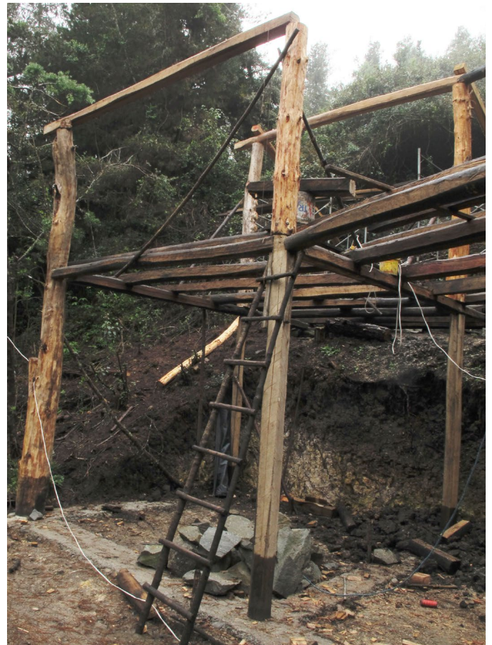
Foto_99: La estructura en proceso.
