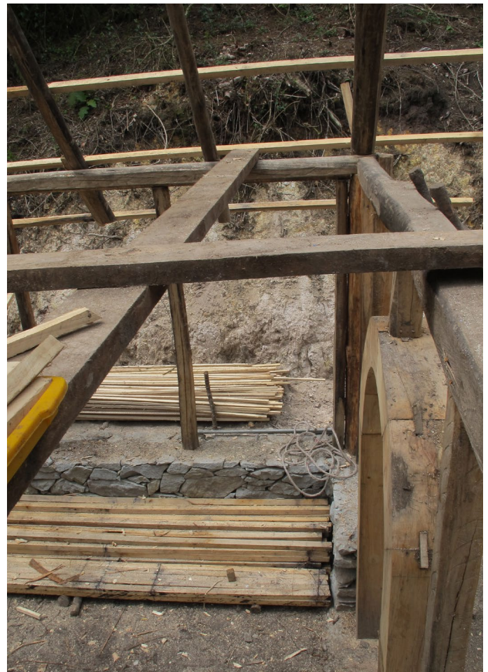
Foto_51: Diferentes maderas utilizadas en obra.
