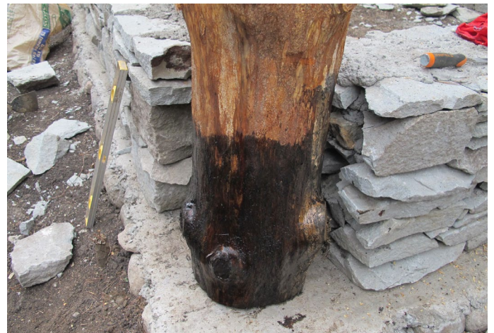
Foto_78: Se cura la base con aceite quemado + diesel.
