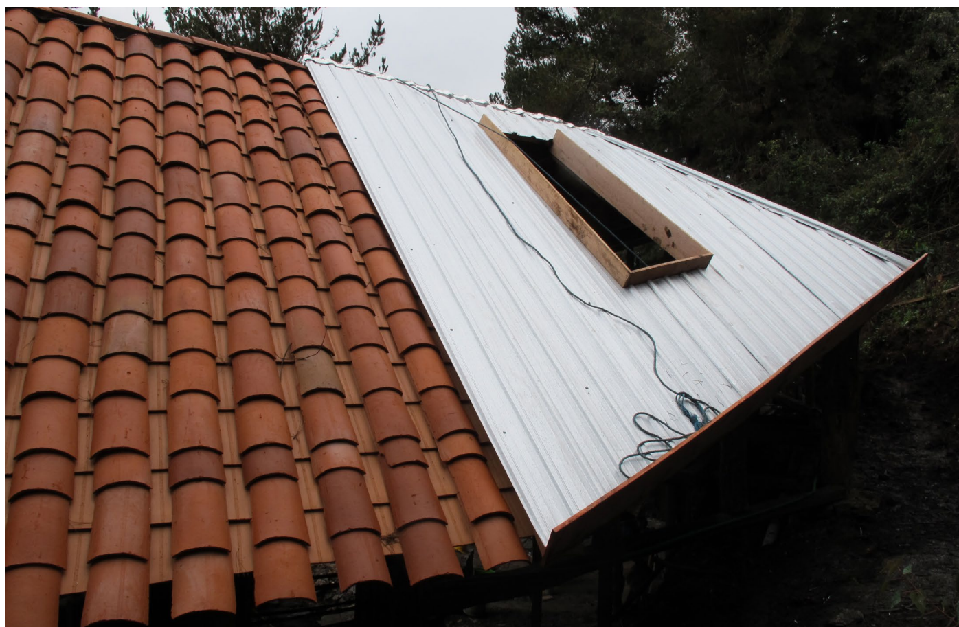
Foto_127: El encuentro del techo vivo con la cubierta de teja.
