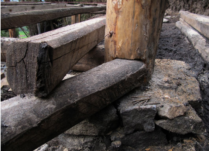
Foto_88: Unión de la viga, con la columna y el cemento.
