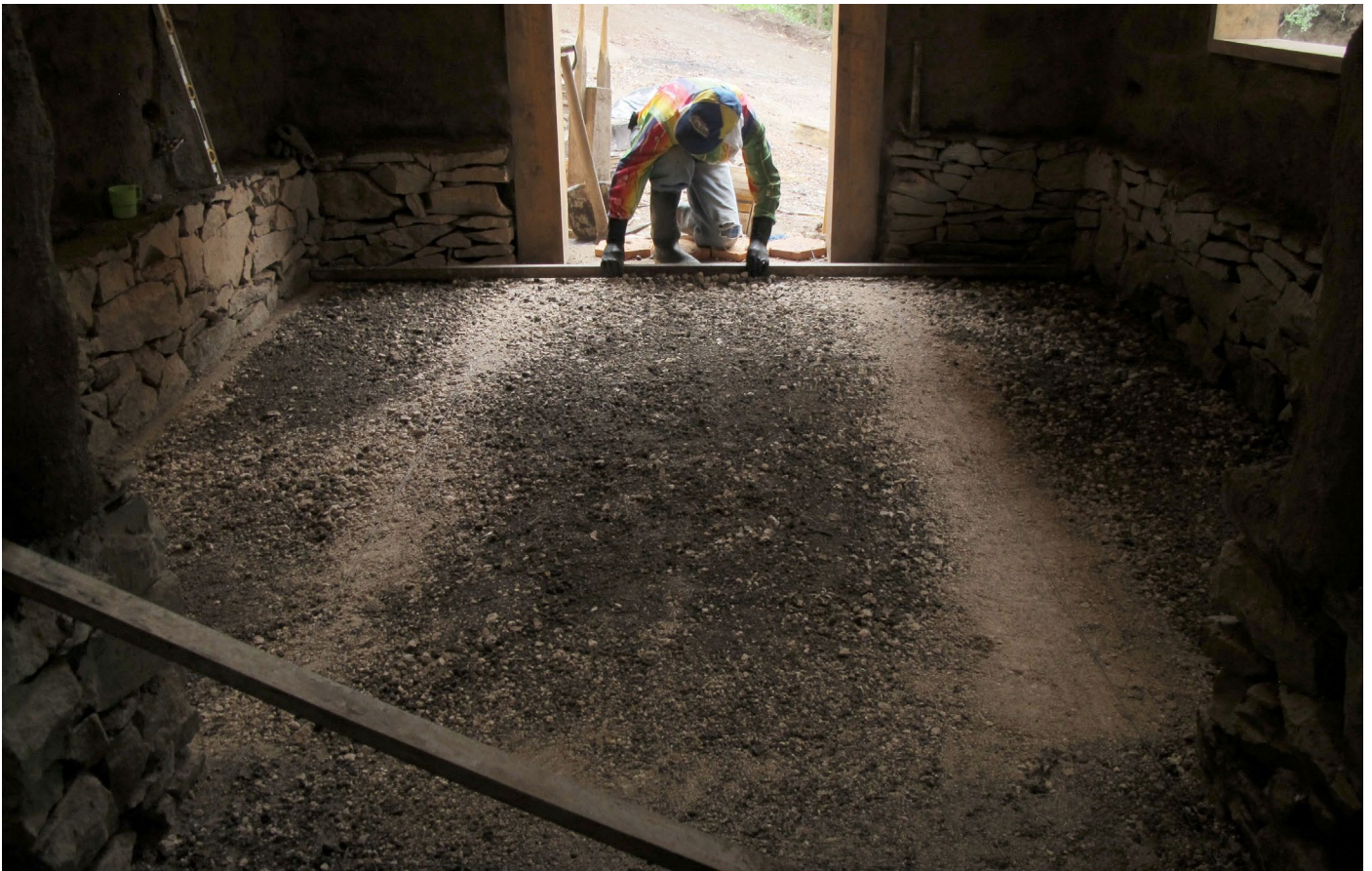
Foto_184: Luego de pasar un nivel (con piola) se apisona la tierra, se corrige la superficie con un codal, se coloca la arena, se vuelve a corregir el nivel de la superficie y se colocan los ladrillos, utilizando la arena para sellar las juntas.
