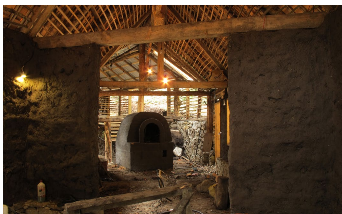
Foto_170: Revoque interior.
