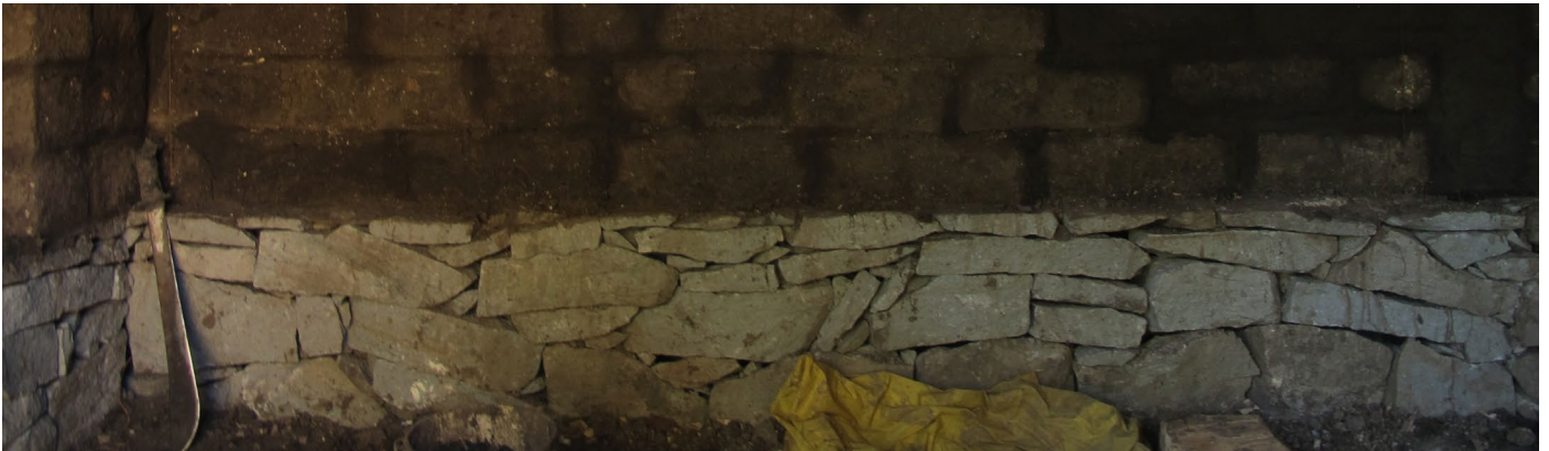
Foto_173: Mezcla de la piedra y el adobe para los muros.
