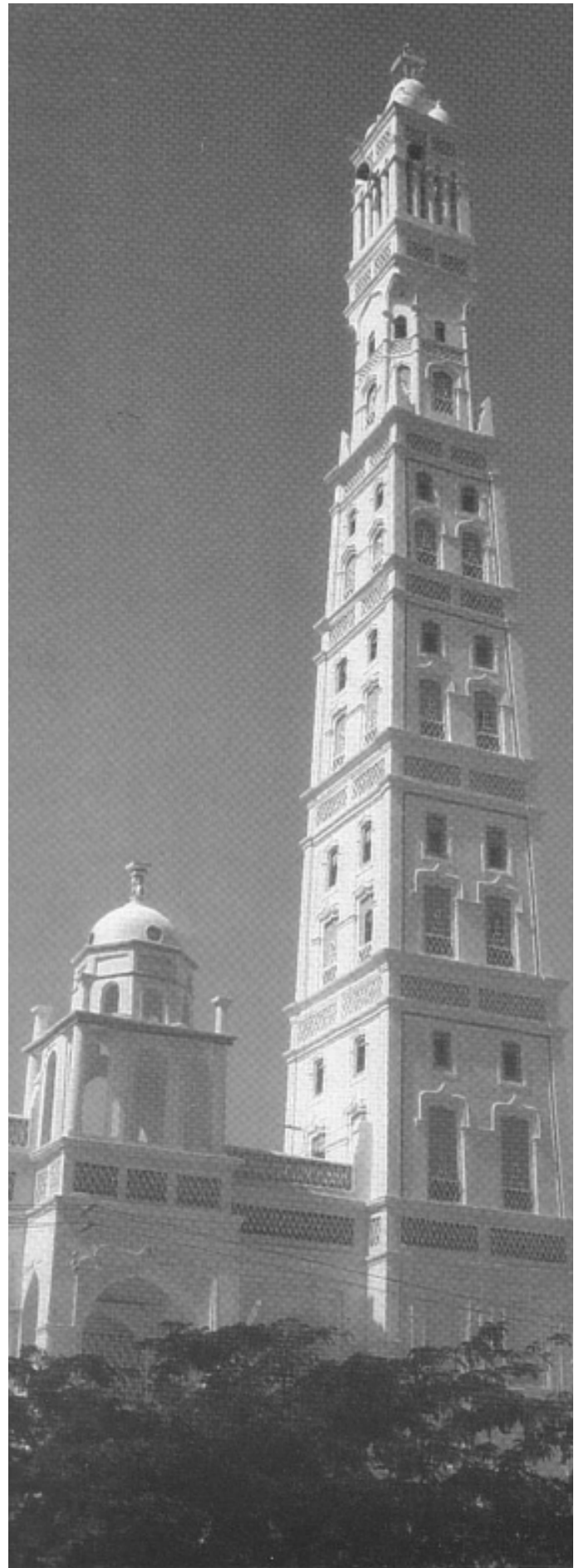
fig.01: Torre de la mezquita de Turim, Yemen, 38m de altura, construido de adobes hechos a mano. Minke, 2005, p.9.
