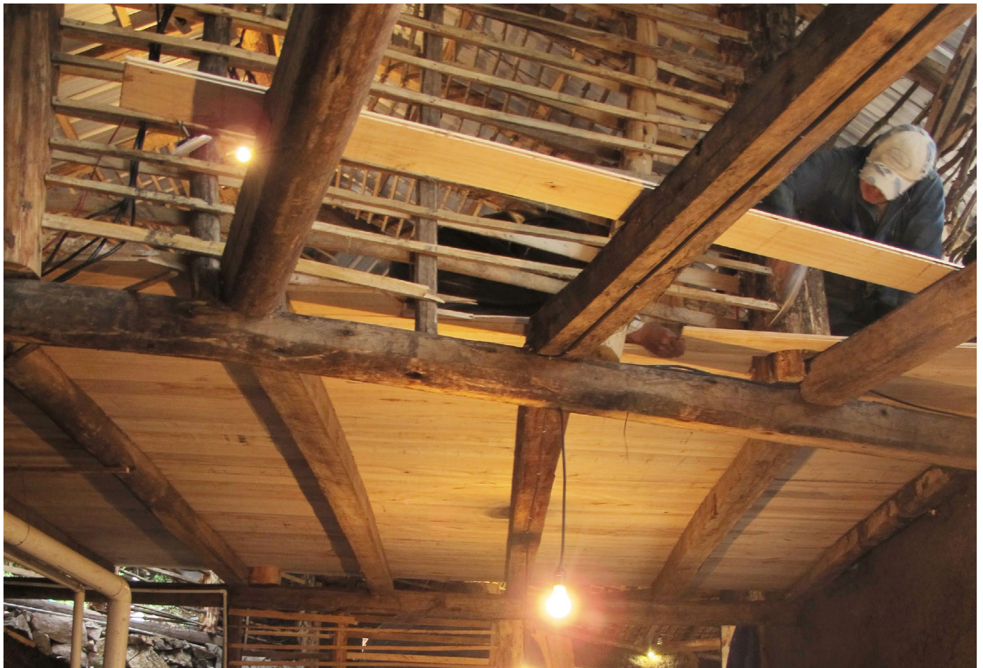
Foto_195: Proceso de la colocación del piso de madera.
