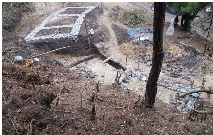
Foto_66: Relleno de la zanja.
