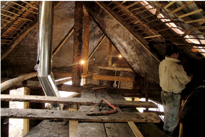
Foto_201: Construcción del cielo raso.
