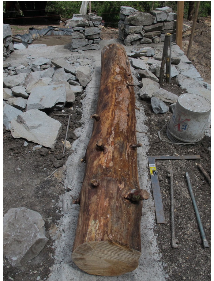
Foto_77: Columna de pino de 30cm de diámetro.
