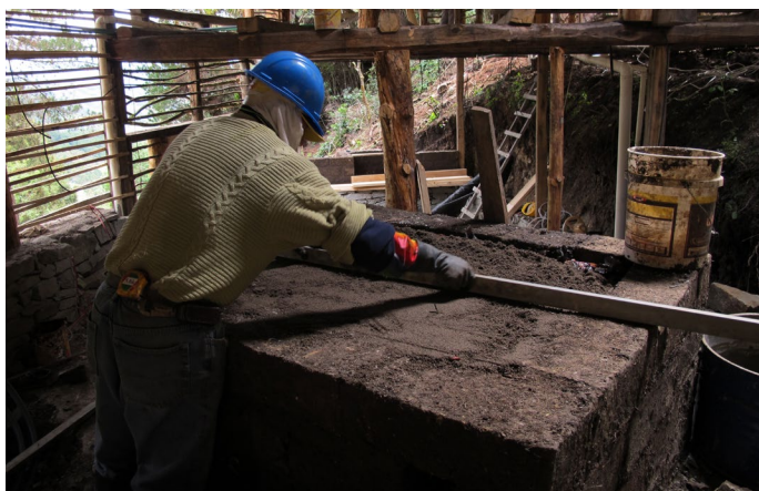
Foto_227: Nivelación de la base.
