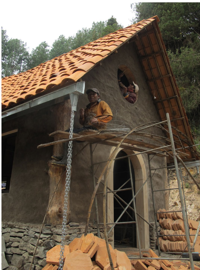
Foto_215: Canales y bajantes de agua lluvia.
