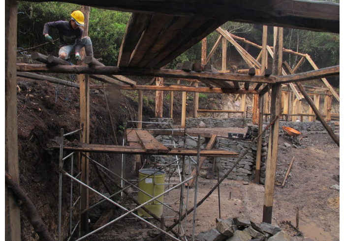
Foto_92: Envigado para el piso del nivel superior.
