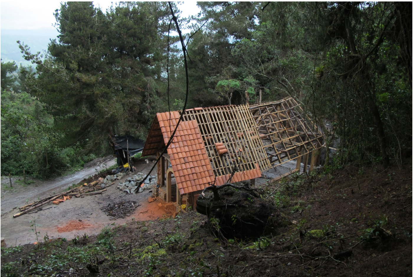
Foto_111: Se debe hacer pruebas con las dimensiones de la teja para determinar la distancia a la que deben ser colocadas las tirillas de eucalipto. Esta manera de construir una cubierta es tradició de las culturas locales.
