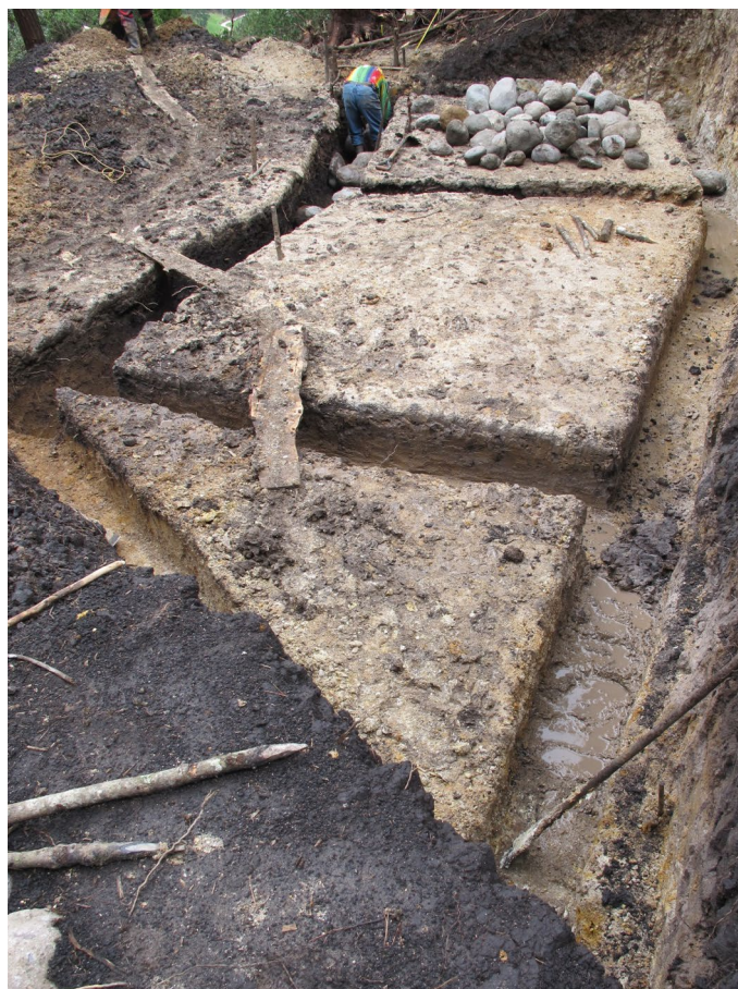
Foto_68: Zanja de cimentación, etapa 2.
