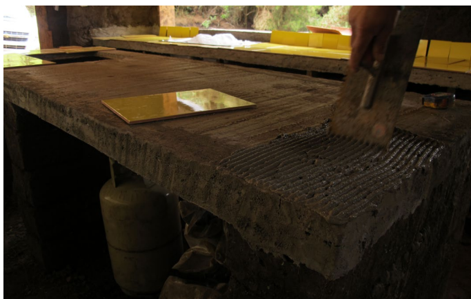
Foto_206: Proceso constructivo.
