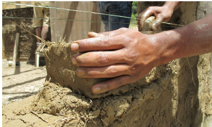
Foto_7: Construcción de adobe, Villa de Leiva, Colombia.
