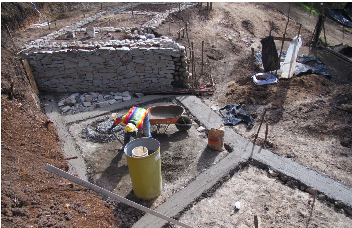
Foto_71: El proceso de relleno, fundición y fraguado de la cimentación.
