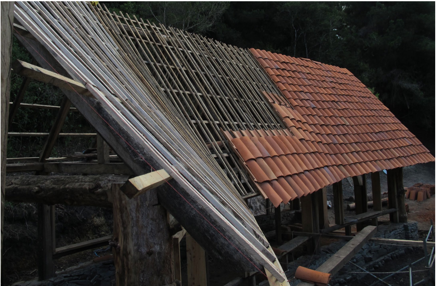
Foto_117: El entriado y entejado se pueden hacer simultáneamente, no se debe olvidar de curar las tirillas (con aceite quemado).
