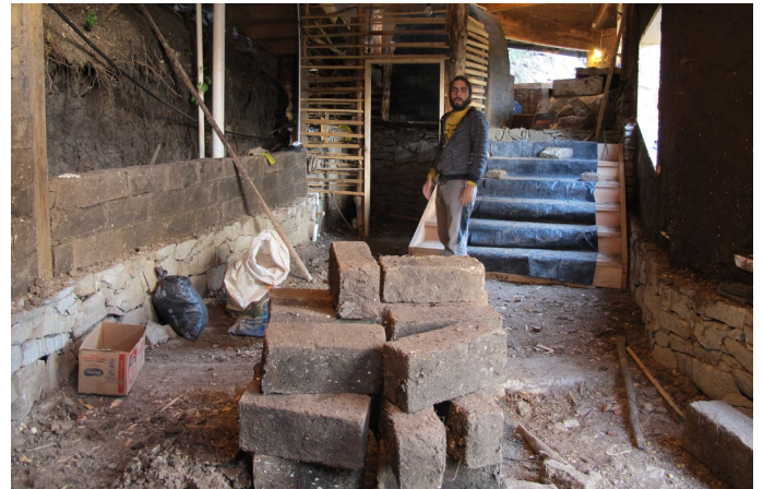
Foto_178: Muro de adobes.
