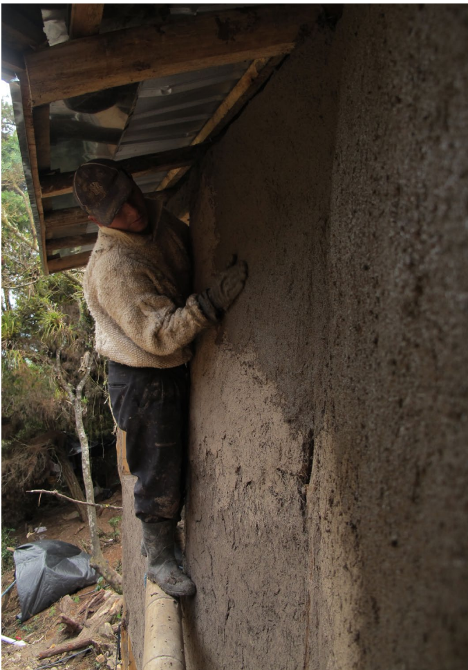
Foto_214: Colocación del revoque fino.
