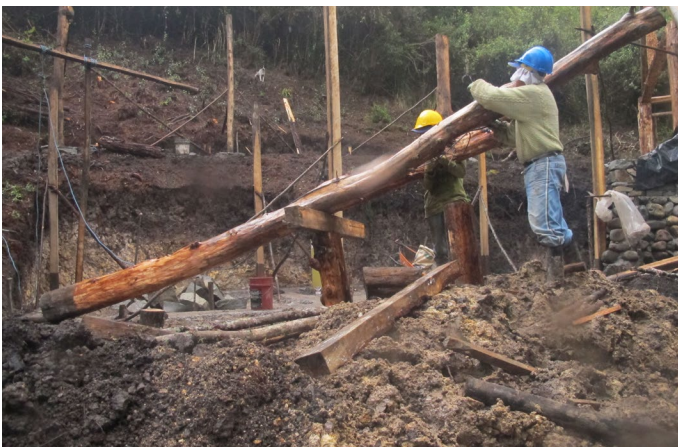
Foto_86: La columna mas larga de 7,50m.
