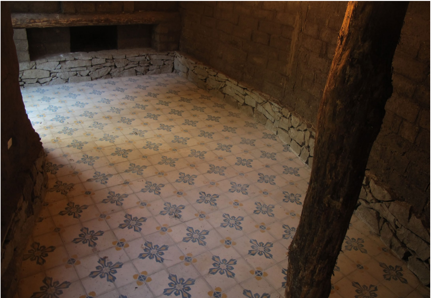
Foto_192: piso acabado.
