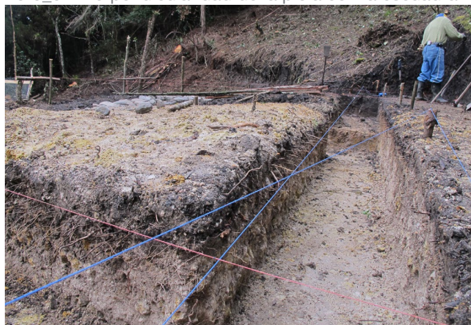
Foto_63: El trazado con piolas de colores.
