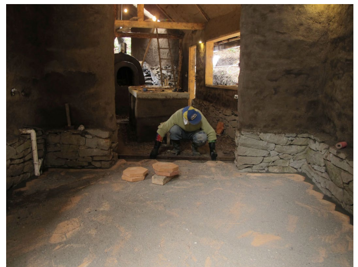
Foto_186: Colocación del piso de ladrillo.
