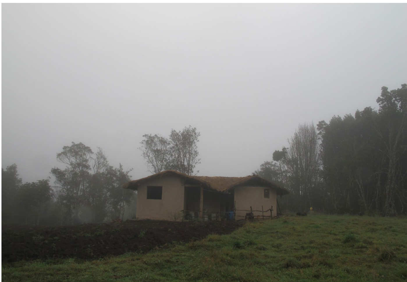
Foto_10: Construcción de adobe, Victoria del Portete, Tarqui.
