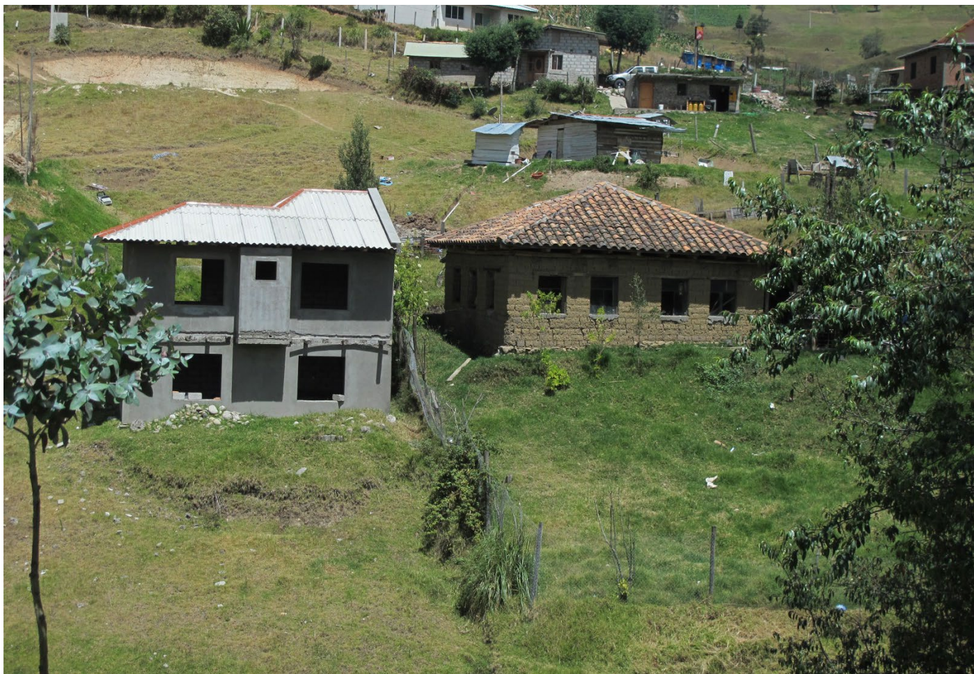
Foto_8: Construcción con materiales industriales - construcción de adobe, San Vicente, Tarqui.
