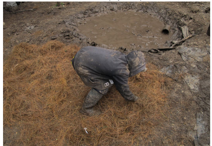
Foto_163: paja/fibra se utilizó las hojas secas del pino (pinocha)
