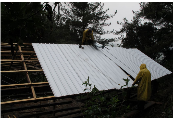
Foto_123: Se trabaja con arnes y cuerdas de seguridad.
