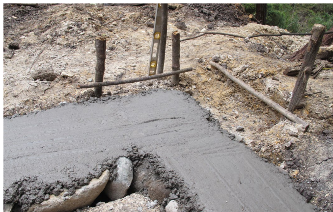
Foto_69: Para nivelar se coloca una capa de hormigón.
