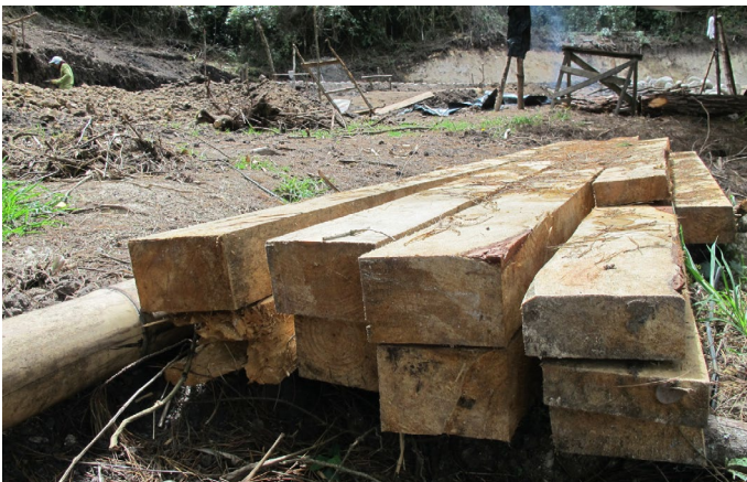
Foto_49: La madera secada, curada y colocada en obra.
