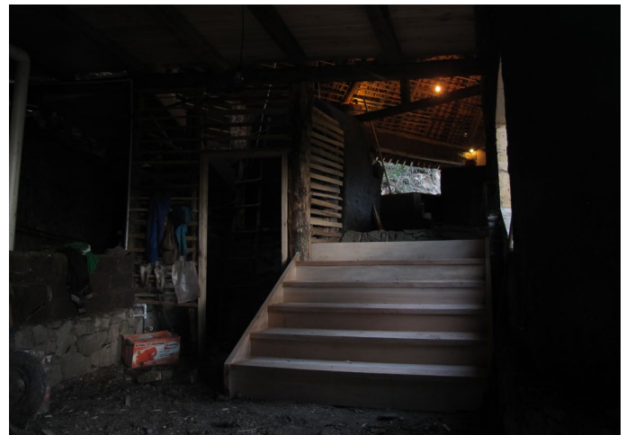
Foto_37: Escaleras del nivel inferior.
