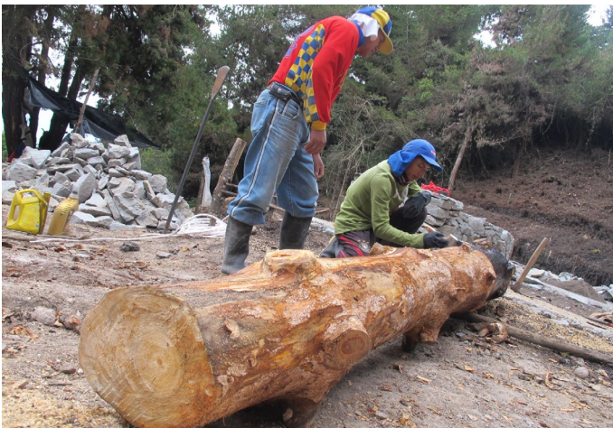
Foto_50: Tronco para columna de pino.
