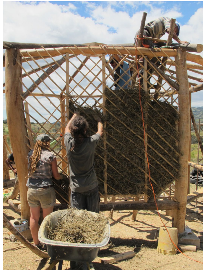
Foto_11: Construcción de bahareque, Villa de Leiva, Colombia.
