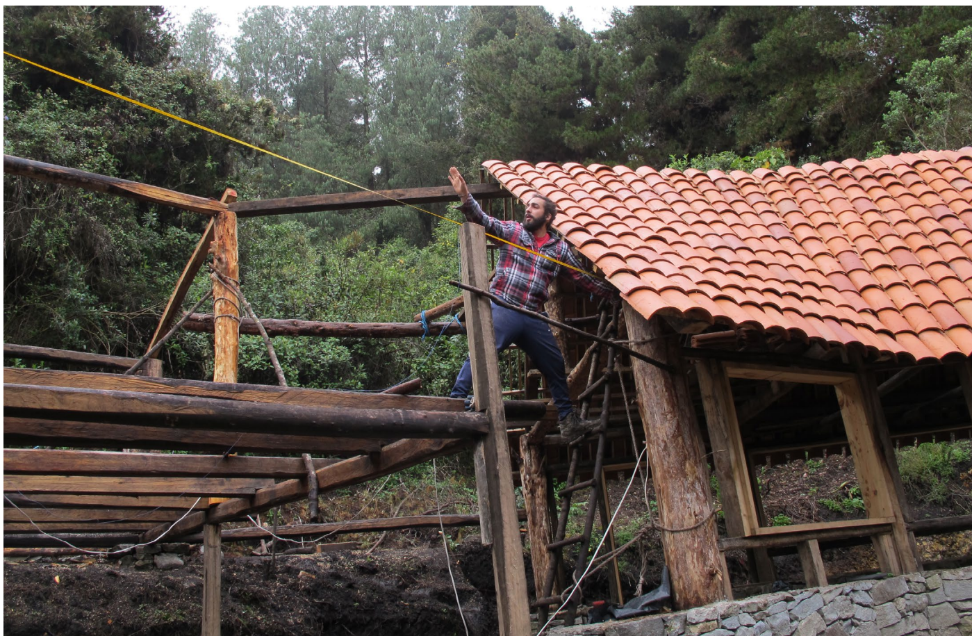
Foto_104: La segunda etapa de la estructura, la construcción y el diseño se fueron adaptando a la topografía y forma del terreno.
