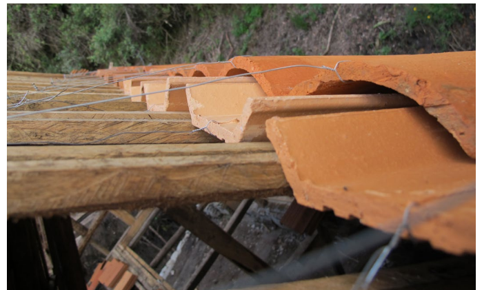
Foto_116: teja artesanal tiene variaciones en sus dimensiones.
