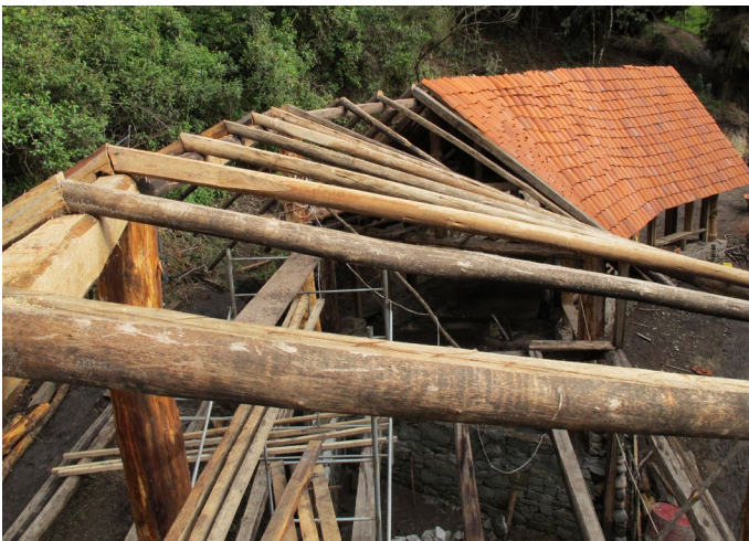
Foto_106: Armado de los tirantes para el techo vivo.
