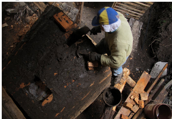
Foto_233: Sellado de la bóveda.
