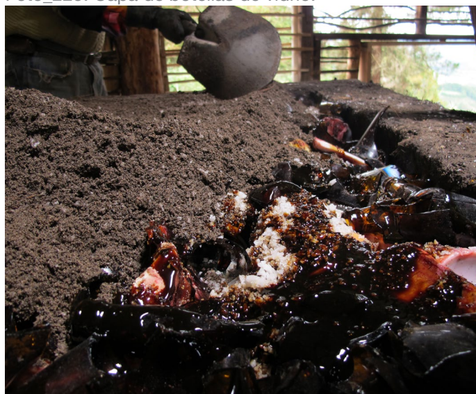
Foto_226: Colocación de la capa final de arena.
