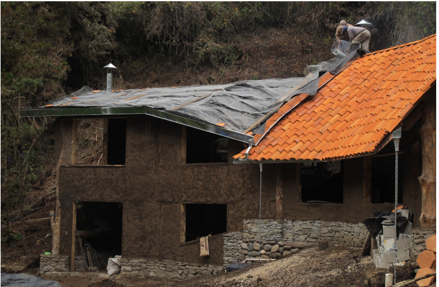
Foto_213: Secado del revoque en el exterior.
