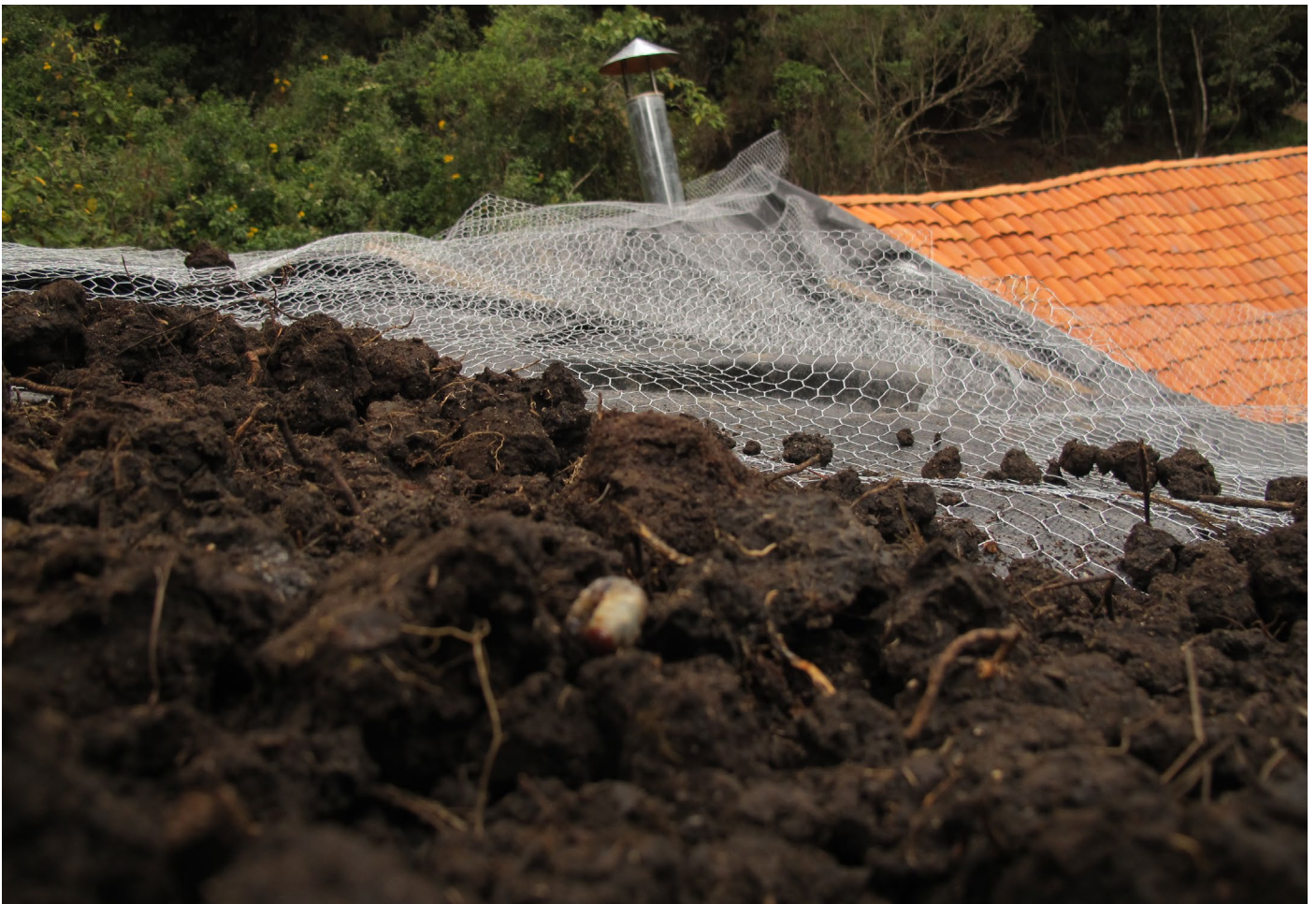
Foto_130: La malla debe quedar bien asegurada, para luego poner la capa de tierra orgánica.
