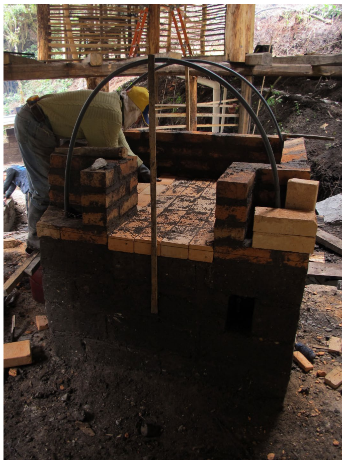
Foto_231: Armado de la bóveda.
