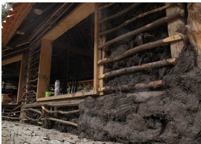
Foto_171: Detalle del revoque.
