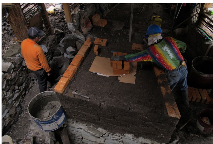
Foto_229: Colocación de los ladrillos.
