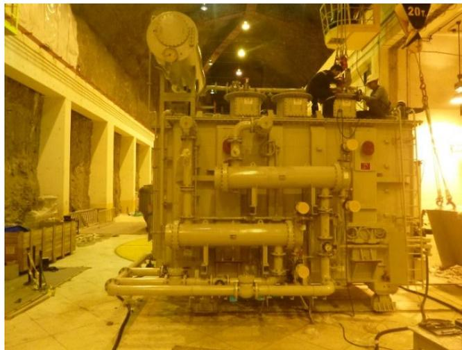
**Figura 21 Reemplazo de transformador, Unidad 4**
