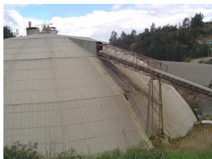
Figura 6. Prehomogenizador de la Planta Industrial Guapán.
