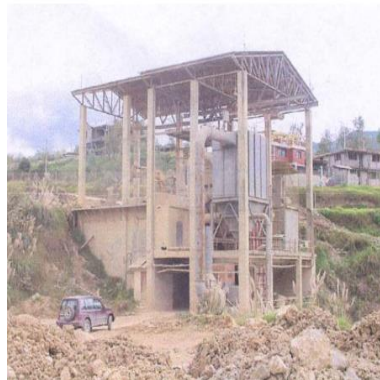
Figura 5. Máquina de Trituración de la Planta Industrial Guapán.
