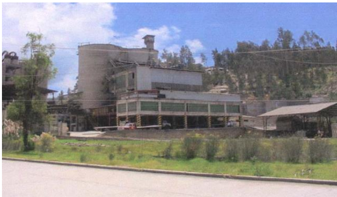
Figura 12. Almacenaje y Empaque de Cemento de la Planta Industrial Guapán.
