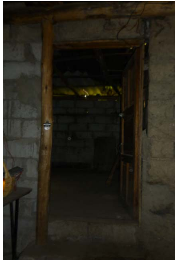
Ingreso a las habitaciones
