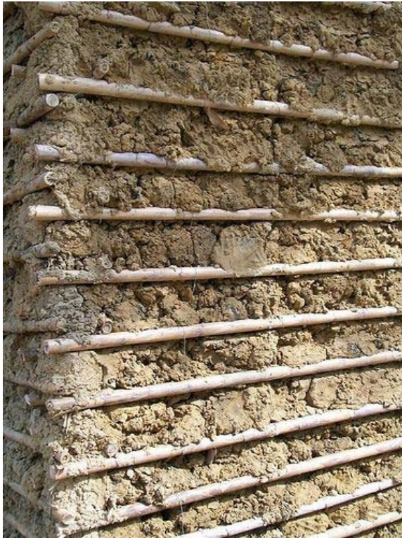
Figura 123. Muro de Bahareque.
