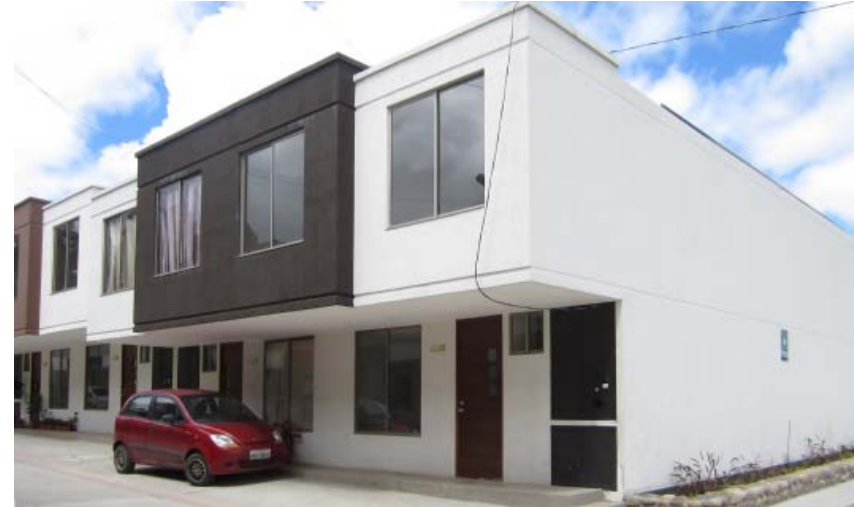
Figura 164. Fachada frontal de vivienda tipo.
