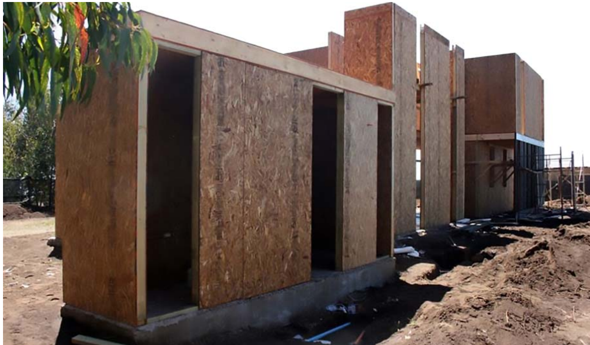
Figura 132. Casa en Panel SIP en proceso de construcción.
