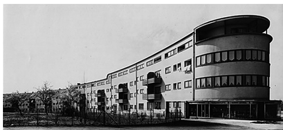
Figura 23. Vista de uno de los bloques curvos.
