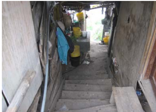
Ingreso a la vivienda
