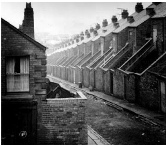
Figura 11. Vivienda Obrera en Newcastle, Inglaterra.
