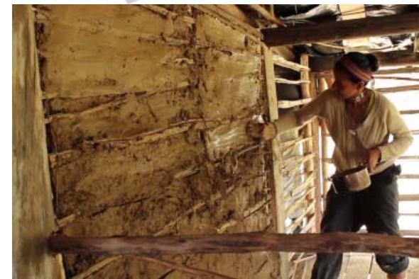
Figura 126. Construcción de un muro interior de Bahareque.
