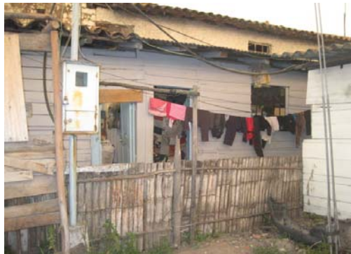
Ingreso a la vivienda
