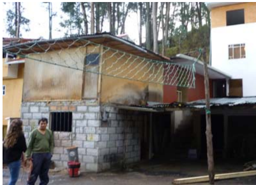
Vista principal de la vivienda
