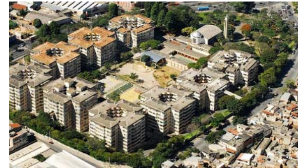
Figura 52. Conjunto de Vivienda IAPI (Instituto de Jubilaciones y Pensiones de Trabajadores Industriales) Belo Horizonte, 1944.
