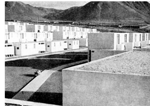
Figura 43. “Operación Sitio”: Población Conchalí, 1965-1966. 450 viviendas fueron construidas por 2.000 personas junto a empresas privadas que proveían sistemas prefabricados de placas y pilares de hormigón para algunas casas, y pino y yeso-cartón para otras.
