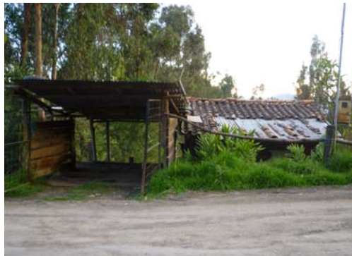
Ingreso a la vivienda
