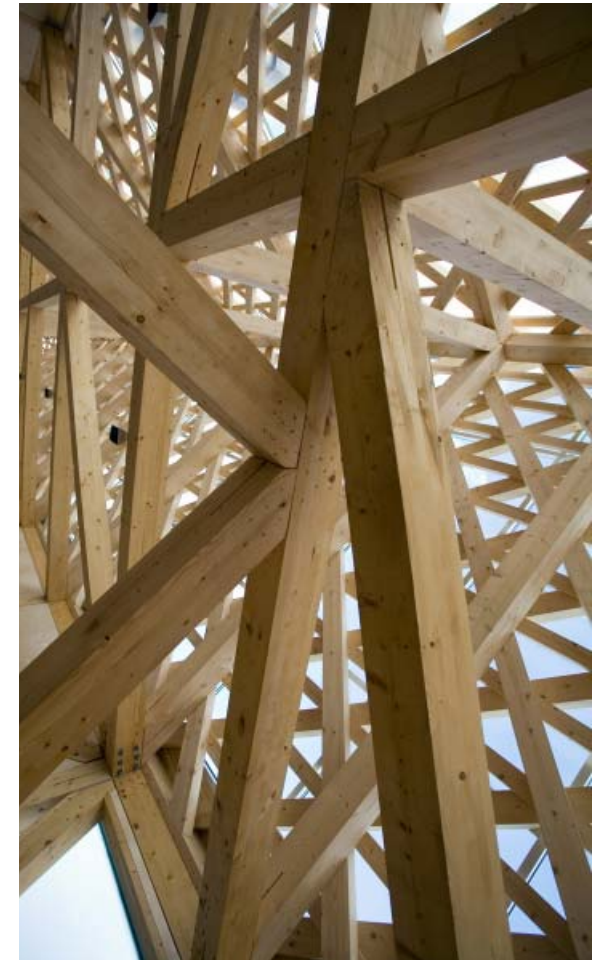
Figura 98. Estructura de Madera Laminada.
