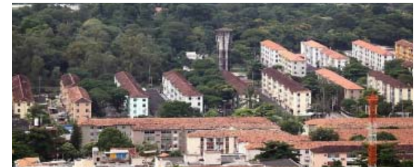
Figura 53. IAPI da Penha, con 1248 unidades en 44 bloques, Rio de Janeiro 1949.
