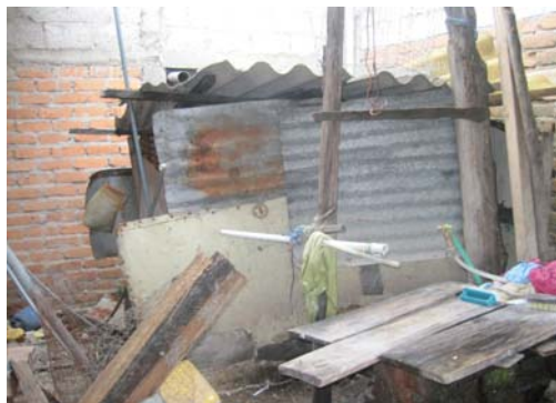
Vista exterior del baño
