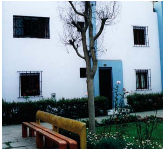
Figura 188. Fachada frontal de la vivienda.
