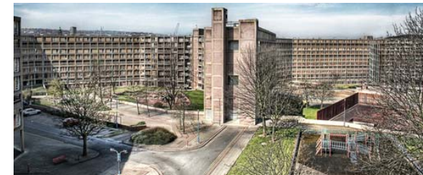
Figura 14. Conjunto Park Hill, Sheffield, South Yorkshire, Inglaterra, 1957-1961.
