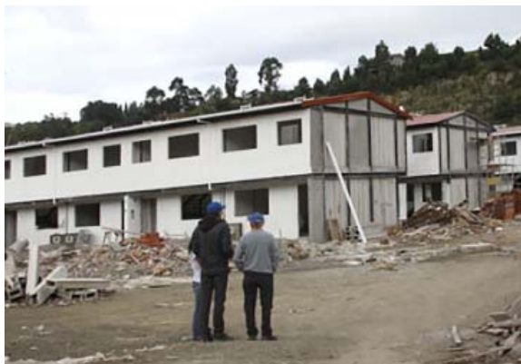
Figura 66. Proyecto en construcción.
