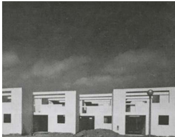
Figura 185. Vista exterior de las viviendas.
