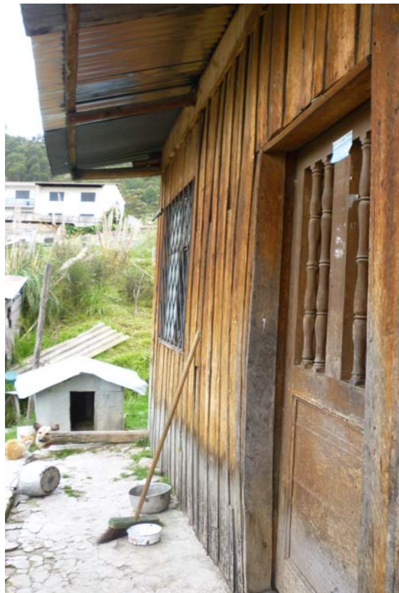
Ingreso a la vivienda
