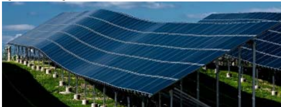
Figura 248. Energía Solar Fotovoltaica.
