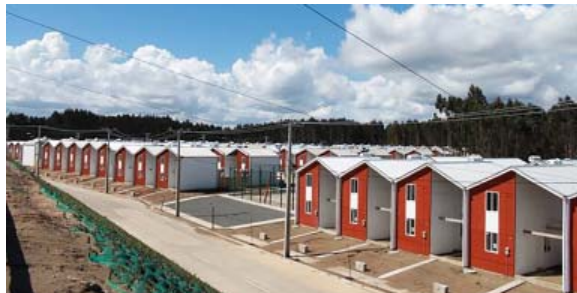
Figura 200. Vista general del conjunto.
