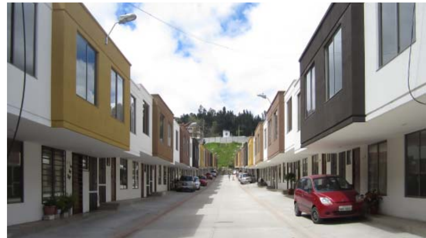
Figura 165. Fachada frontal de vivienda tipo.
