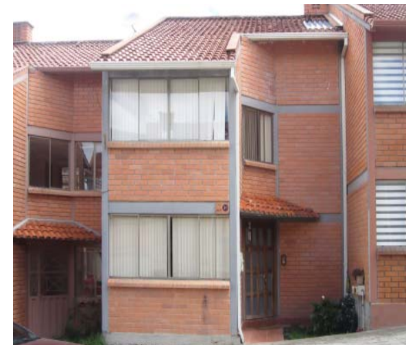
Figura 181. Fachada frontal de vivienda en T.
