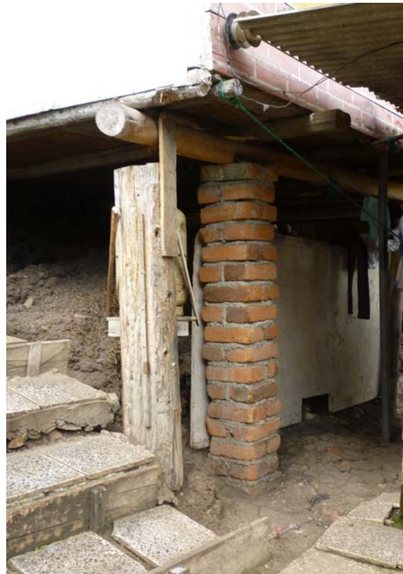
Estructura de la vivienda
