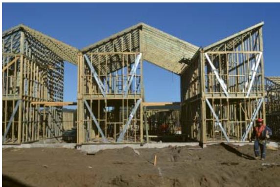
Figura 137. Estructura de las viviendas.
