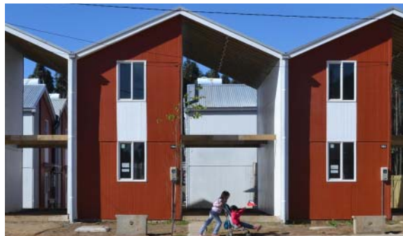
Figura 201. Fachada frontal de vivienda tipo.
