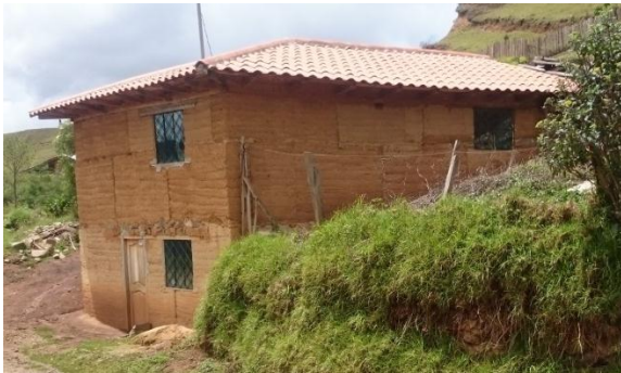
Estructura soporte tapial Fuente: fotografía 8 Francisco Oviedo
