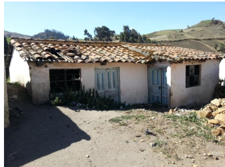
Construcción casa adobe madera teja Fuente: fotografía 4 Francisco Oviedo
