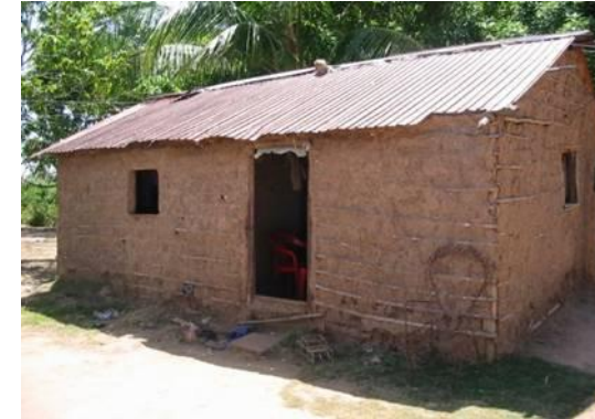
Estructura madera pared bahareque fotografía Ministerio AGAP
