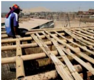
16. apoyo vigueta sobre viga 17. colocación de caña picada
