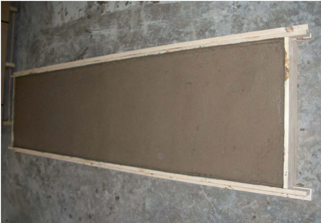
Se elaboran juntas entre la madera y el barro para evitar fisuras entre estos
