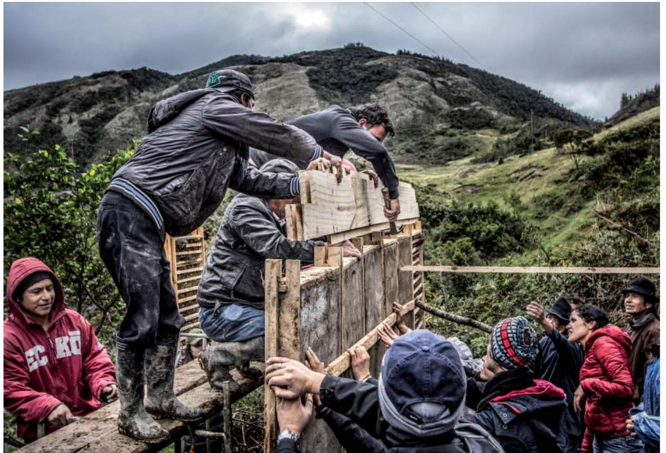
37. Colocando viga prefabricada (Saraguro)
