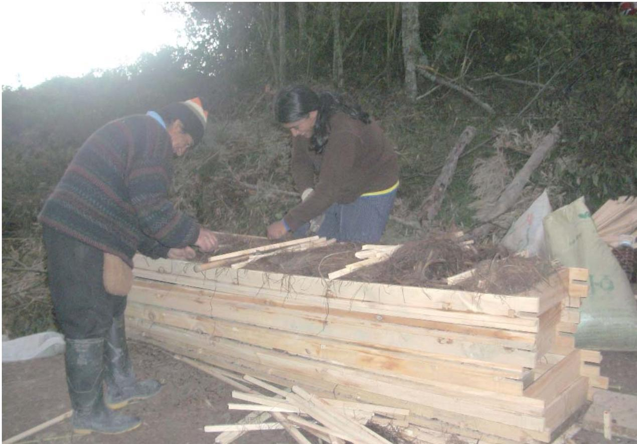
Colocando aislante de fibras al panel
