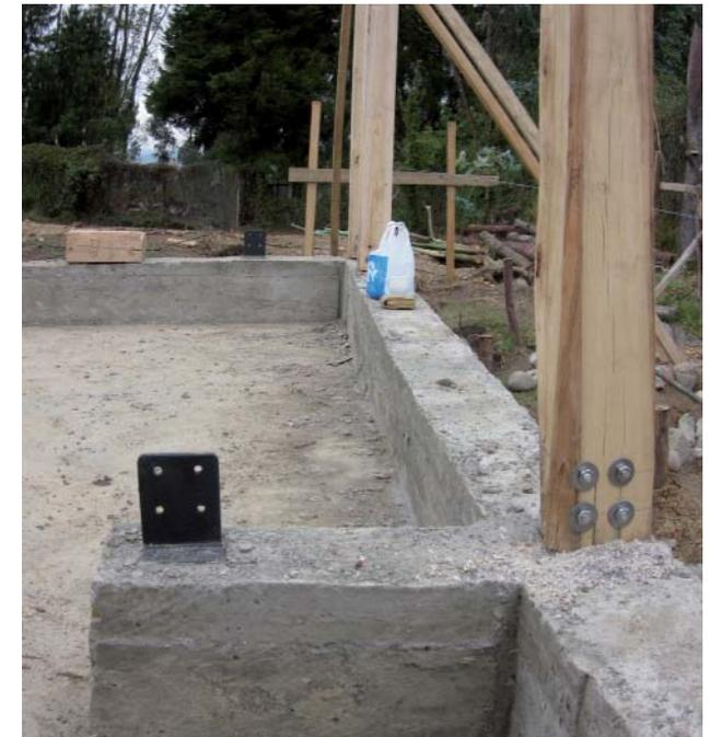
5. fotografía de anclaje metálico y viga de cimentación
