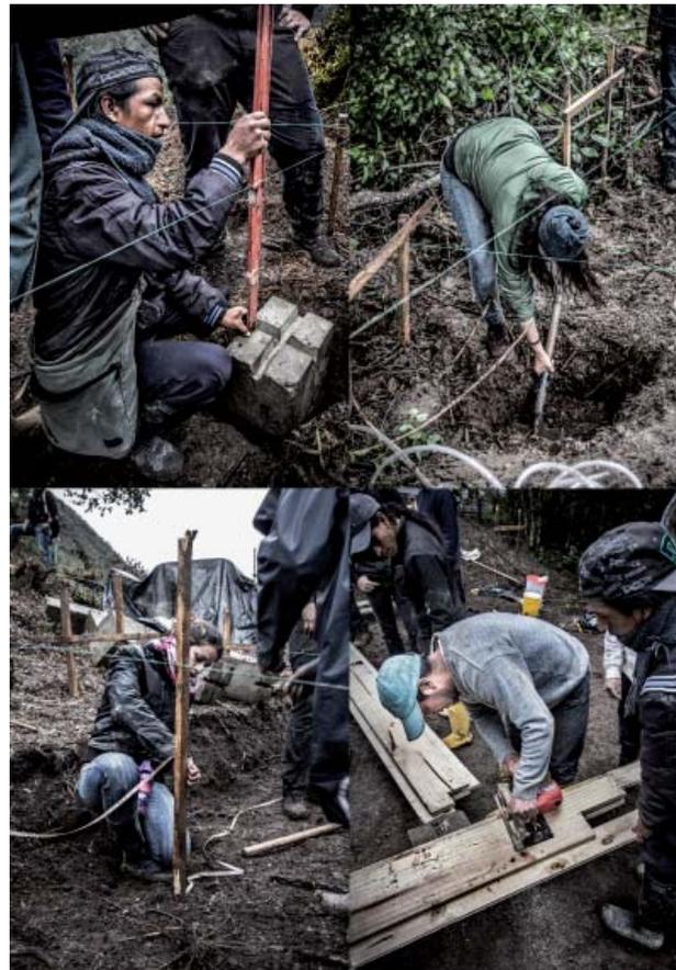
33. colocando basas y vigas prefabricadas
