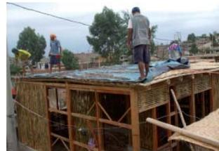
18. colocación estera de caña 19. colocación lámina plástica
