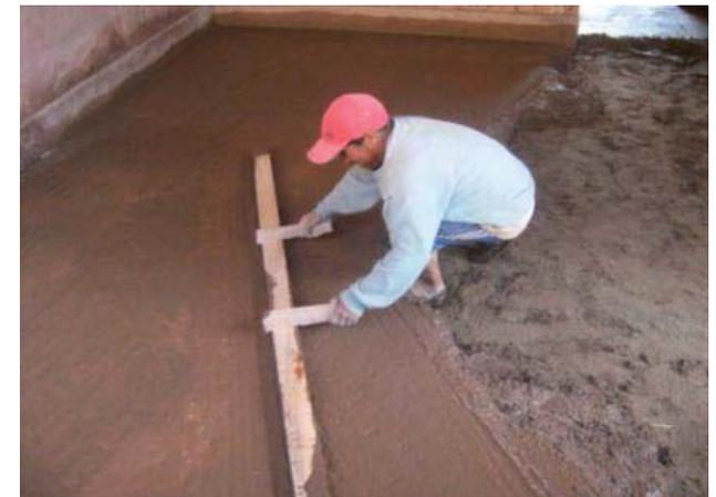
21. colocación de hormigón
