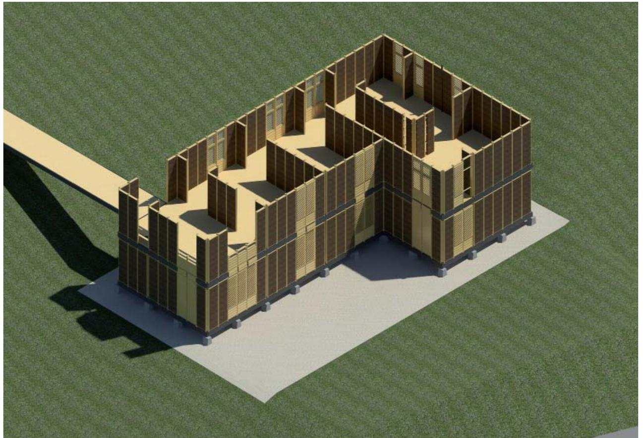
8. Colocando módulos prefabricados de pared sobre vigas de contrapiso
