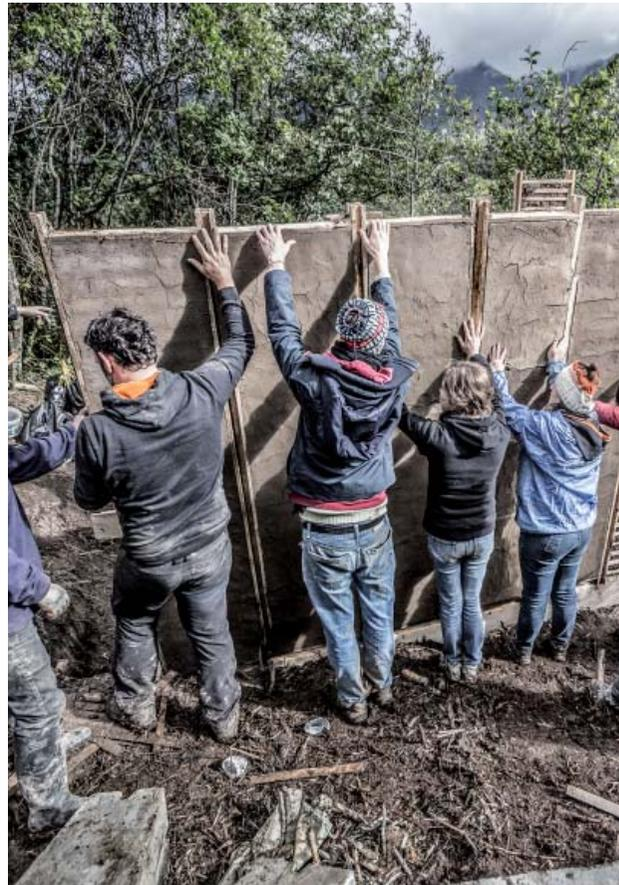
36. colocando paneles prefabricados de bahareque
