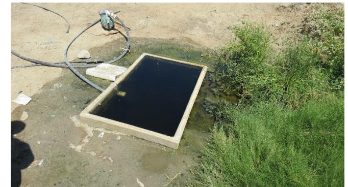
FOTOGRAFÍA N° 3.34 ISLA PONGALILLO – CANTÓN SANTA ROSA Pozo de Agua semi-tratada (Agua Filtrada de Mar)
