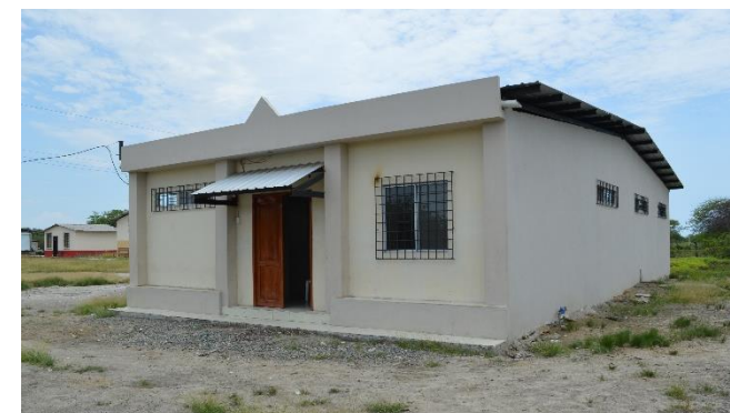
FOTOGRAFÍA N° 3.50 ISLA PONGALILLO – CANTÓN SANTA ROSA Casa Comunal
