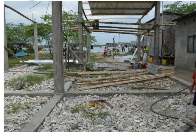
FOTOGRAFÍA N° 1.19 ISLA PONGALILLO – CANTÓN SANTA ROSA Edificación en construcción
