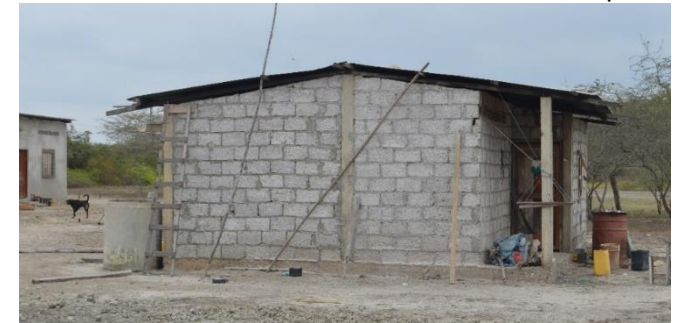
FOTOGRAFÍA N° 1.22 ISLA PONGALILLO – CANTÓN SANTA ROSA Viviendas tipo villa
