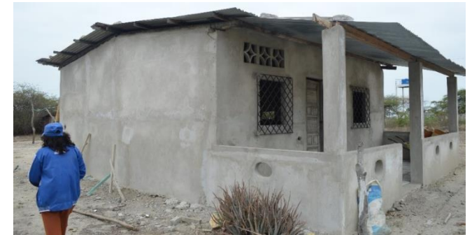
FOTOGRAFÍA N° 1.24 ISLA PONGALILLO – CANTÓN SANTA ROSA Vivienda con cubierta de zinc
