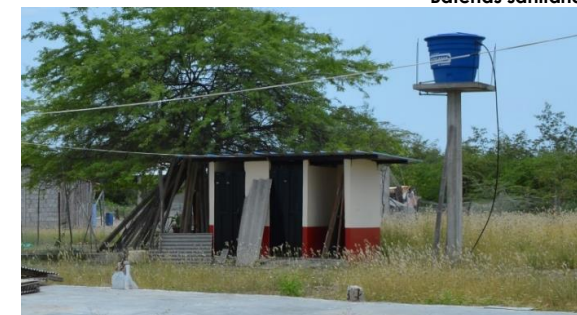
FOTOGRAFÍA N° 3.41 ISLA PONGALILLO – CANTÓN SANTA ROSA Baterías sanitarias
