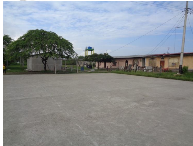
FOTOGRAFÍA N° 2.05 ISLA PONGALILLO – CANTÓN SANTA ROSA Local a readecuar – Cancha de uso múltiple
