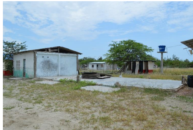
FOTOGRAFÍA N° 1.11 ISLA PONGALILLO – CANTÓN SANTA ROSA Baterías Sanitarias
