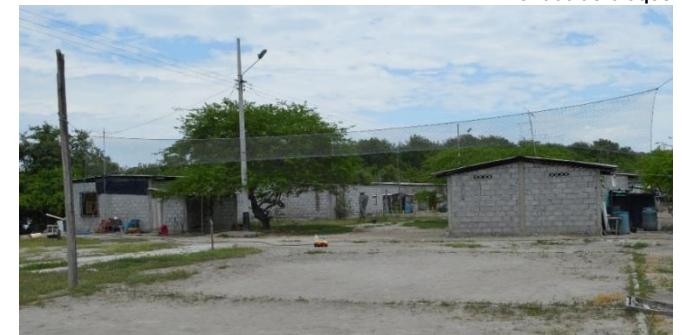
FOTOGRAFÍA N° 1.25 ISLA PONGALILLO – CANTÓN SANTA ROSA Viviendas de bloque
