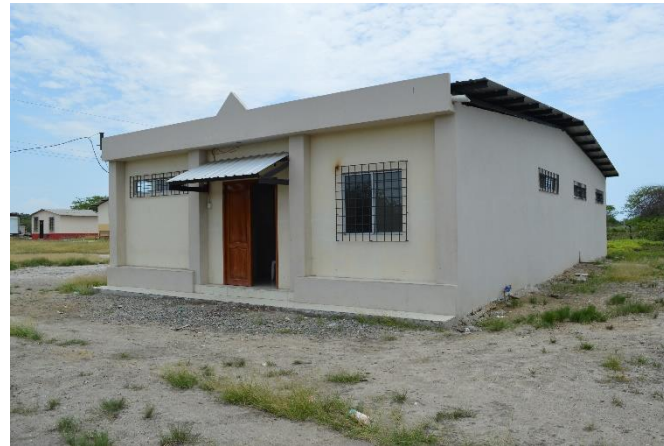
FOTOGRAFÍA N° 1.13 ISLA PONGALILLO – CANTÓN SANTA ROSA Casa Comunal
