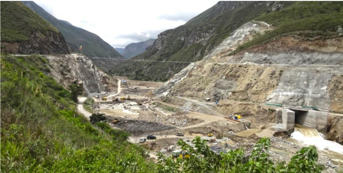
Gráfica 3.12: Construcción presa proyecto Minas – San Francisco (MEER, 2015)
