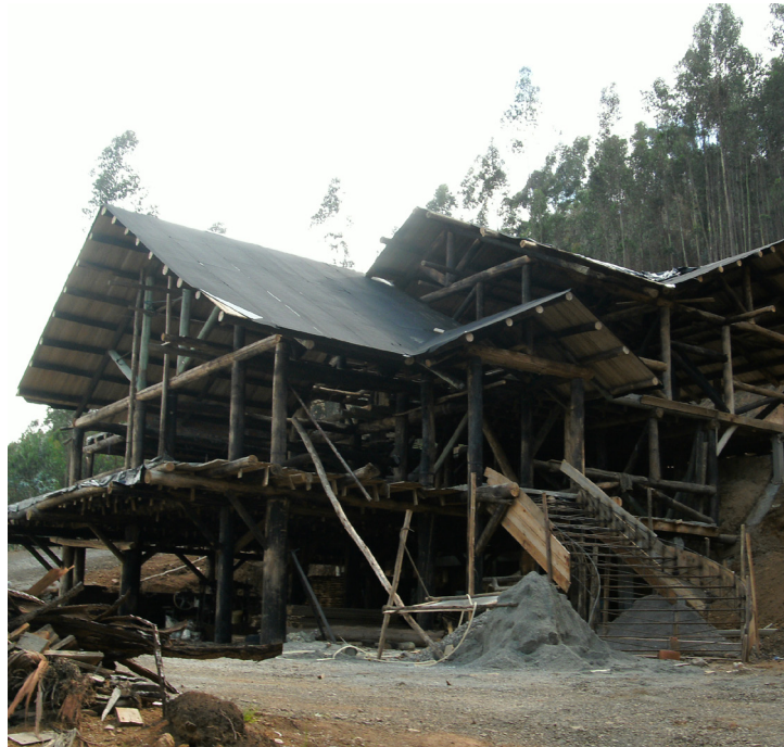
fig 29 Estructura de la Vivienda
