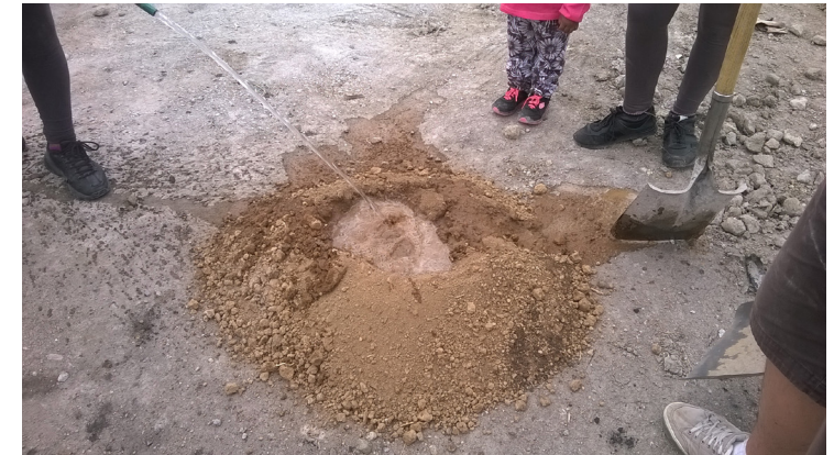
fig. 18a - Dosificación para adobes, tierra Sector Baños.
