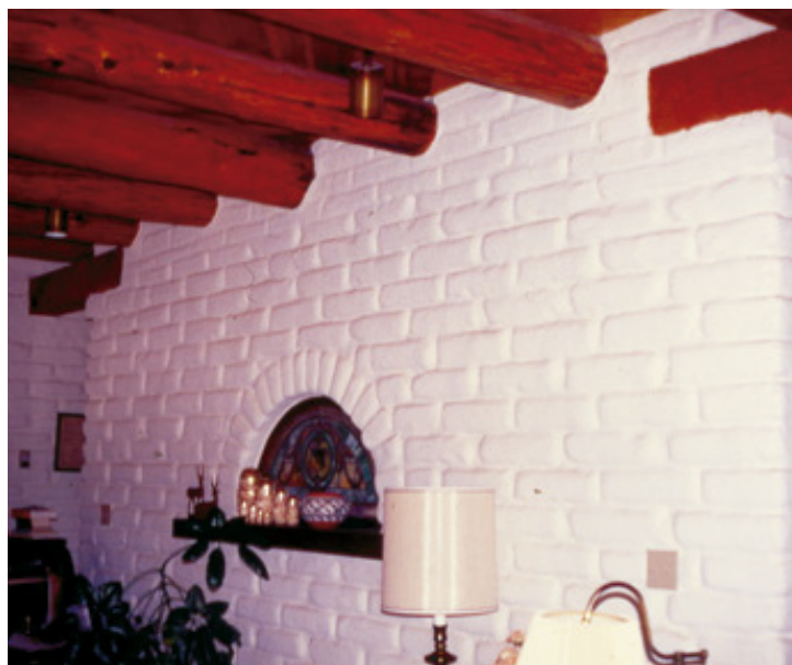
fig. 28 Muro visto de Adobe Prensado con impregnaciones superficiales
