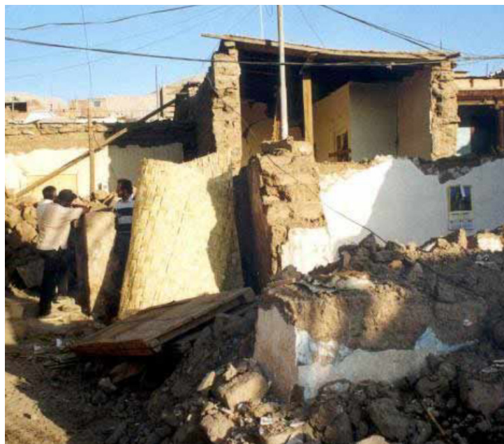
fig. 61 - Construcciones de Adobe después de un Sismo. Pisco, Perú
