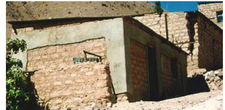
fig. 75 Vivienda de Adobe con reforzada con malla electrosoldada, Perú
