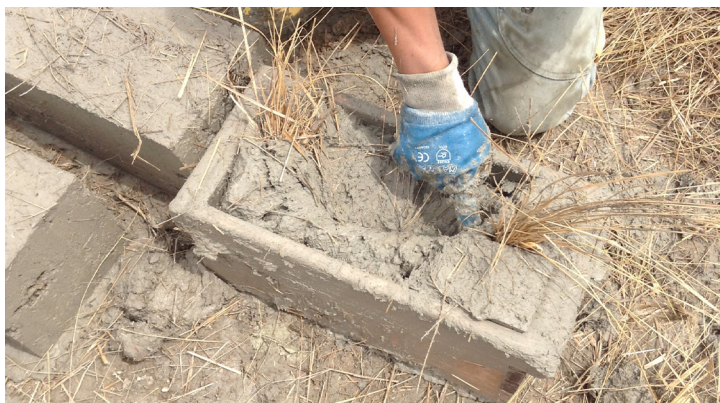
fig. 15 - Fabricación del adobe.
