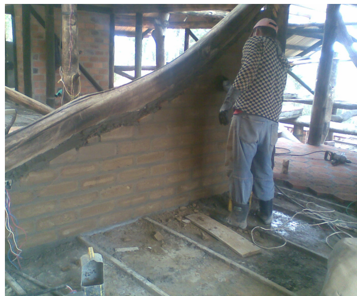
fig. 39 Proceso de construcción de Muros
