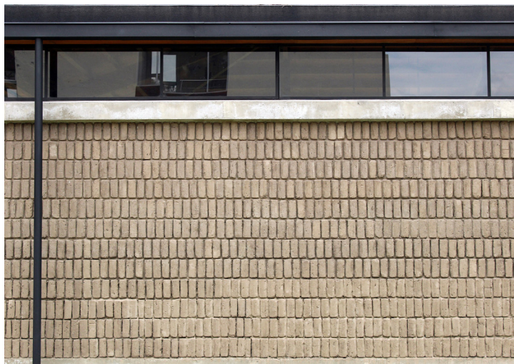
fig. 39 - Muro con adobes dispuestos de Canto
