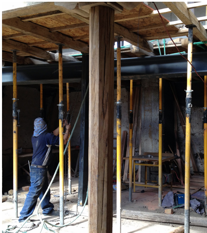
fig. 62 Estructura metálica de Refuerzo
