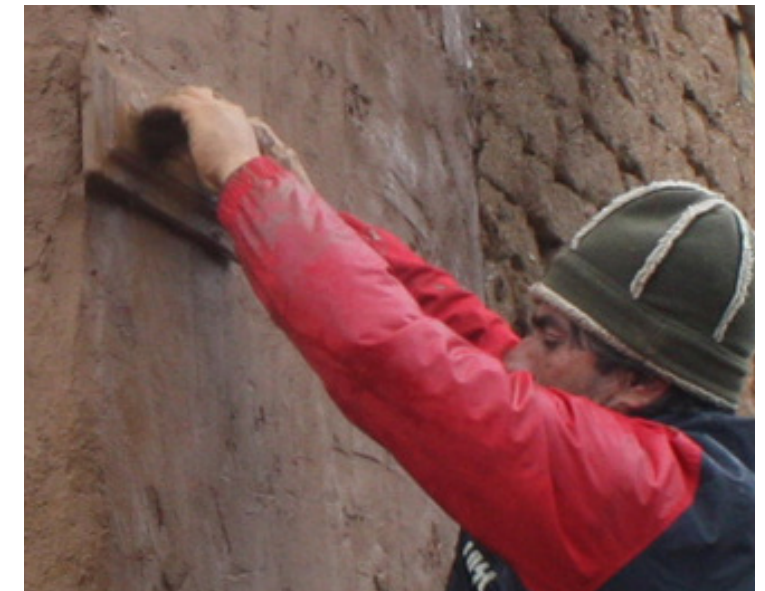
fig. 29 Muro visto de Adobe Prensado con impregnaciones superficiales
