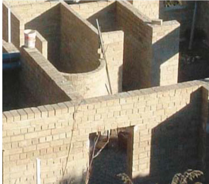
fig. 59 - Muros Cannabric terminados
