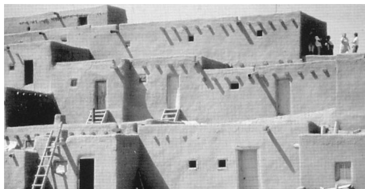
fig. 3 - Viviendas tradicionales de tierra de los Indios Pueblos Taos, Nuevo Mexico, Estados Unidos.
