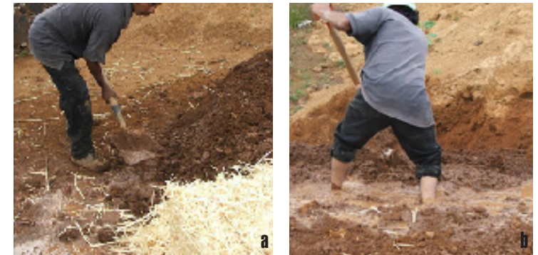
fig. 31 - Estabilización y mezclado del Adobe.
