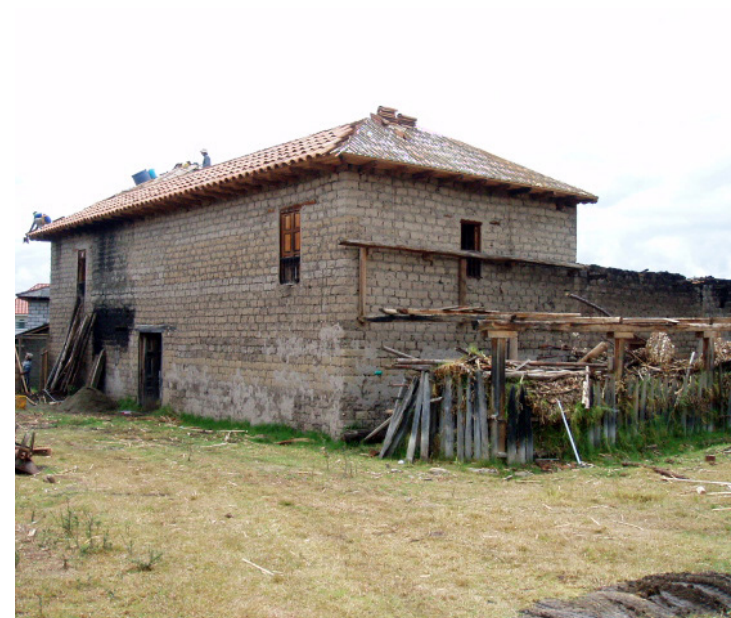
fig. 48 Antes de la restauración, fachada este
