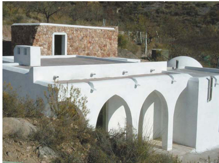
fig. 60 - Vivienda con Cannabric finalizada, muros revestidos con lechada de cal.
