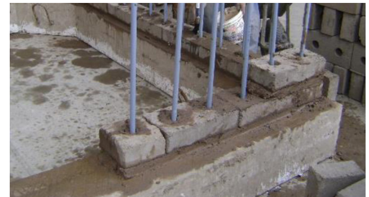
fig. 84 - Muro reforzado usando tubos PVC
