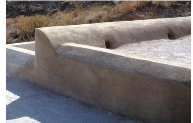
fig. 56 - Remate con Mortero de barro y cal
