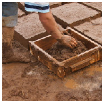
fig. 34- Vertido de la mezcla en los moldes.
