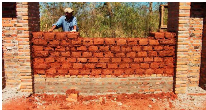
fig. 54 - Cerramiento de Adobe en módulos 2 y 3
