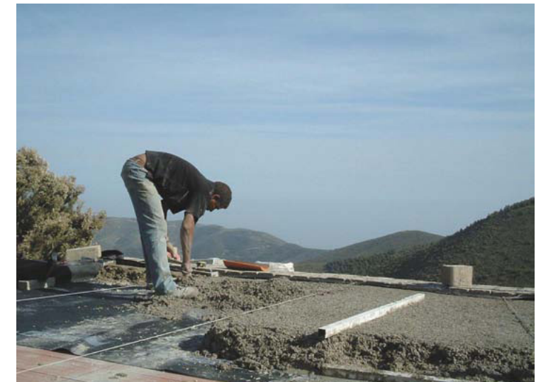
fig. 57 - Recubrimiento de cubierta con mortero de barro y cal
