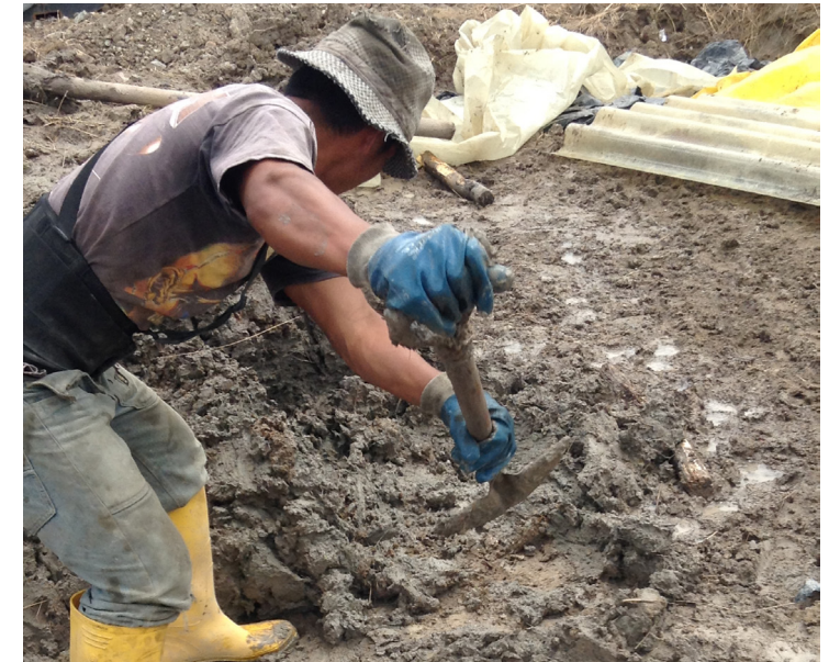
fig. 14 - Mezclado manual
