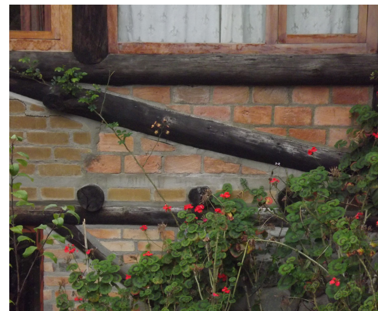
fig. 43b Unión entre bloques de tierra y bloques de arcilla
