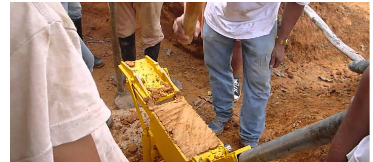
fig. 83 - Prensa para realizar bloques de tierra alveolares
