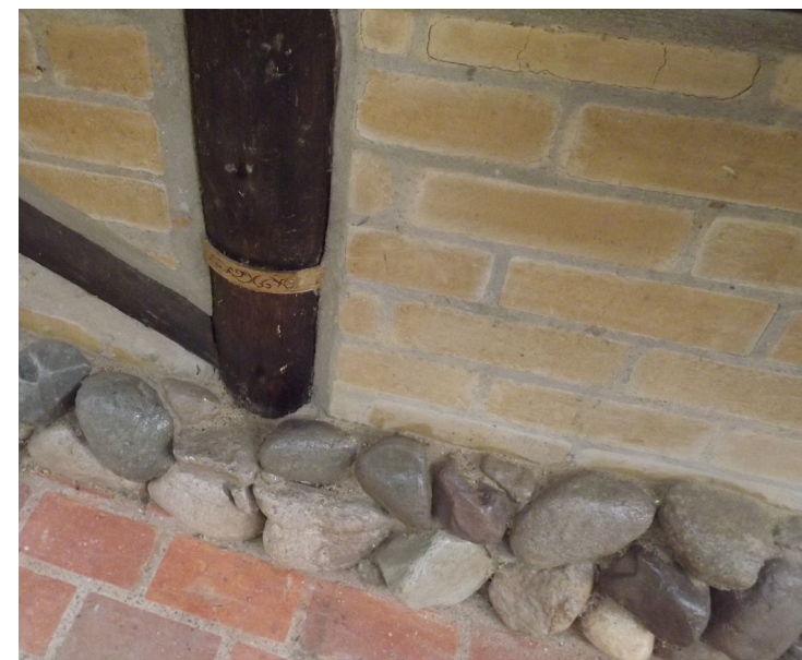
fig. 40a Muro Terminado de Adobe Prensado
