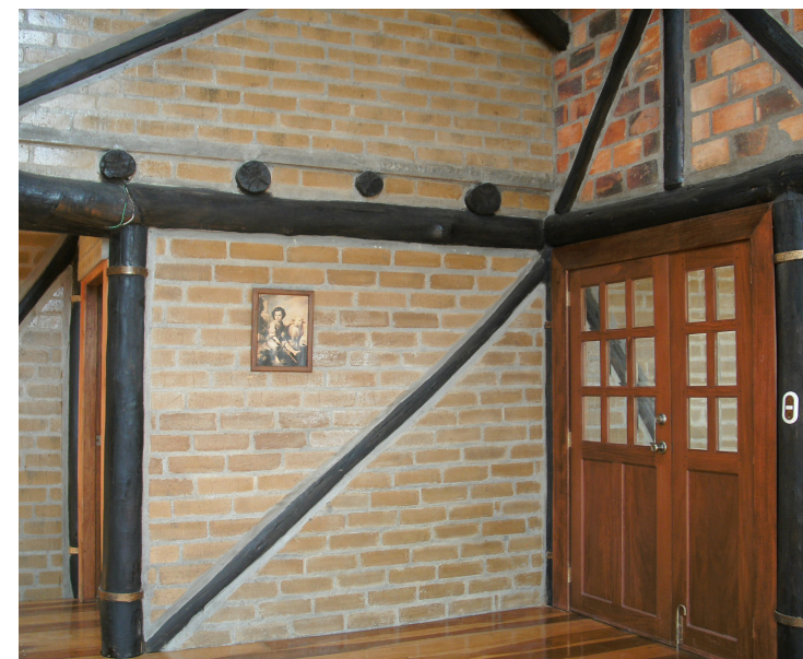
fig. 40b Muro Terminado de Adobe Prensado
