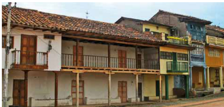
fig. 4 - Área Urbana: Arquitectura vernácula, barrio El Vecino (Cuenca)
