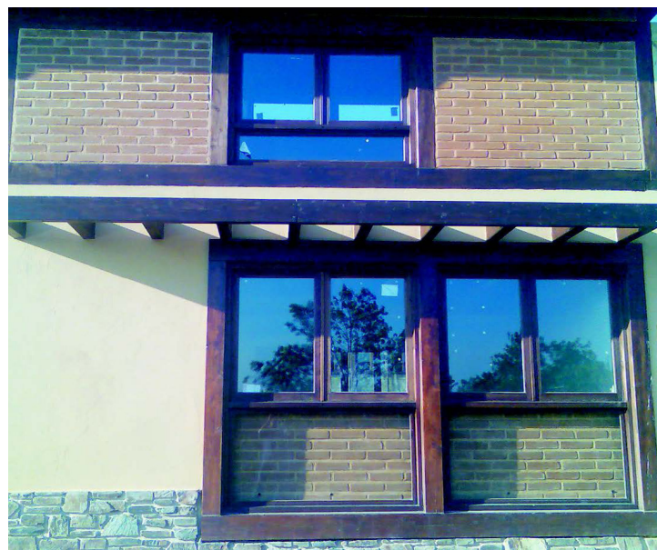
fig. 27 Muro visto de Adobe Prensado con impregnaciones superficiales
