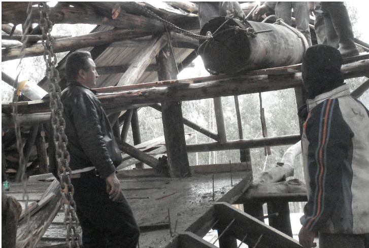
fig 30 Montaje de Estructura de Madera
