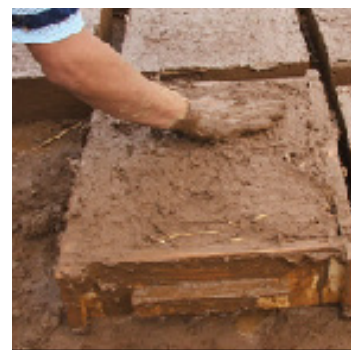
fig. 35 - Emparejamiento manual de la superficie.
