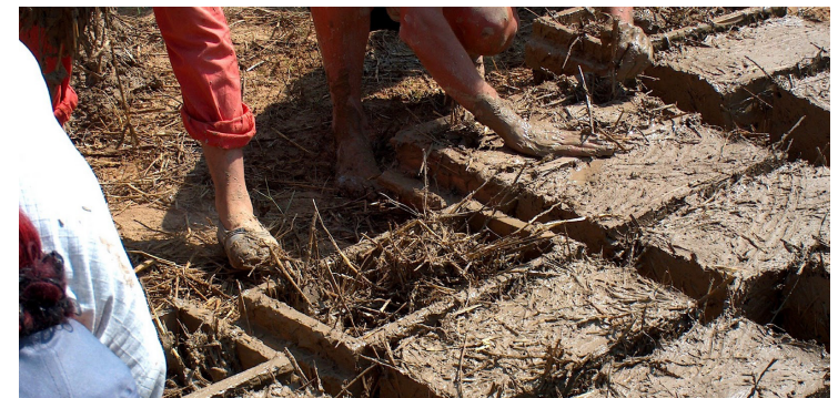
fig. 32 - Paja de cerro en la elaboración del adobe.
