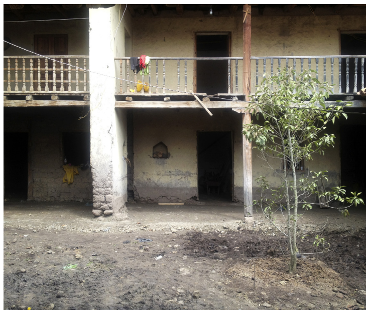
fig. 47 Antes de la restauración, patio interno
