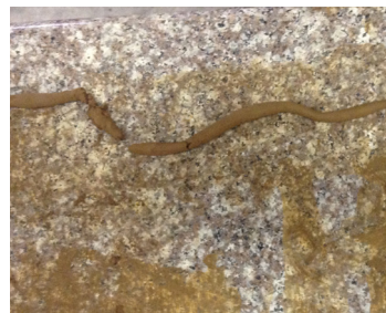
fig. 18 - Ensayo consistencia, Baños.
