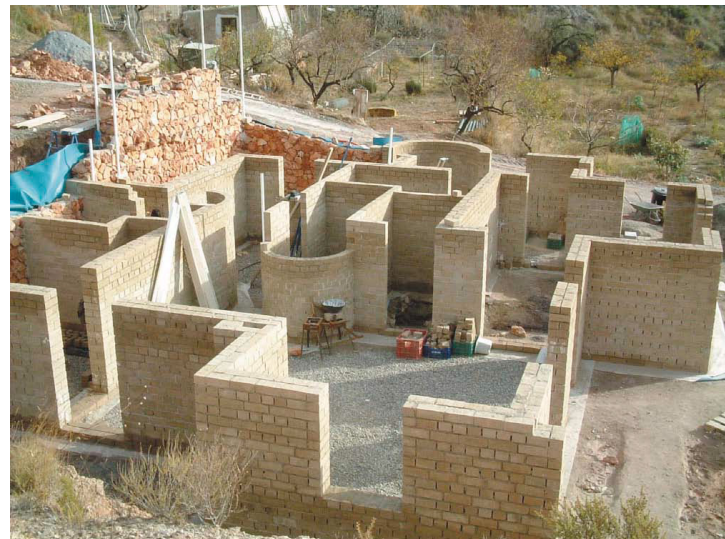
fig. 55 - Vivienda con Cannabric(bloque estabilizado con c  namo)
