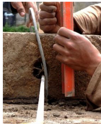
fig. 41 - Armado de Muros con refuerzo
