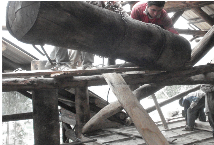
fig 31 Montaje de Estructura de Madera
