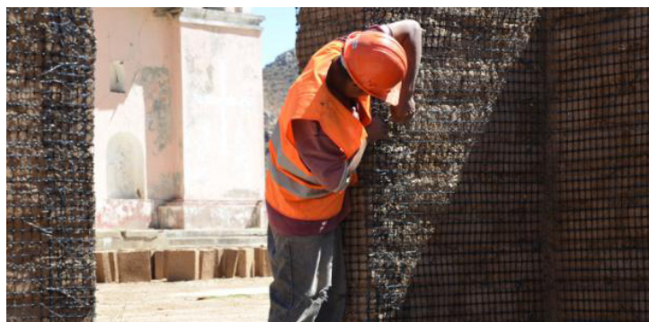
fig. 78 - Refuerzo con geomalla en vanos
