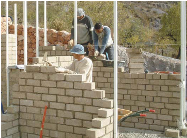
fig. 58 - Muros portantes de adobe prensado estabilizado con cáñamo
