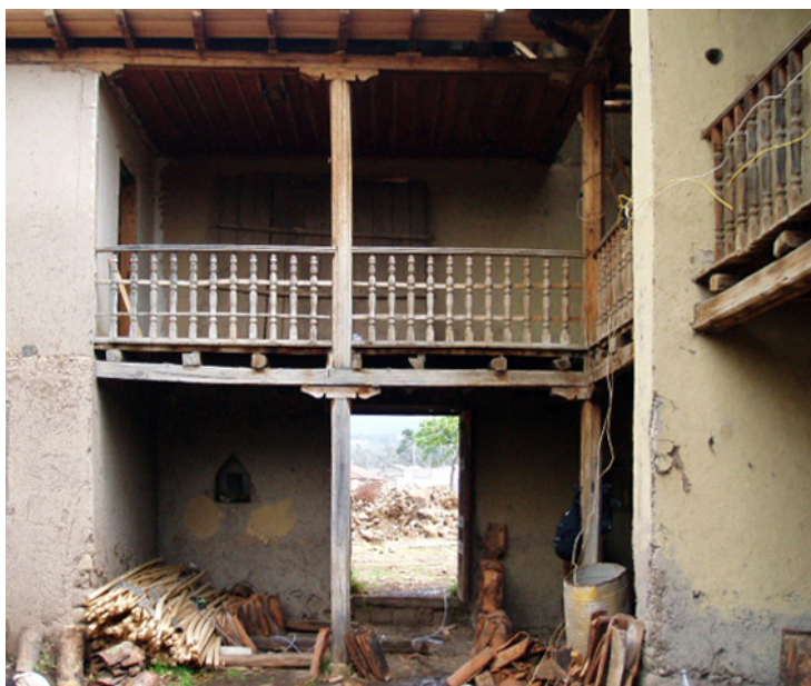
fig. 49 Antes de la restauración, patio interno
