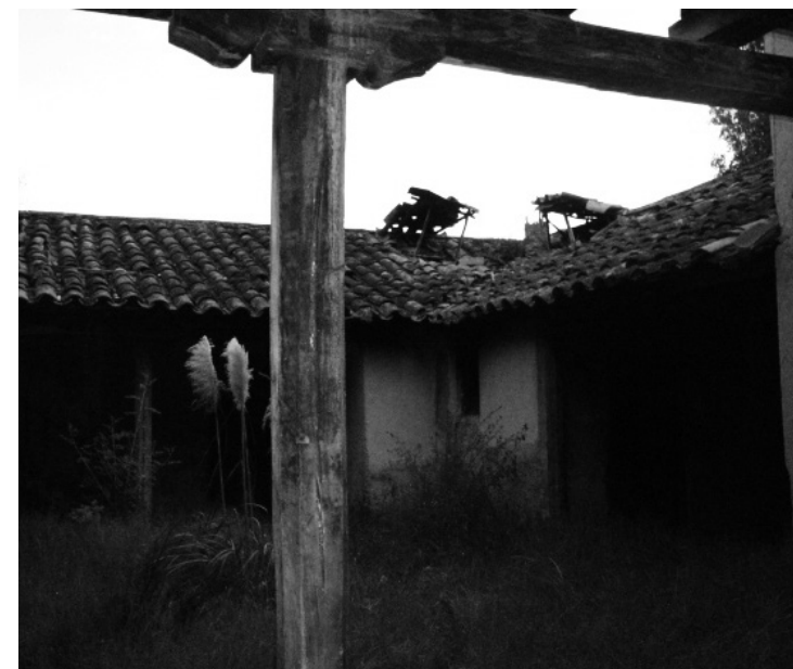
fig. 50 Antes de la restauración, patio interno
