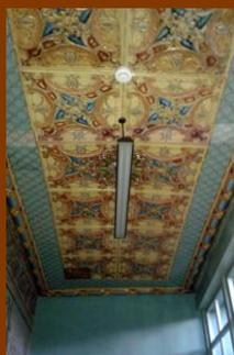
Fig.38: Latón de color azul empleado para decorar cielos rasos, dinteles, paredes, etc.
