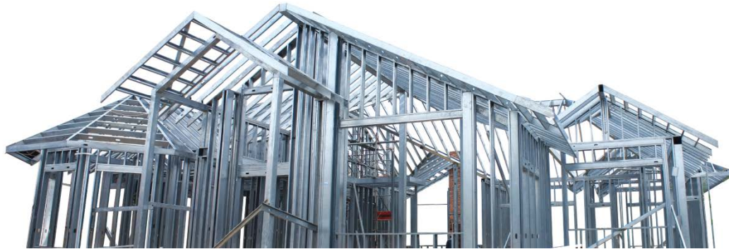
Fig. 6. Vivienda Unifamiliar en el Sistema Steel Framing (Cuenca-Ecuador)
