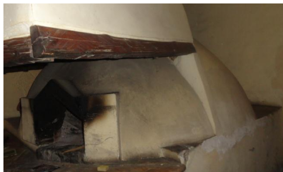
Fotografía 2. 2 Cúpula del Horno de leña del Complejo Patrimonial Todos Santos.
