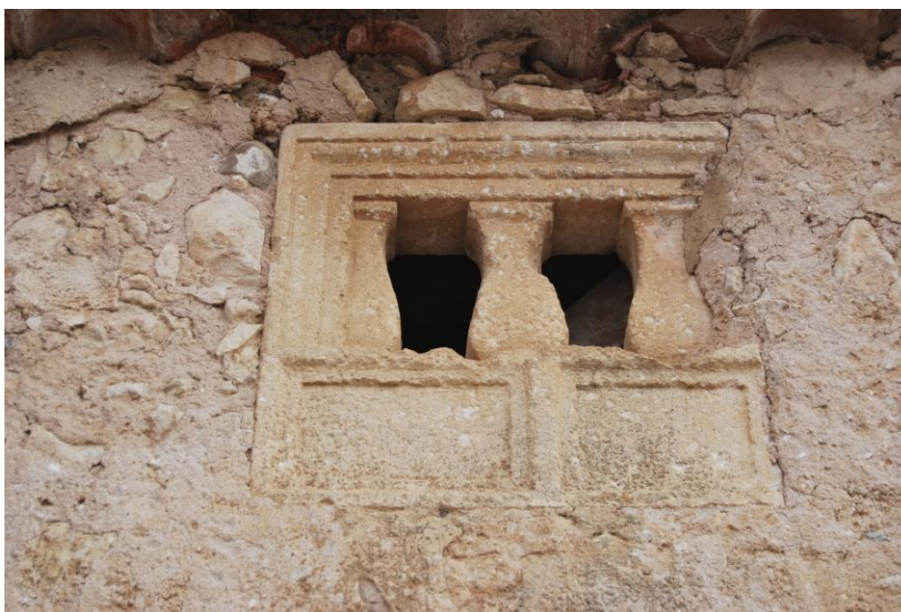
Imagen 3. Detalle de vano a Norte.
