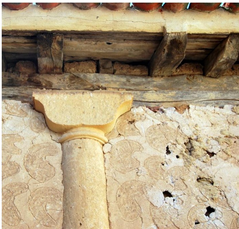
Imagen 2. Detalle de pórtico.
