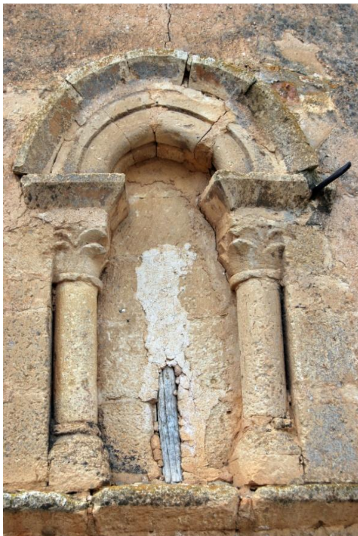
Imagen 1. Detalle de vano.
