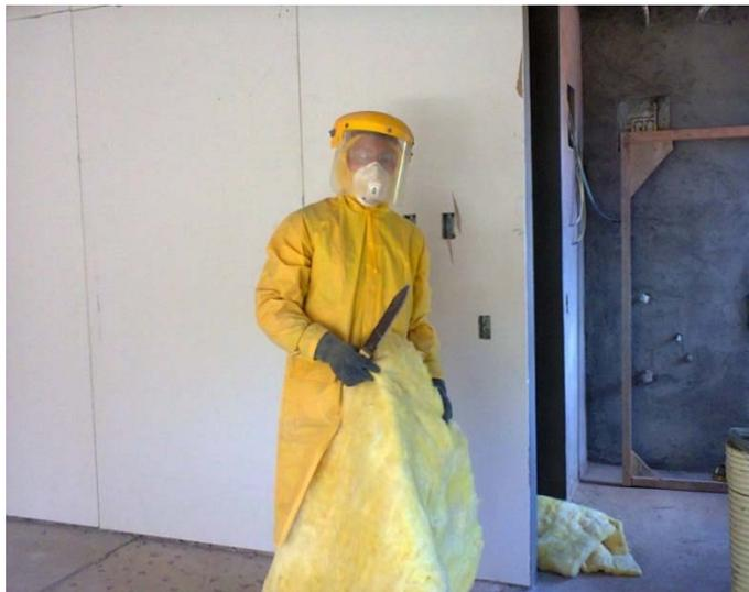
Ilustración 28: Protección individual, manipulación de material que genera partículas volátiles. (lana de vidrio), Edificio Torre Álamo, 2014, Fuente: La Autora
