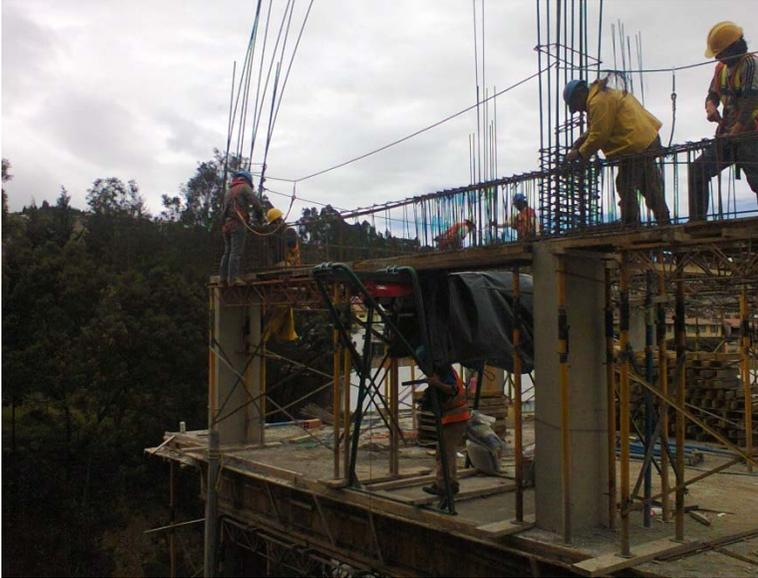
Ilustración 22: Trabajos de Armado de Hierro, Prevención de Accidentes en Altura, Fuente: La Autora
