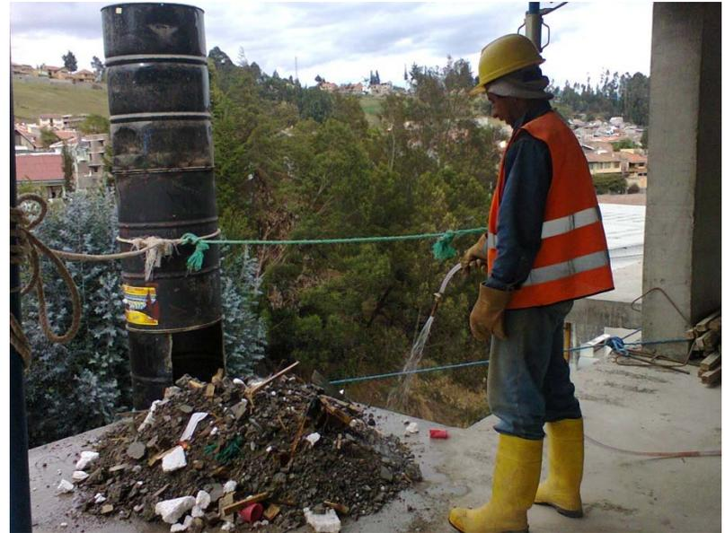
Ilustración 23: Fotografía de hidratación de escombros para evitar la generación de polvo al evacuar estos residuos, Edificio Torre Álamo, 2014 Fuente: La Autora.
