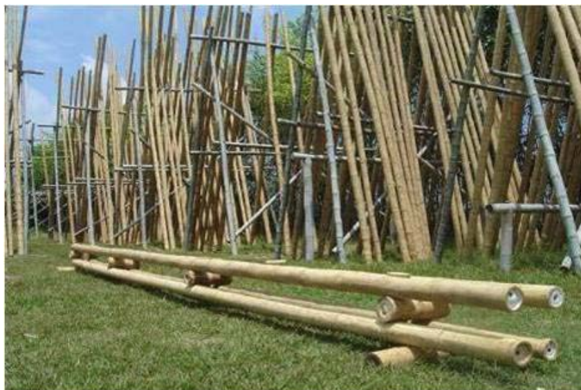
Imagen 1.7 Cuatro guaduas compuestas sirven como columna espaciada o como viga.
