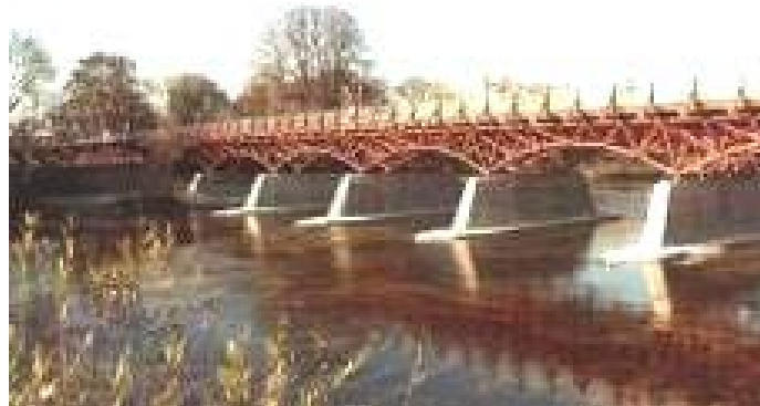
Imagen 1.20 Puente espacial en madera sobre el río Isar, Alemania.
