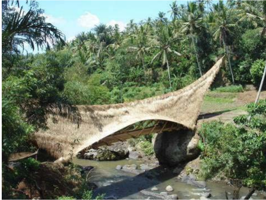
Imagen 1.14 Puente del “Greenschool” in Sibang, Bali, Indonesia.
