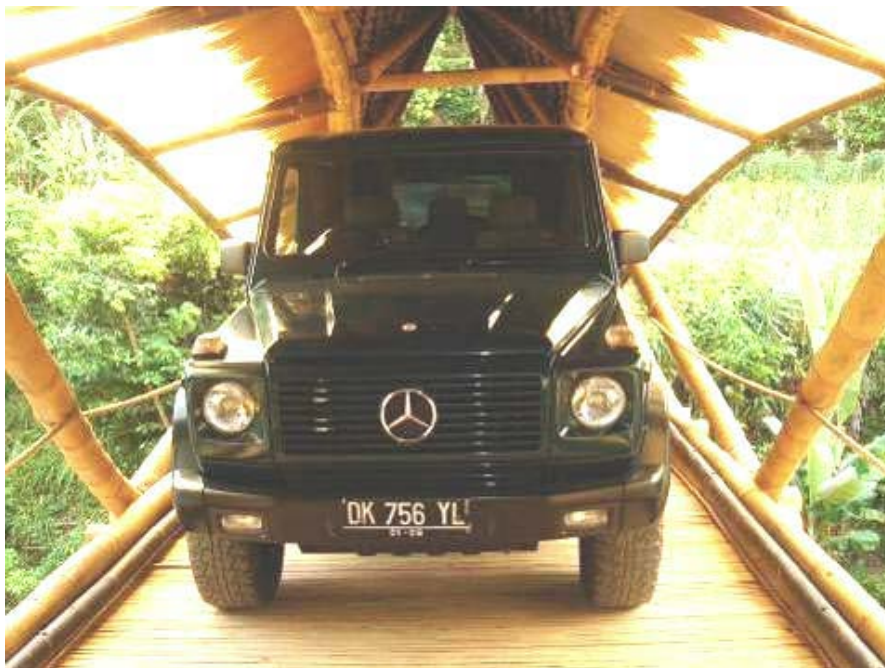
Imagen 1.15 Puente de arco compuesto de 3 bambús.
