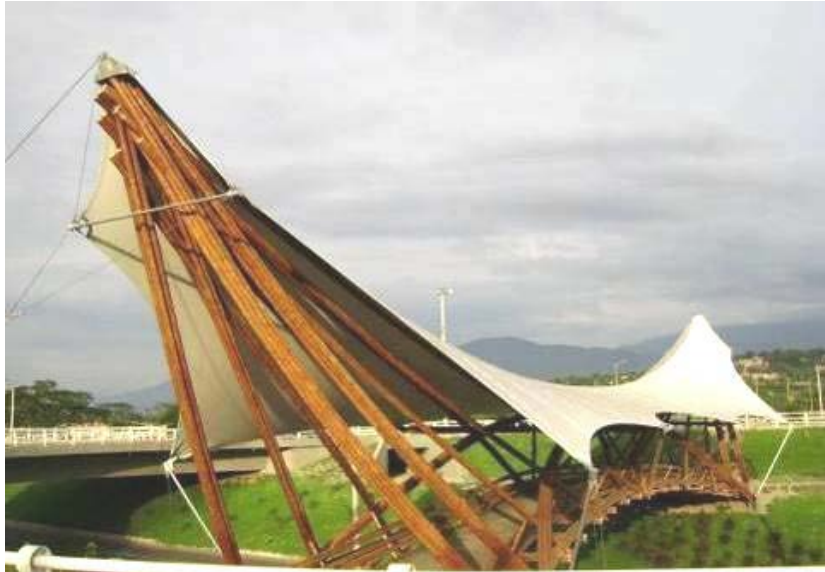
Imagen 1.13 Puente con carpas - membranas.
