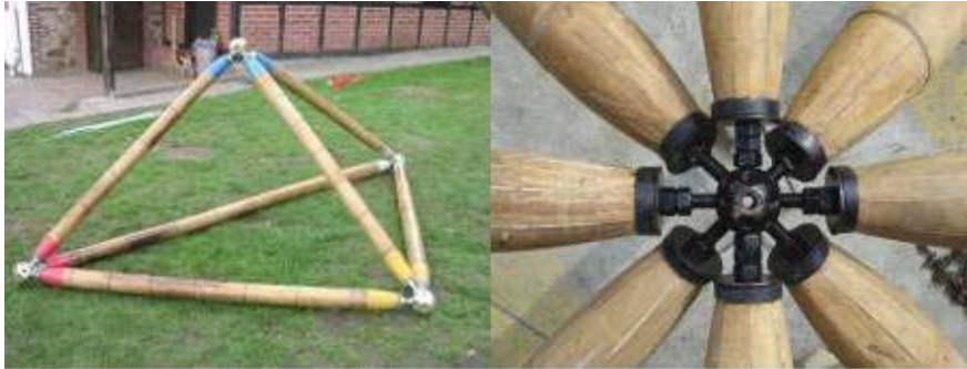
Imagen 1.19 Fijación Axial de pernos en uniones cónicas de bambú y bola MERO.
