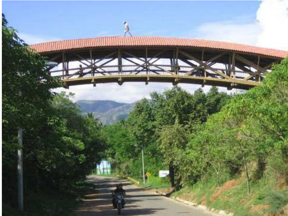
Imagen 1.17 Puente de Santa Fe de Antioquia.
