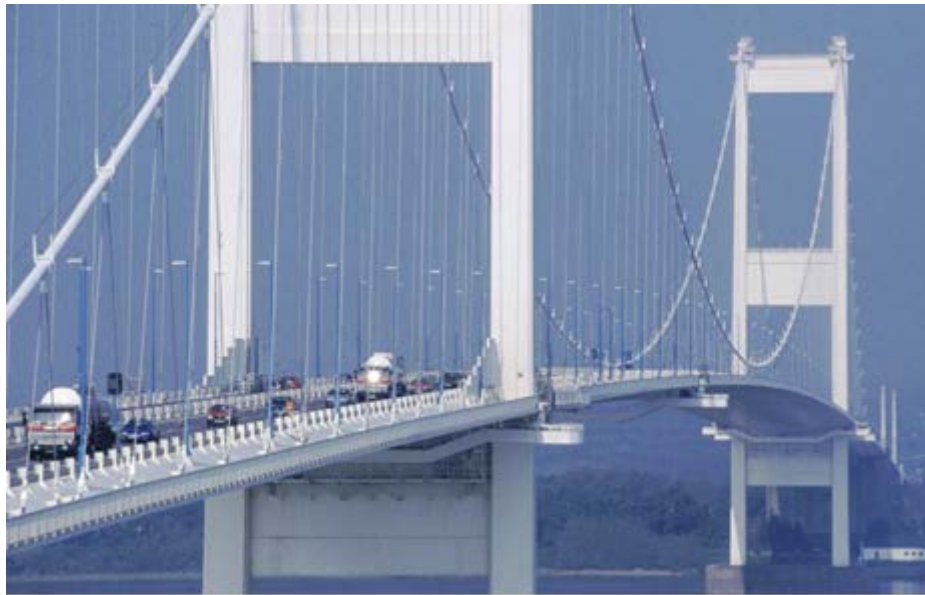
Imagen 1.6 Puente colgante Severn, Inglaterra, 1966
