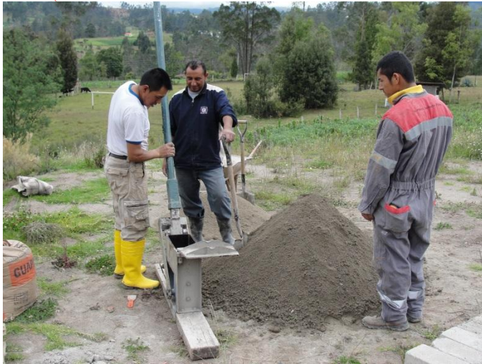
Figura 25. Compactadora y material preparado Fuente: Autor
