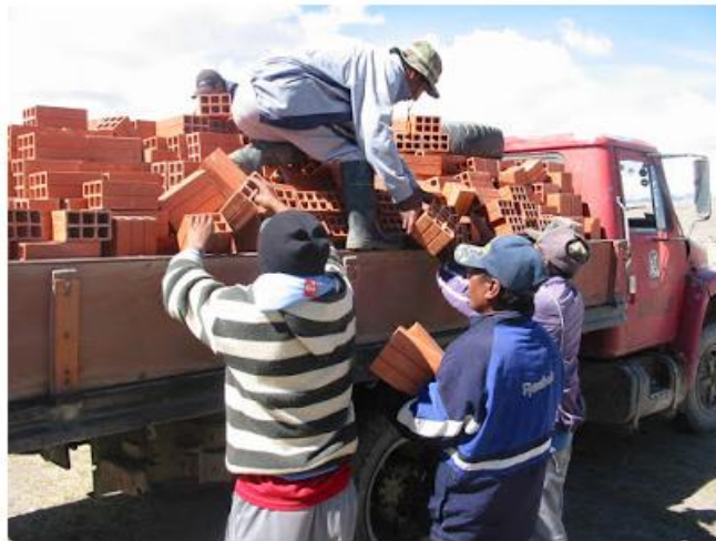
Figura 59. Descarga de ladrillo Fuente: Andes Fértiles
