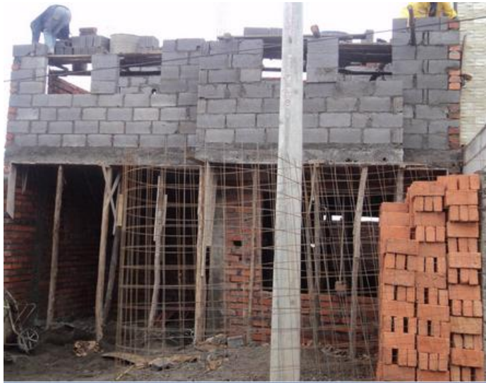
Figura 54. Construcción de vivienda típica, con ladrillo panelón en planta baja y bloque pómez en planta alta.
