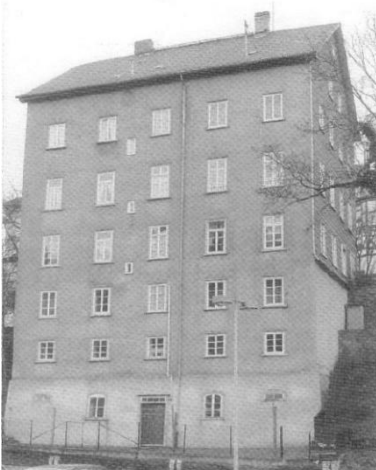
Figura 2. Edificio Weilburg Fuente: Minke2005
