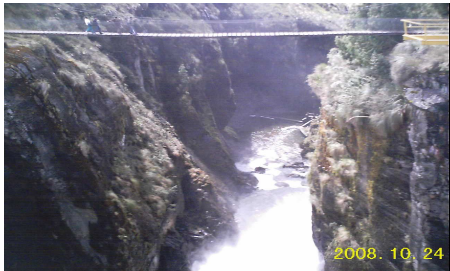
Figura 8. Desfogue de agua de la Represa Chanlud > 3200. 2008.
