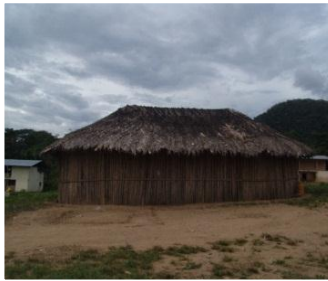
Casa Shuar de la comunidad fotografías José Cárdenas y Belen Ordoñez
