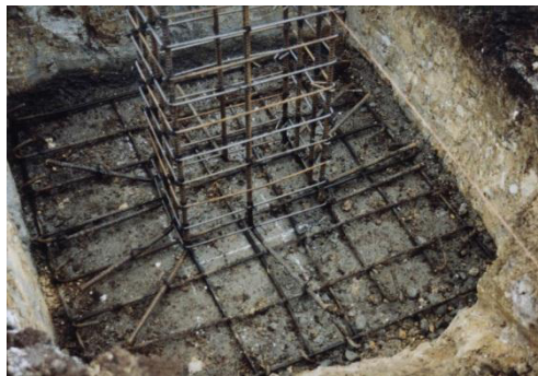
Figura 2.5.- Acero de refuerzo en zapatas
