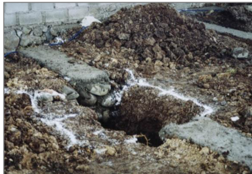
Figura 2.7.- Cimiento de piedra
