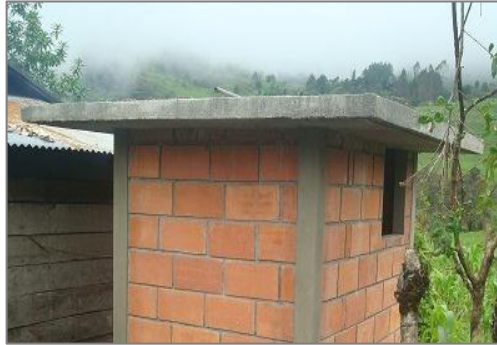
Figura 2.23.- Hormigón simple losa maciza
