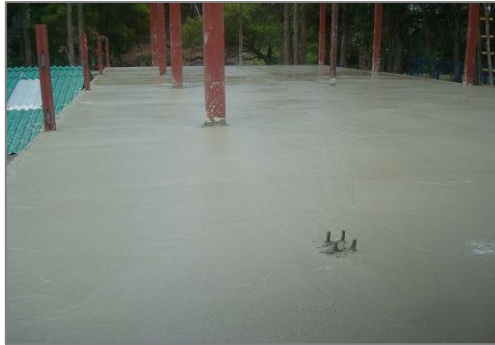
Figura 2.31.- Hormigón simple en losas
