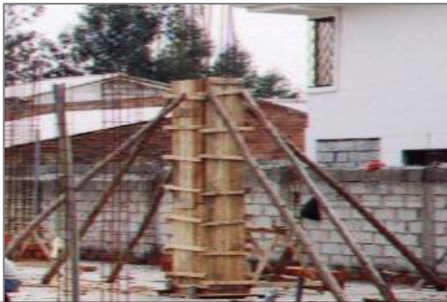
Figura 2.12.- Encofrado columnas
