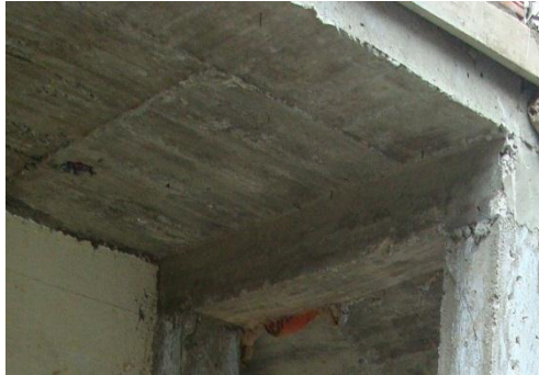
Figura 2.16.- Hormigón simple vigas
