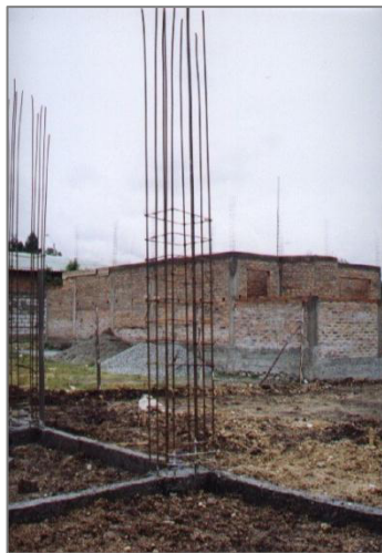
Figura 2.11.- Acero de refuerzo en columnas
