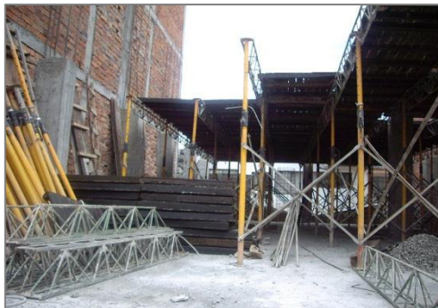
Figura 2.17.- Encofrado losa hormigón
