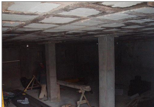
Figura 2.19.- Hormigón simple en losa
