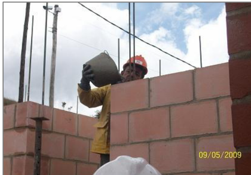
Figura 2.26.- Mortero relleno mampostería estructural
