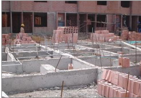
Figura 2.25.- Acero refuerzo mampostería estructural
