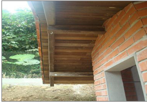
Figura 2.36.- Aplicación de tratamiento de madera
