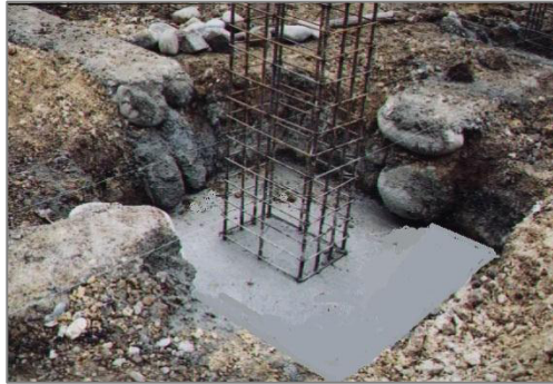
Figura 2.6.- Hormigón simple en zapatas
