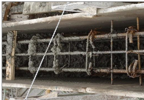
Figura 2.9.- Encofrado para cadenas
