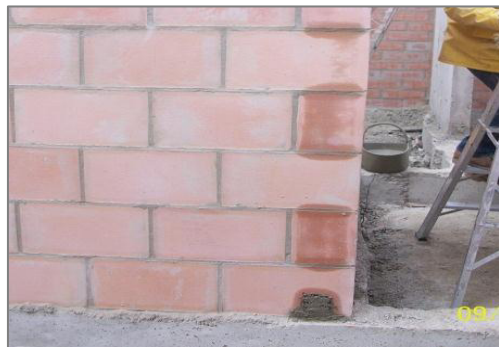
Figura 2.24.- Mampostería de ladrillo vertical
