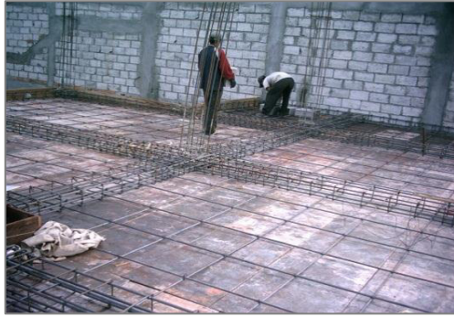
Figura 2.18.- Acero de refuerzo en losa
