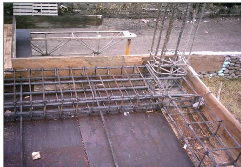
Figura 2.15.- Encofrado vigas
