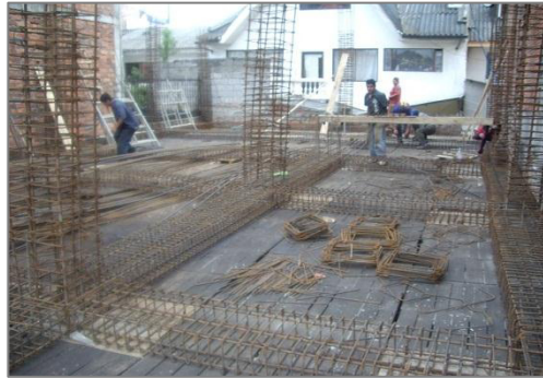
Figura 2.14.- Acero de refuerzo en vigas
