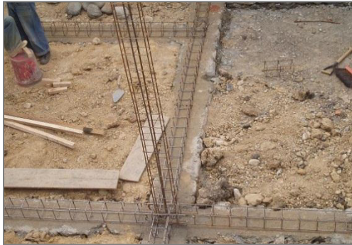
Figura 2.8.- Acero de refuerzo en cadenas
