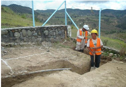
Figura 2.2.- Excavación a mano
