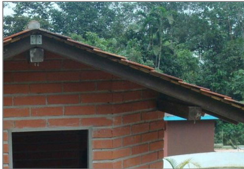
Figura 2.34.- Viga de madera 150x50 mm
