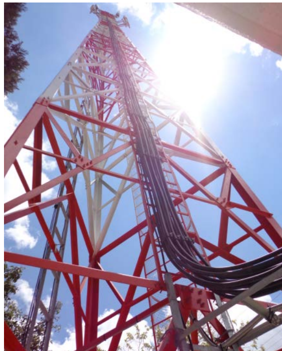
Imagen 2.8 Torre con cables y escaleras
