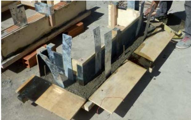
156: Proceso Constructivo, Módulos, Colocación Hormigón, Vigas de Amarre.
