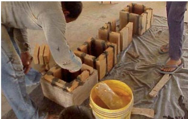
458: Proyecto Abu Y Fonts, Módulos Prefabricados, Encofrados de Madera.
