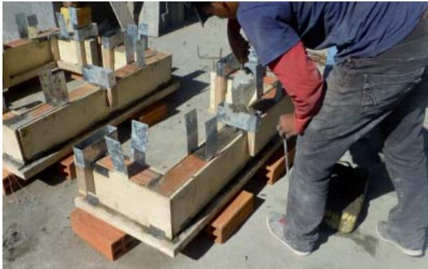
158: Proceso Constructivo, Módulos, Vertido de Hormigón en Columnetas.
