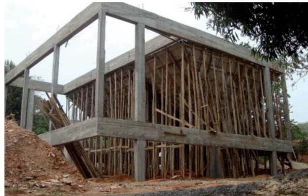
350: La Teletón, Bloque C, Sistema Estructural de Hormigón Armado.
