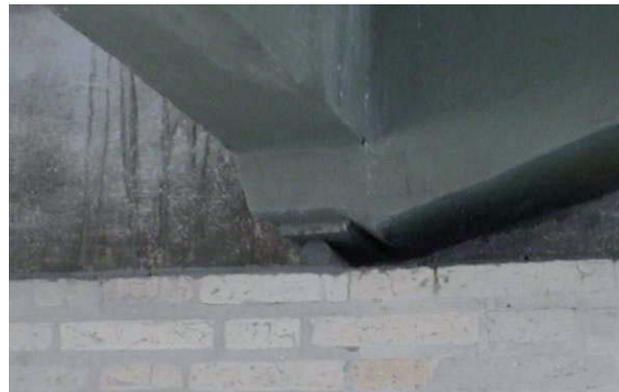
93: Casa Fanego, Apoyos con Rodillos, Vigas Vierendeel en Muros de Carga.
