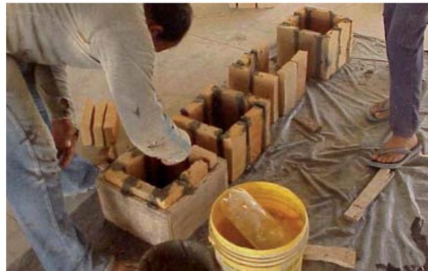
174: Casa Abu Y Fonts, Proceso Constructivo, Módulos Prefabricados.
