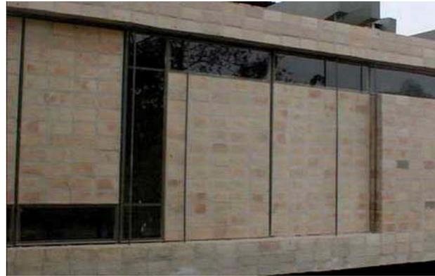
86: Casa Fanego, Fachada Elaborada con Paneles Prefabricados.
