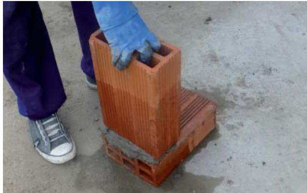
152: Proceso Constructivo, Unión de Ladrillos, Esquina.
