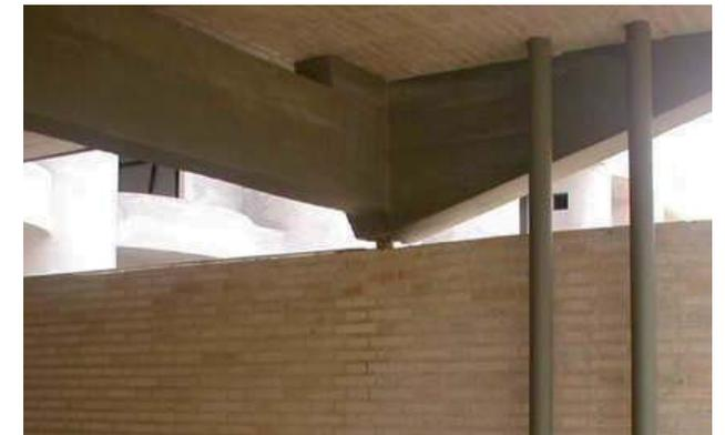
94: Casa Fanego, Apoyos con Rodillos, Vigas Vierendeel en Muros de Carga.
