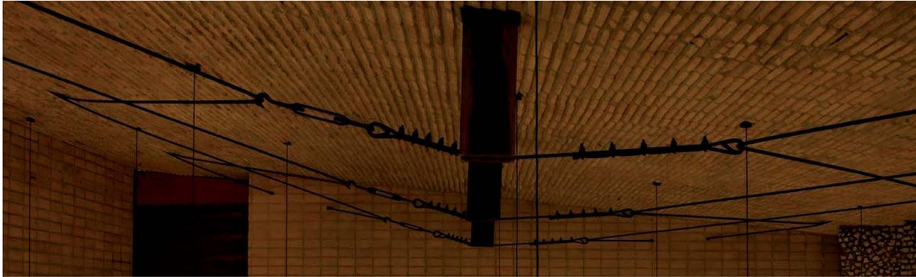
262: Estancia Las Anitas (LA), Tensores de Acero y Losa de Cubierta.
