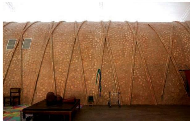
339: La Teletón, Bóveda Interior, Armadura Estructural.
