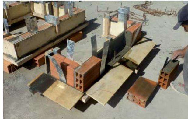
157: Proceso Constructivo, Módulos, Colocación de Ladrillos.
