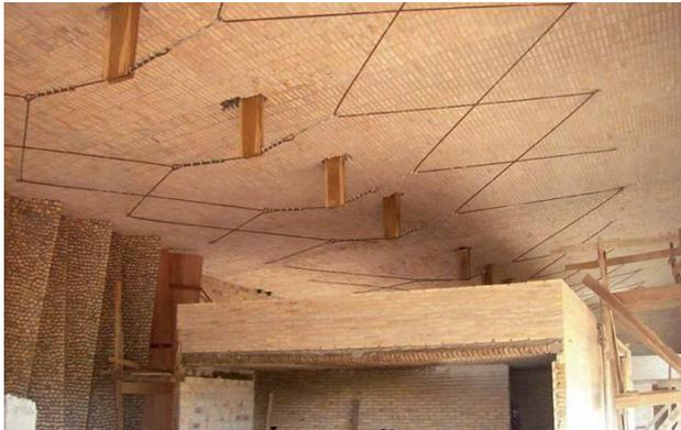
263: Estancia Las Anitas (LA), Tensores de Acero y Losa de Cubierta.
