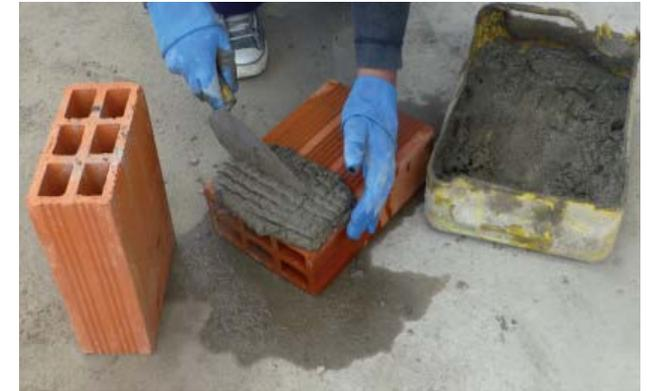
151: Proceso Constructivo, Ladrillos, Esquina, Mortero de Cemento.
