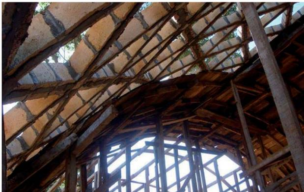
372: La Teletón, Bóveda Exterior, Módulos Triangulares Colocados.
