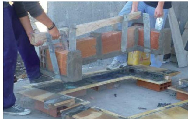
161: Proceso Constructivo, Módulos, Desencofrado.
