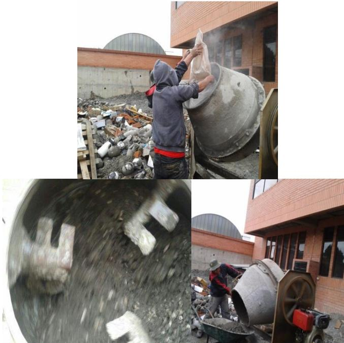
Ilustración 17 Concretera basculante utilizada
