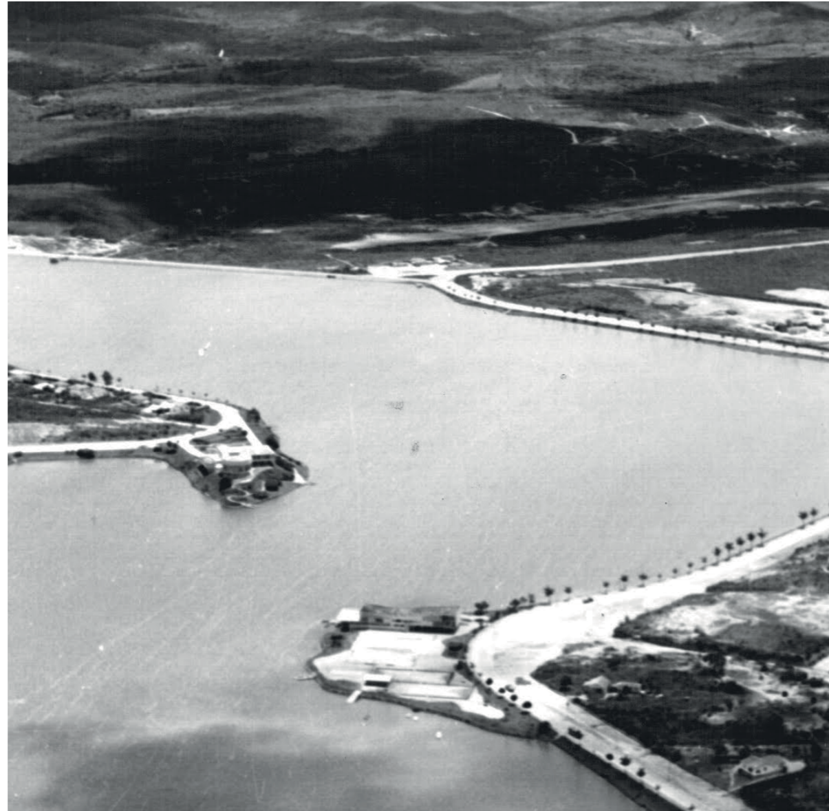
45. Complejo de Pampulha en construcción
