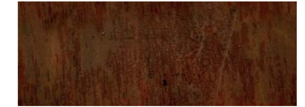
PLACAS DE ACERO CORTEN OXIDADO
