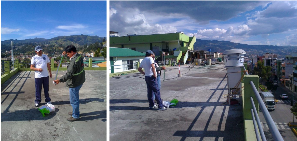
Figura 3.4.1 Personal del GADM de Azogues en instalación de equipos
