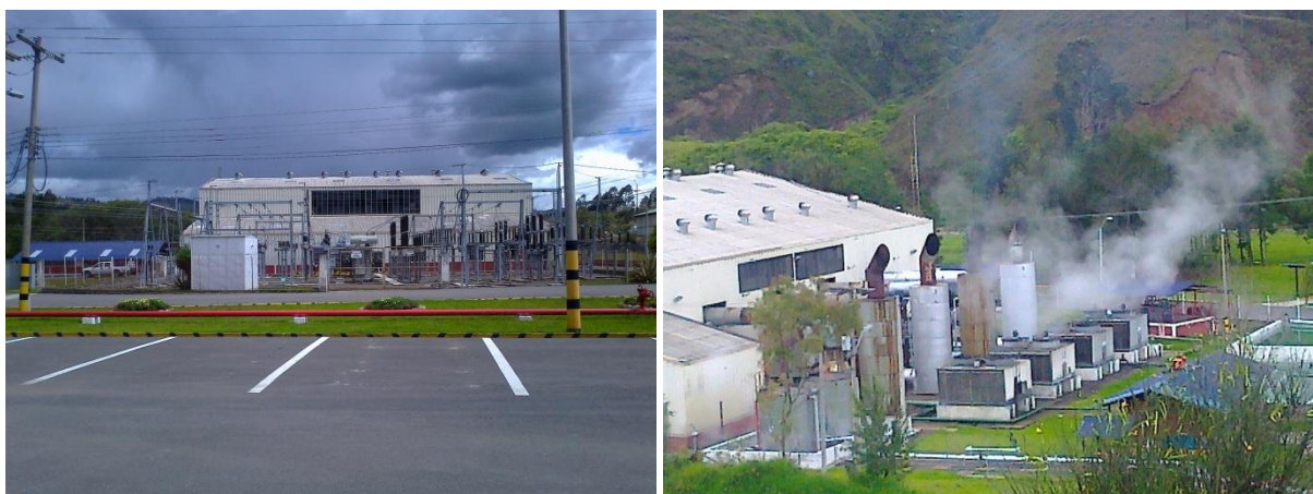
Figura 4.1.14 Central Termoeléctrica El Descanso
