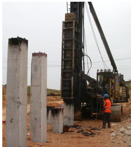
FIGURA 3. 4 Colocación de pilotes prefabricados hincados
