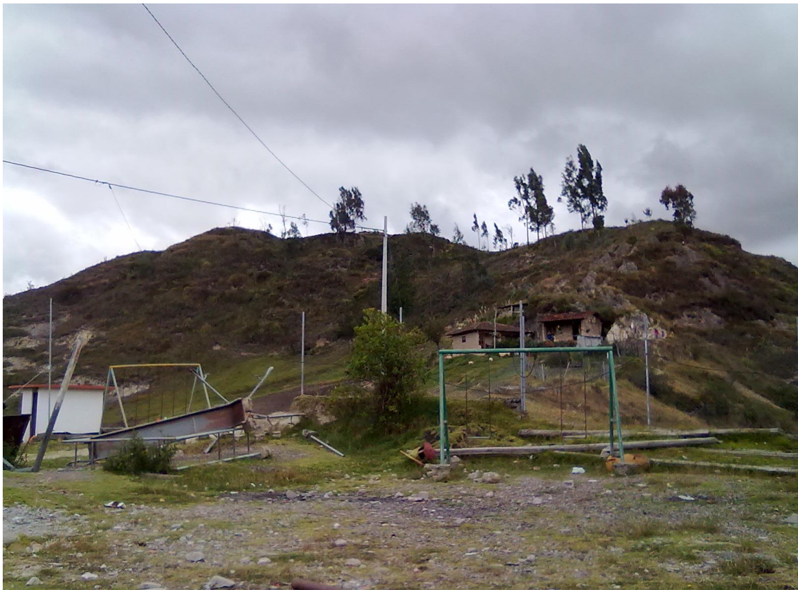
Bauteloma vista desde la parte baja.
