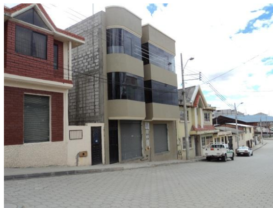
Fig. 127. Edificación de tres plantas. FUENTE: Grupo de trabajo.
