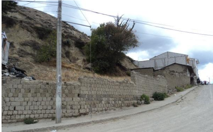
Fig. 168. Cerramiento De Adobe FUENTE: Grupo de trabajo.
