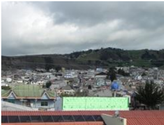
Fig. 169. Cerramiento De Adobe FUENTE: Grupo de trabajo.
