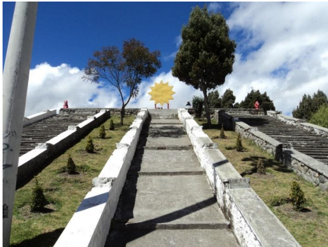
Fig. 95. Hito Cultural construido. FUENTE: Grupo de trabajo.
