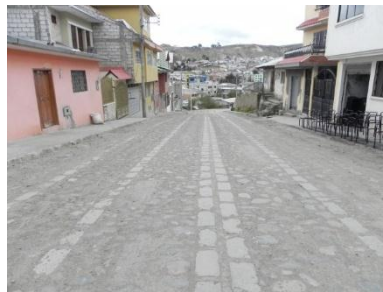
Fig. 139. Tramo Nº Tres. FUENTE: Grupo de trabajo.
