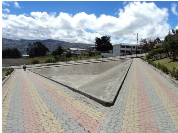
Fig. 97. Hito Cultural construido. FUENTE: Grupo de trabajo.
