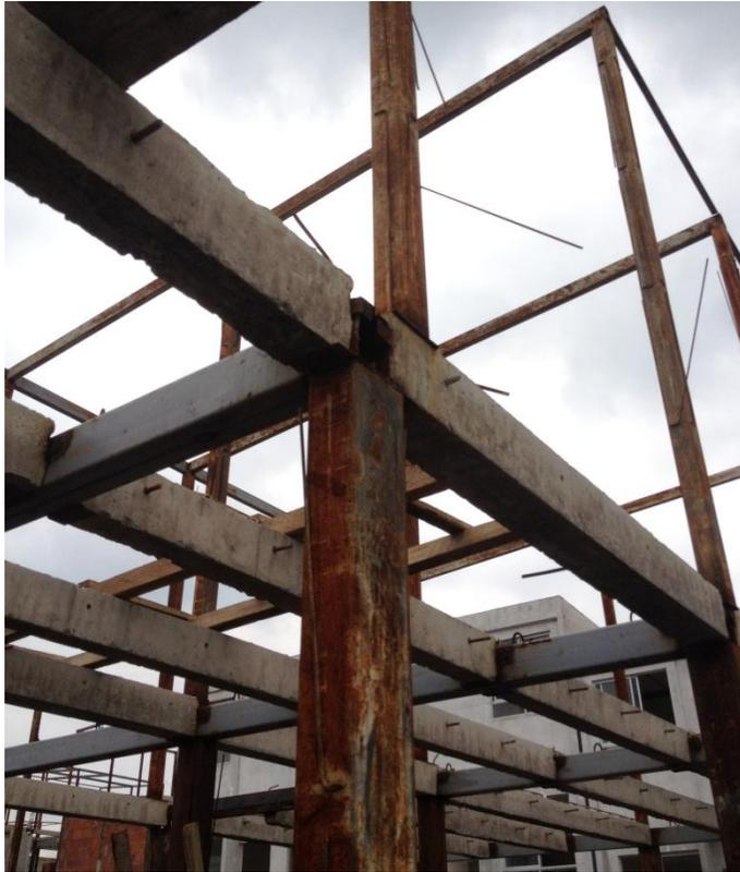
**Foto 92.-** Estructura mal concebida y mal construida, se observa esbeltez en los elementos de la segunda planta, desfase de columna, elementos de acero sin protección a corrosión, inadecuada combinación de materiales, baja calidad de construcción.
