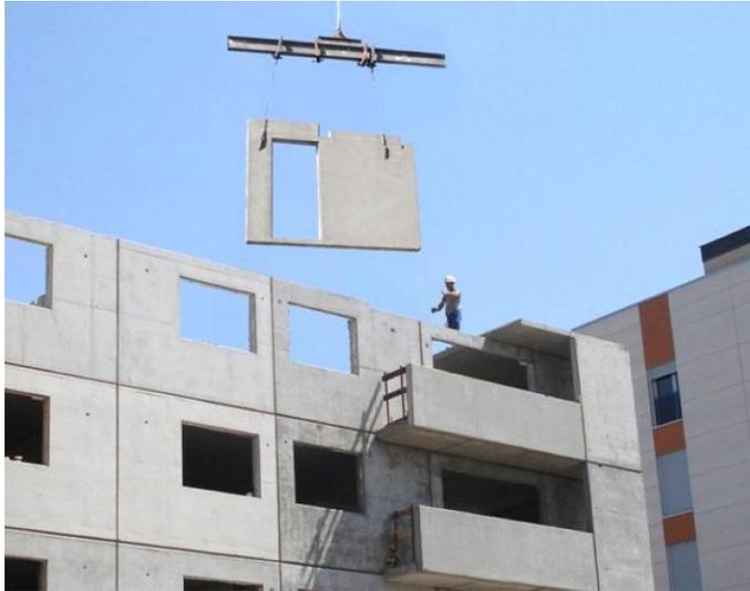
**Foto 14.-** Ejemplo de vivienda prefabricada en hormigón.
