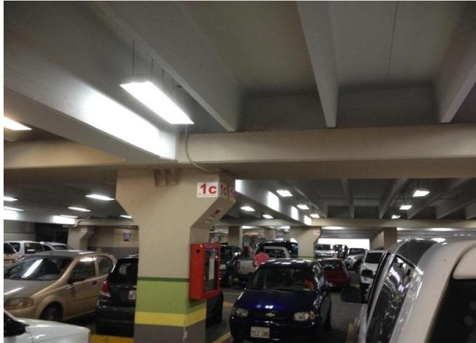
**Foto 86.-** Columna con ménsulas, viga principal tipo “T” invertida y vigas doble “T” para vigas prefabricadas pretensadas en centro comercial de Cuenca.
