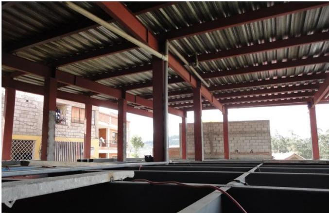
**Foto 94.-** Reforzamiento estructural de edificación, trabajos en columnas.
