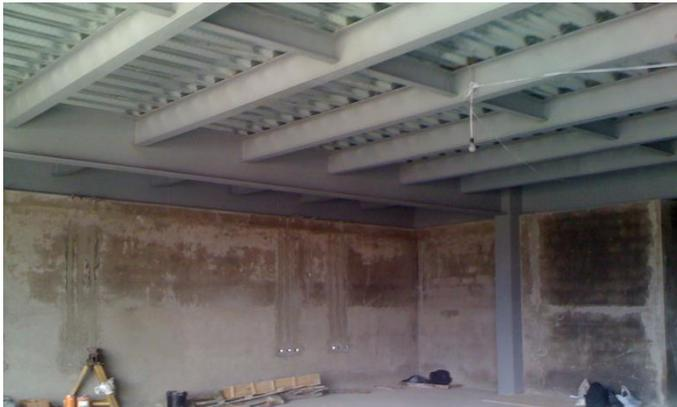
**Foto 102.-** Mampostería de bloque en estructura de acero.
