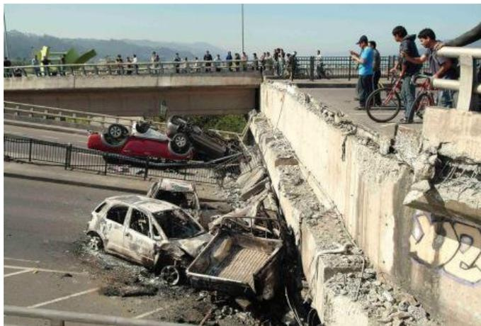
**Foto 87.-** Colapso del tablero del puente por reducido espacio de apoyo para las vigas de soporte, luego del sismo de 2010 en Chile
