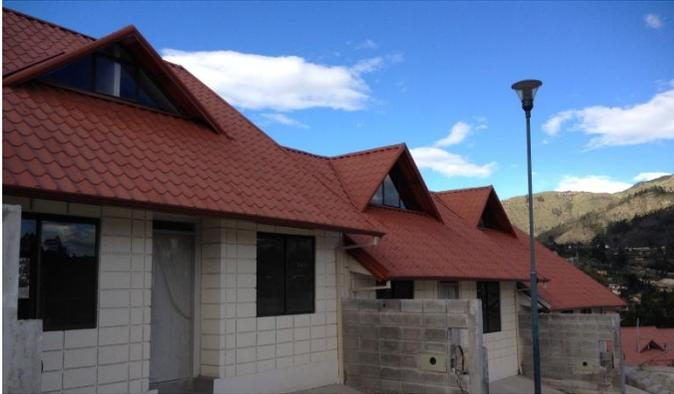
**Foto 119.-** Urbanización de los Maestros del Magisterio de la Ciudad de Azogues, con cubierta metálica tipo teja.
