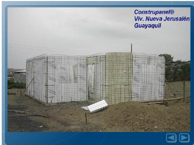
**Foto 51.-** Etapa 1: colocación de plancha de poliestireno expandido con la malla electrosoldada.
