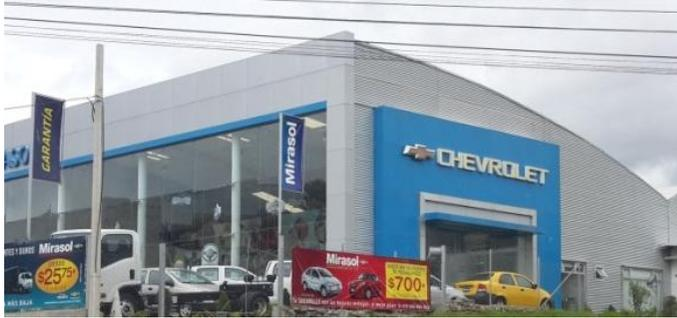
**Foto 124.-** Fachada mixta en vidrio y metal, con Alucubond de color gris y azul, en un concesionario de vehículos en la ciudad de Azogues.
