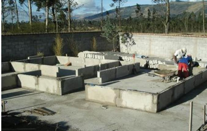
**Foto 64.-** Colocación de primera fila de ecobloque sobre cimentación, tipología constructiva de Casa Mía.
