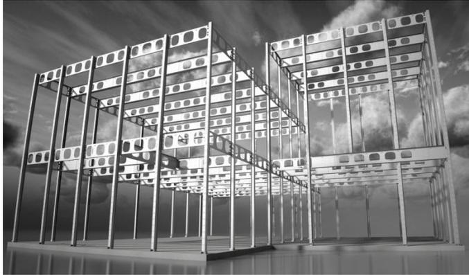
**Imagen 5.-** Estructura en acero de una vivienda tipo MECANO (VIGA-COLUMNA) de la empresa BONNE ESTRUCTURE, de Toronto-Canadá.
