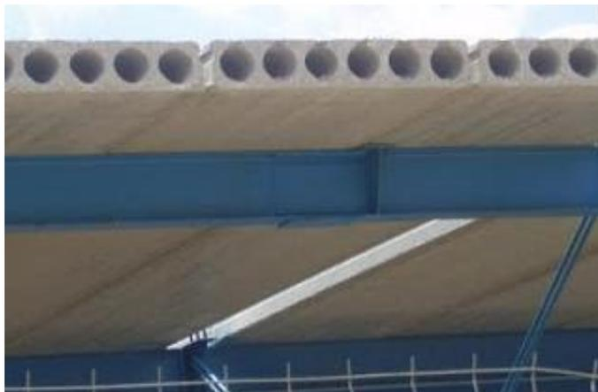
**Foto 95.-** Losa de piso con losa alveolar sobre estructura soportante de acero.
