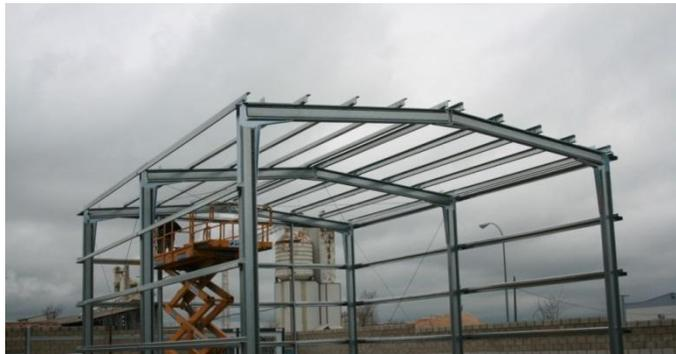
**Foto 114.-** Estructura de cubierta prefabricada de acero.
