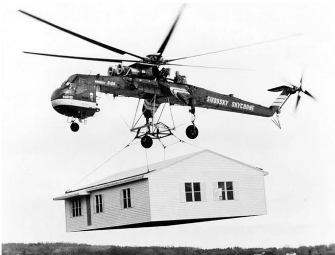
**Imagen 7.-** Transporte especial de una vivienda completa mediante el uso de helicóptero.
