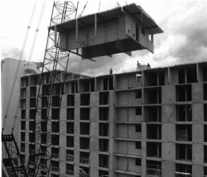
**Foto 24.-** Célula 3D construido bajo proceso industrializado, para formar parte de un proyecto prefabricado.
