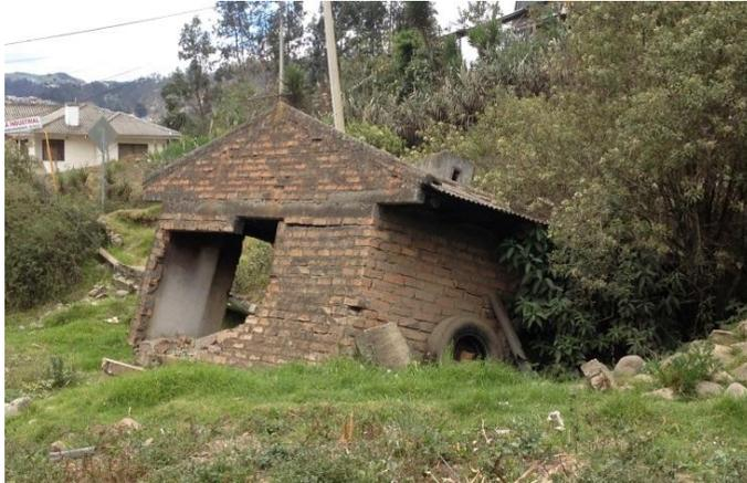
**Foto 4.-** Vivienda colapsada, construida en tipología tradicional. Edificada en zonas de riesgo.
