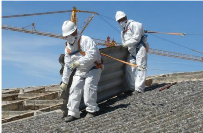
**Foto 115.-** Sustitución de planchas onduladas de Fibrocemento.
