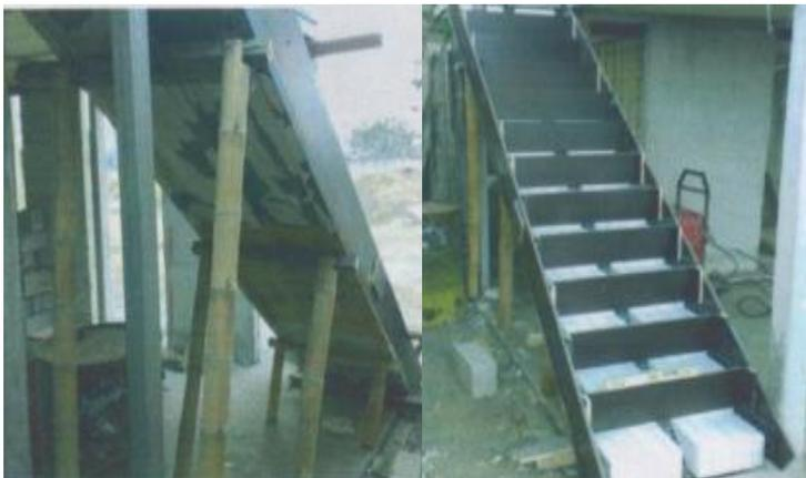
**Foto 47.-** Encofrado para gradas aligeradas con sistema AISLAPOL S.A.
