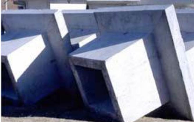
**Foto 78.-** Forma de las zapatas aisladas prefabricadas.
