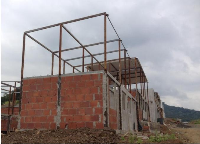
**Foto 101.-** Mampostería de arcilla en estructura de acero.
