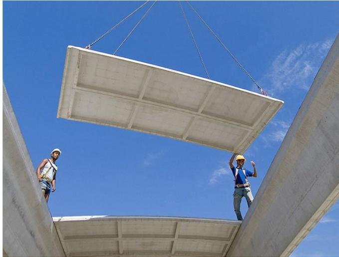
**Foto 112.-** Cubierta prefabricada de hormigón, que se enlaza con la estructura global de la edificación construida también en este material.
