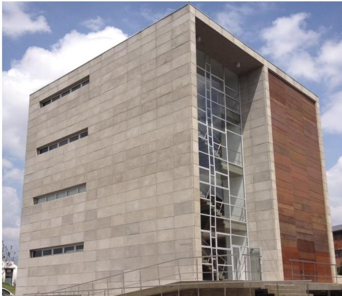
**Foto 122.-** Fachada contemporánea del Edificio de Posgrados de la Facultad de Arquitectura de la Universidad de Cuenca. Fachada en prefabricados de hormigón y de acero.
