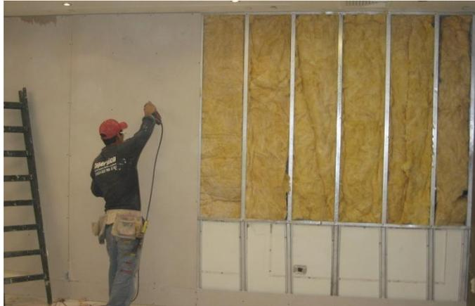
**Foto 103.-** Instalación de paneles de Gypsum, con aislante intermedio.
