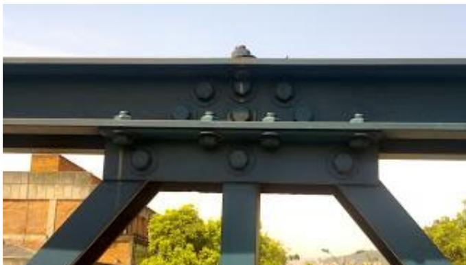
**Foto 89.-** Nudo tipo FR, ensamblado mediante pernos.
