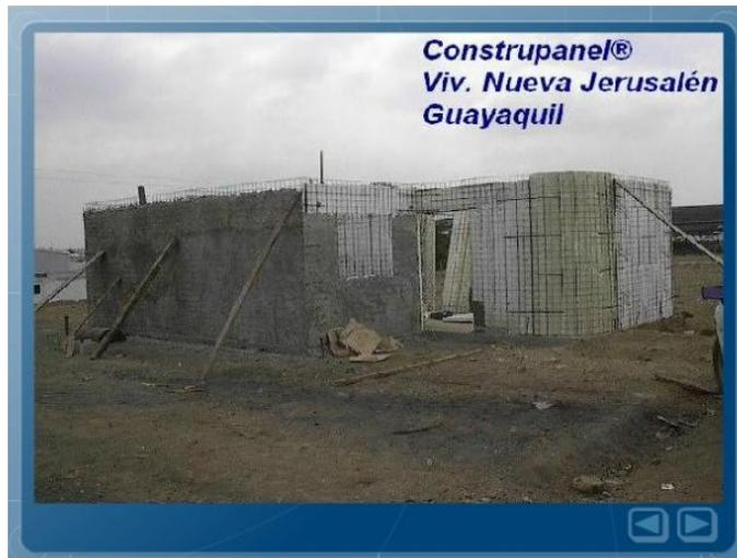
**Foto 52.-** Etapa 2: colocación –similar al enlucido tradicional– de mortero sobre los paneles colocados.
