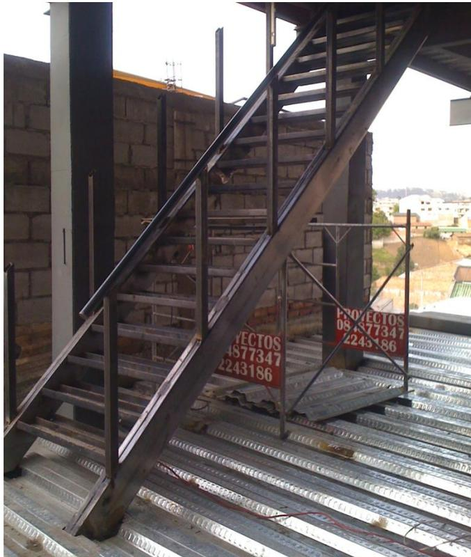
**Foto 108.-** Estructura de Escalera en acero, con zancas y escalones prefabricados en taller.
