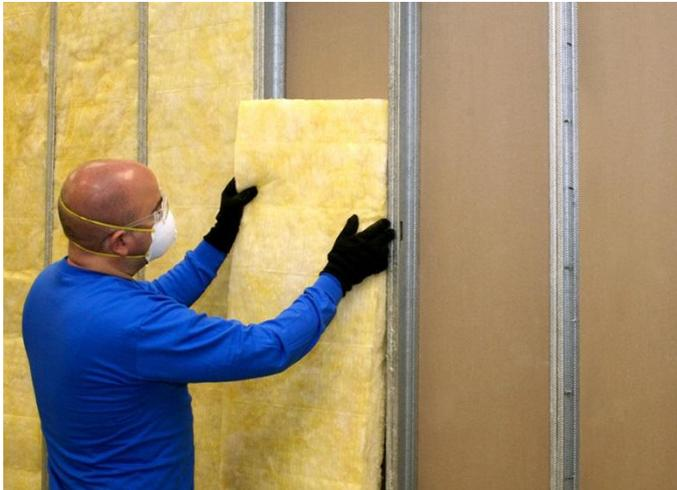
**Foto 105.-** Instalación de planchas de lana de vidrio, como aislante de la tabiquería.
