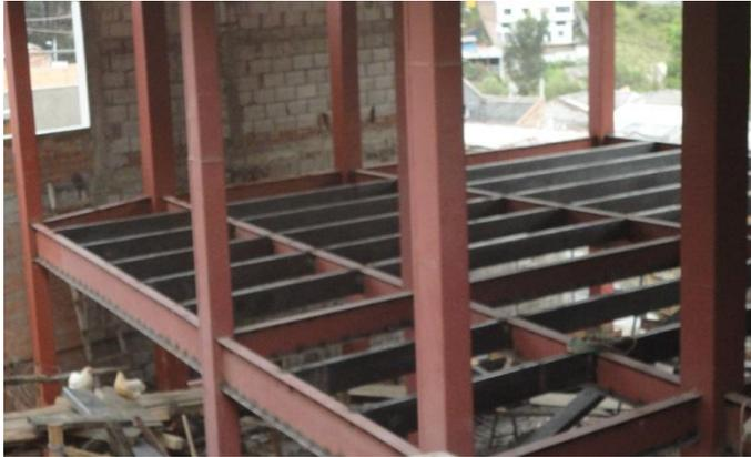
**Foto 93.-** Reforzamiento estructural de losa de entre piso con vigas prefabricadas en taller.
