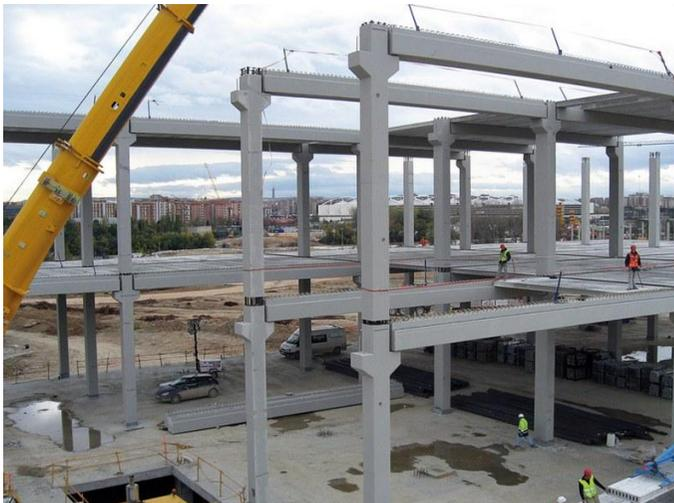
**Foto 85.-** Estructura prefabricada en hormigón armado.
