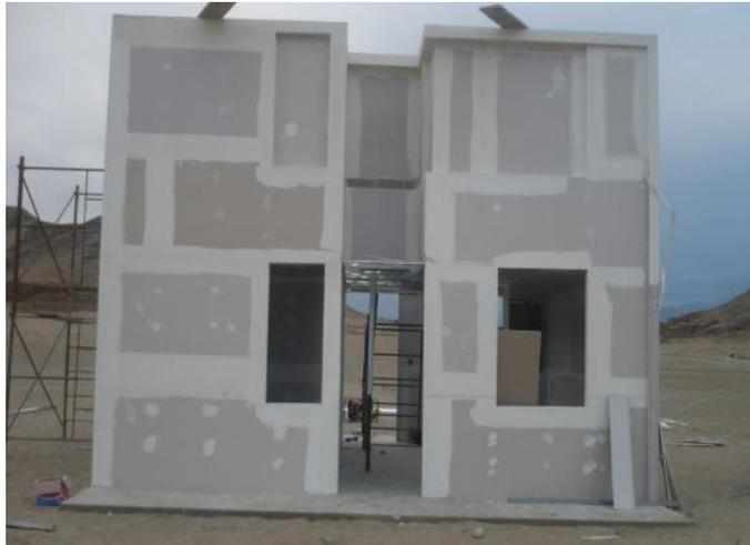
**Foto 104.-** Edificación con placas de Gypsum en su exterior.
