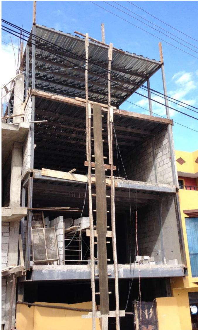
**Foto 91.-** Estructuras mal concebida y mal construida, se observa esbeltez en los elementos de las últimas losas, y sobredimensionamiento en las primeras plantas.
