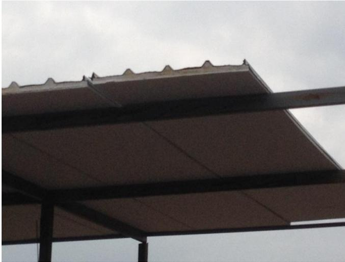
**Foto 117.-** Instalación de planchas de Cubierta de Acero con aislamiento térmico y acústico.
