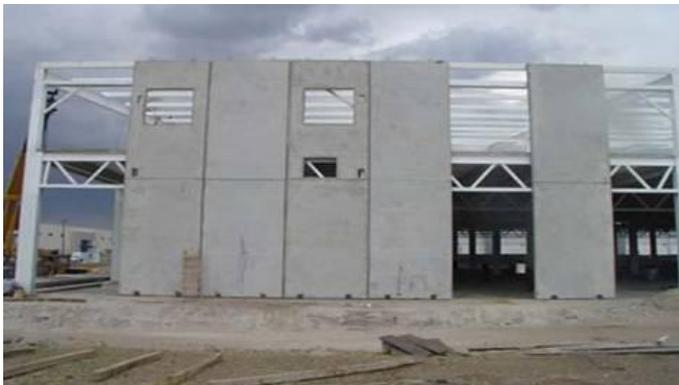
**Foto 29.-** Construcción en hormigón en paneles grandes.
