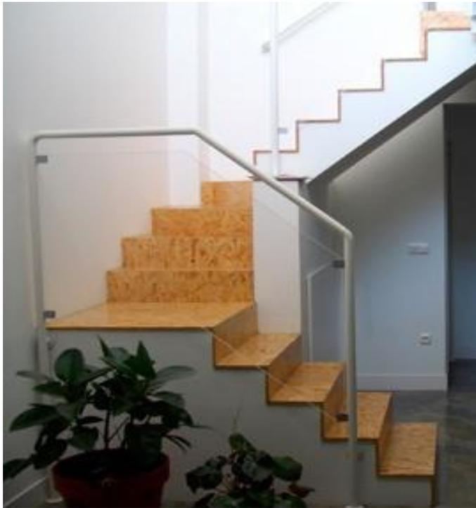
**Foto 111.-** Uso de OSB como material de acabado en huellas y contrahuellas en gradas.
