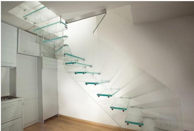
**Foto 107.-** Escalera de vidrio templado, con escalones prefabricados.
