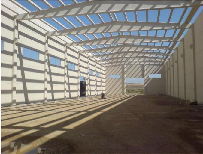
**Foto 113.-** Estructura de cubierta prefabricada de hormigón.
