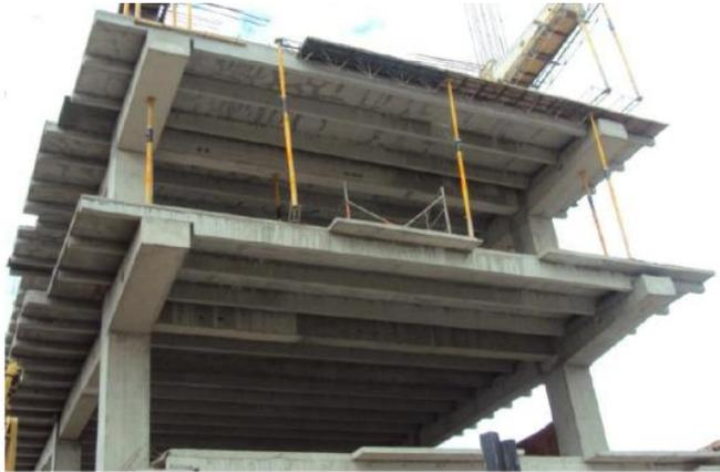
**Foto 72.-** Construcción del Edificio “Portal del Ejido” con vigas pre-tensadas.
