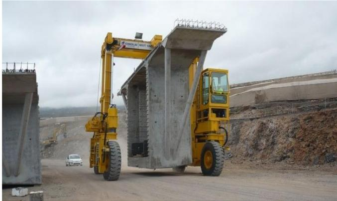
**Foto 38.-** Limitación por peso y tamaño para el transporte de elementos prefabricados.
