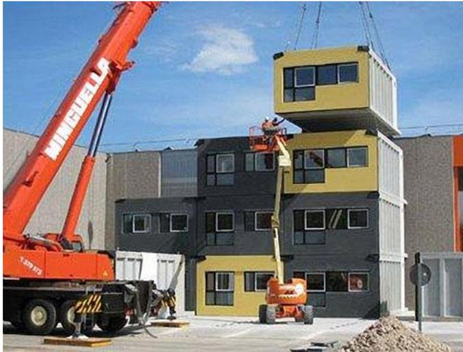
**Foto 16.-** Fotografía del montaje en obra, de un elemento industrializado en célula tridimensional.
