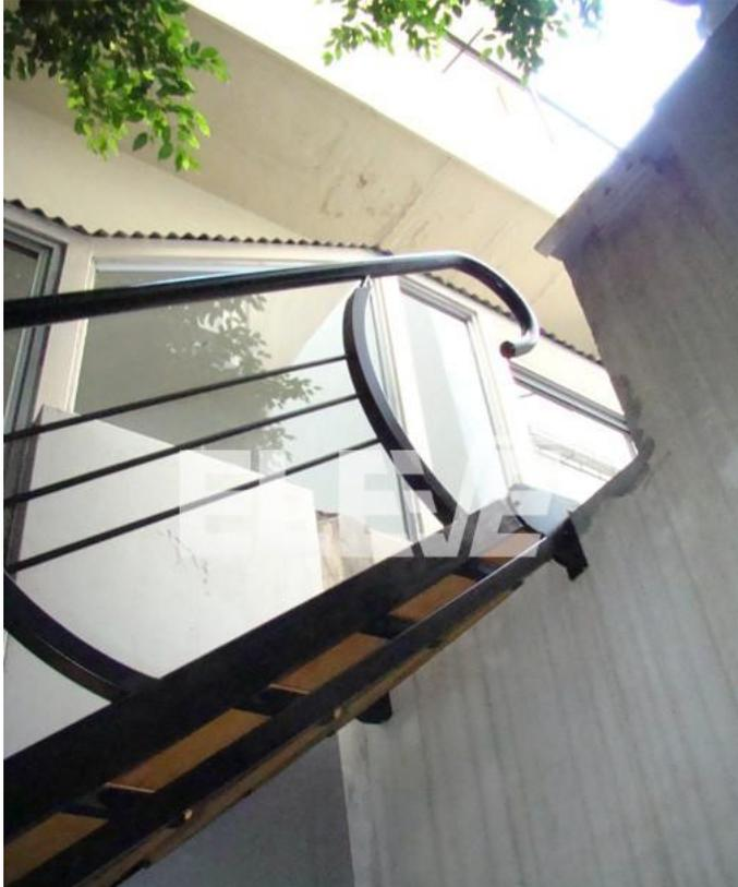
**Foto 110.-** Escalera prefabricada en material acero y madera del catálogo de la Empresa ELEVE.
