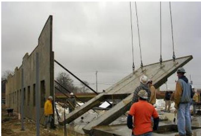
**Foto 7.-** Izaje de pared construido con sistema tilt-up.
