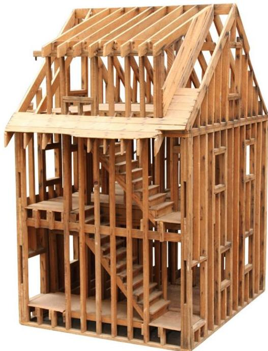
**Imagen 1.-** Vivienda en madera, construida con tipología “Ballon Framing”.
