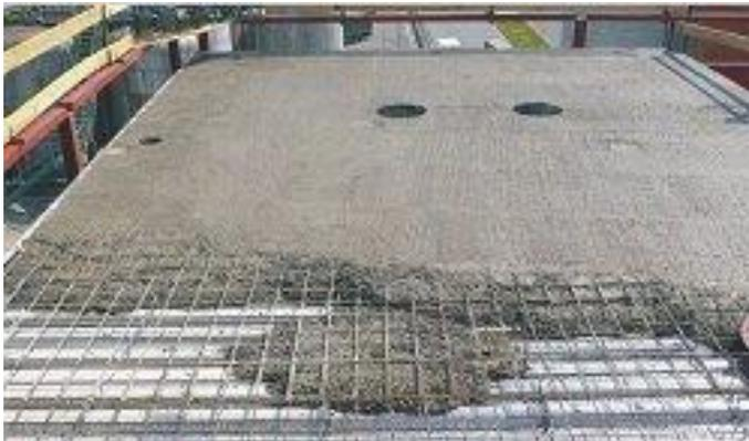
**Foto 97.-** Losa de piso en metal (steel deck), hormigón y malla para esfuerzos de temperatura. Losa hidráulica.
