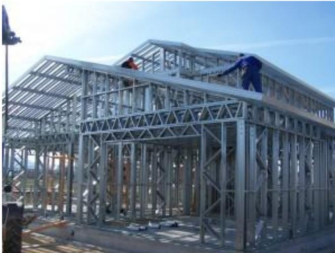
**Foto 11.-** Ejemplo de vivienda prefabricada de acero.
