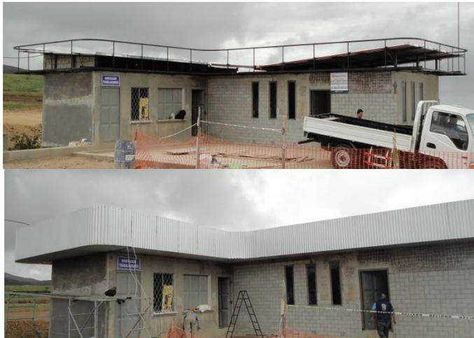
**Foto 125.-** En la parte superior se observa la estructura falsa para la marquesina, y en la parte inferior el acabado con planchas onduladas de color aluminio.
