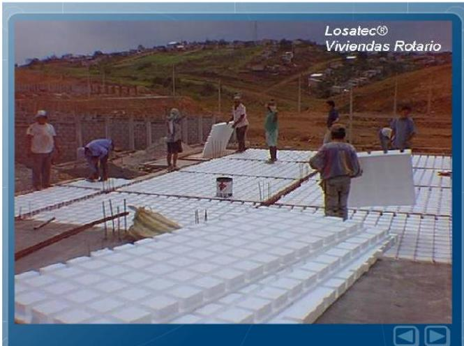
**Foto 49.-** Construcción de losa de entrepiso de las viviendas del Club Rotario Guayaquil, con el sistema losatec de AISLAPOL S.A.
