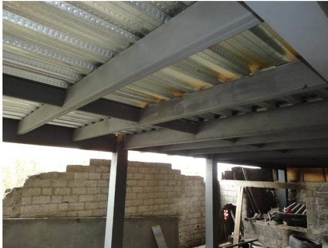
**Foto 100.-** Estructura de piso en acero, listo para verter hormigón, para este proyecto no es necesario apuntalamiento.
