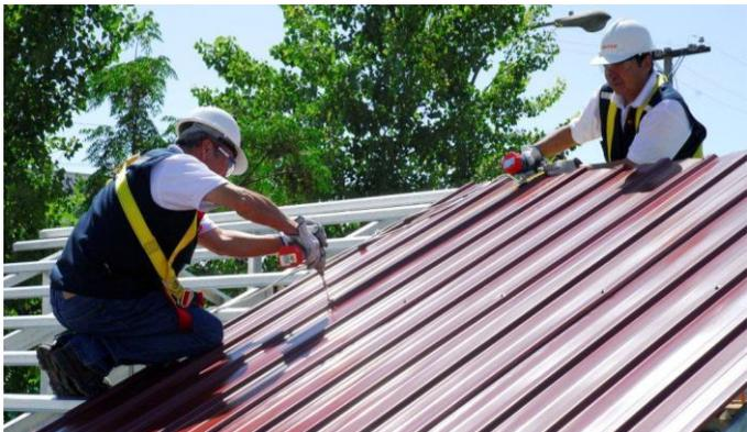
**Foto 116.-** Instalación de planchas de Cubierta en Acero.
