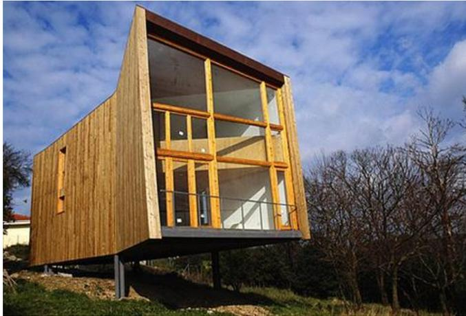
**Foto 12.-** Ejemplo de vivienda prefabricada mixta en estructura soportante de acero y tabiquería de madera.
