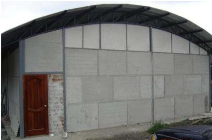
**Foto 58.-** Tabiquería exterior construida con paneles de micro hormigón de HORMYPOL.
