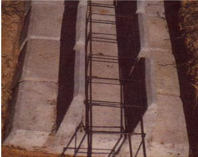
**Foto 81.-** Cimentación corrida, que permite hormigonar en obra las vigas de amarre de la cimentación.
