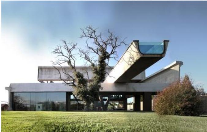
**Foto 83.-** Hemeroscopium House, construida en 7 días, con elementos de vigas para puentes y piscina en su parte superior.
