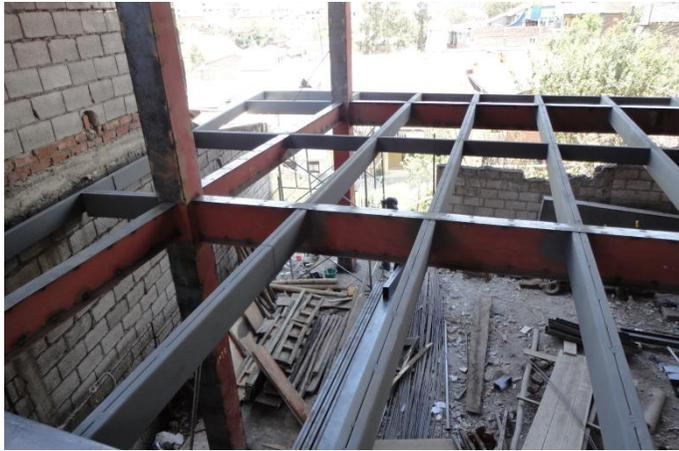
**Foto 77.-** Reforzamiento estructural y colocación de vigas secundarias en una estructura en acero de la Ciudad de Cuenca. Se observa combinación de acero conformado al caliente y acero conformado al frío.
