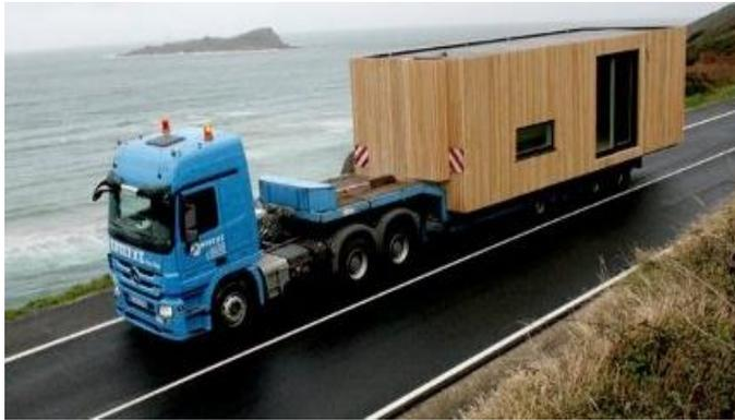
**Foto 42.-** Transporte de bloque tridimensional en plataforma baja.
