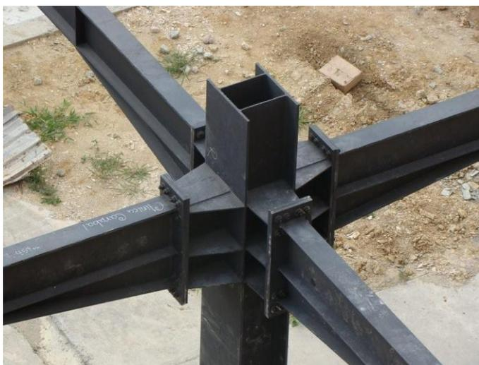
**Foto 90.-** Nudo tipo FR, construido en taller y las vigas se ensamblan en obra mediante pernos.
