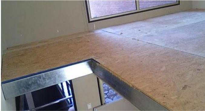
**Foto 96.-** Losa de piso en madera, con placas de OSB estructural. Losa seca.
