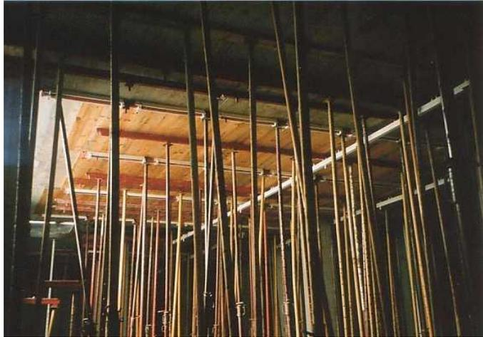
**Foto 99.-** Apuntalamiento de losas de hormigón armado, construidas de manera tradicional.
