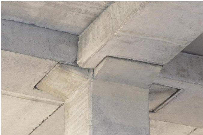
**Foto 84.-** Unión de vigas y columna en una edificación prefabricada en hormigón armado.
