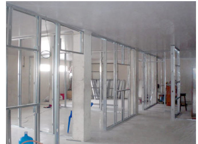
Imagen 40. Paredes de Yeso cartón.
