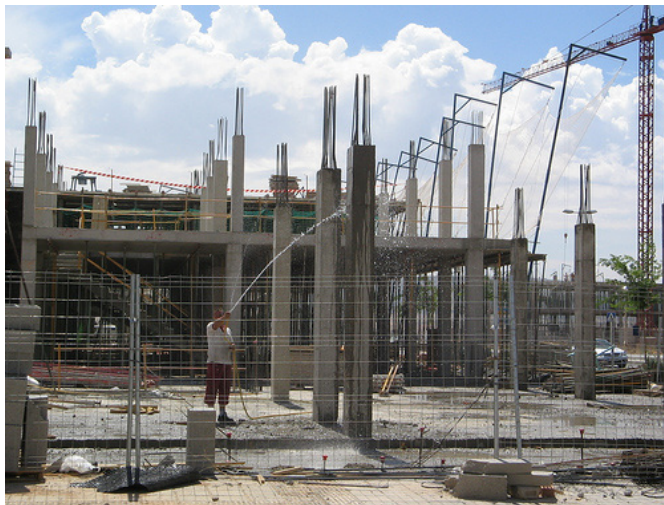
Imagen 12. Columnas de hormigón armado.
