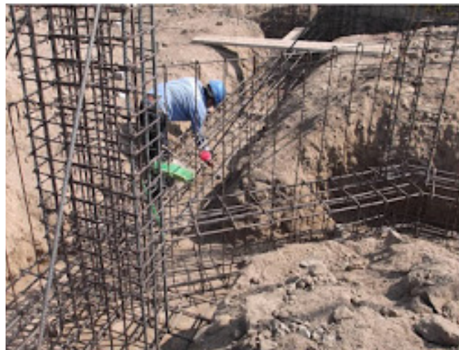
Imagen 16. Vigas de hormigón armado.
