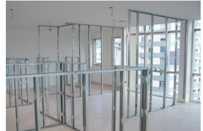
Imagen 37. Estructura para paredes de yeso cartón.
