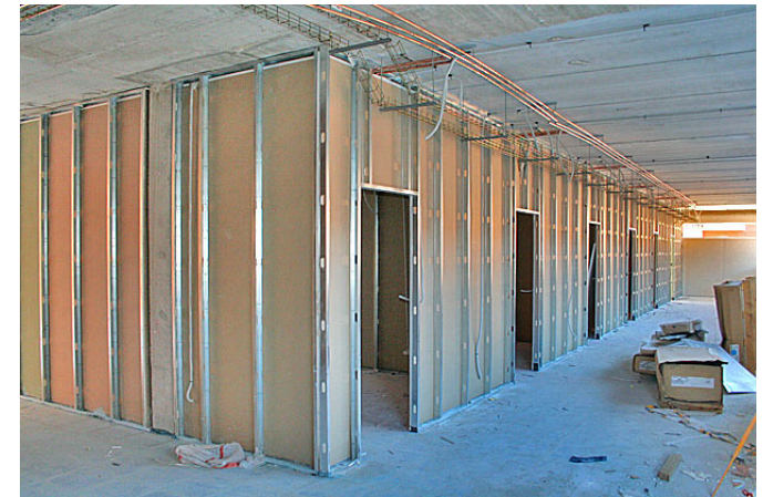
Imagen 35. Paredes de yeso cartón.
