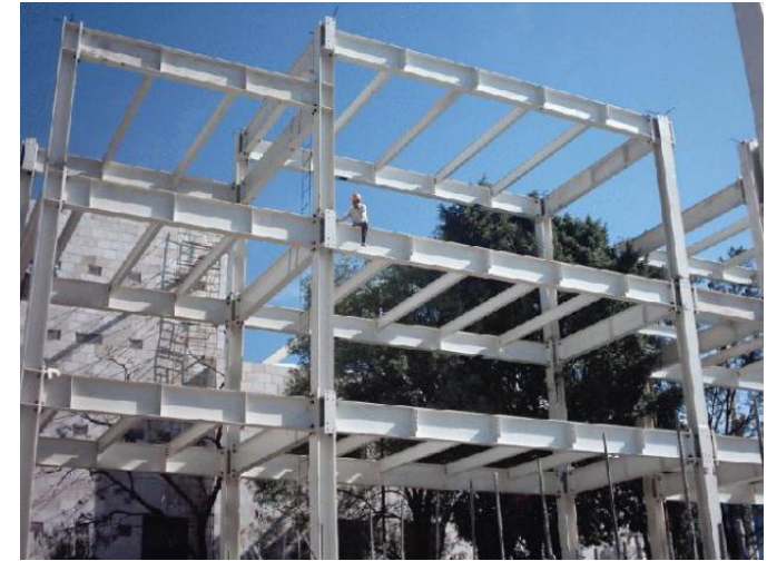
Imagen 31. Acero laminado estructural.
