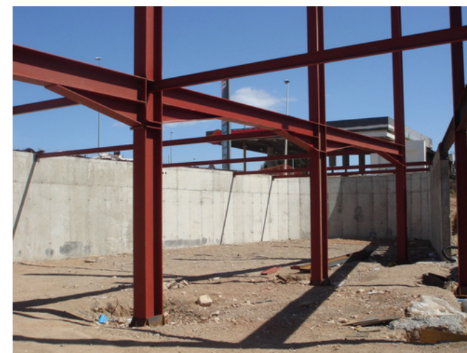
Imagen 28. Columnas vigas y refuerzos metálicos.
