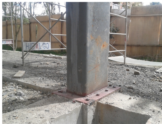
Imagen 14. Columna de acero.
