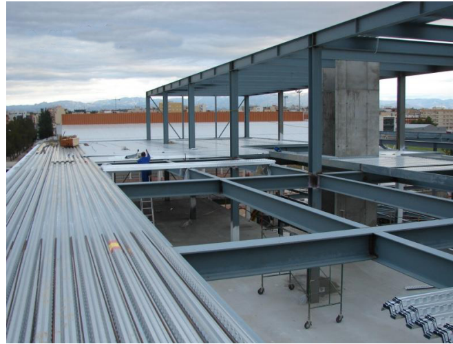
Imagen 22. Estructura metálica, placa colaborante.
