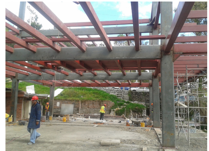
Imagen 18. Viguetas de acero estructural.
