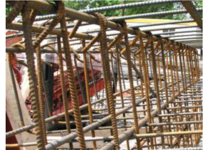
Imagen 25. Armadura y estribos.
