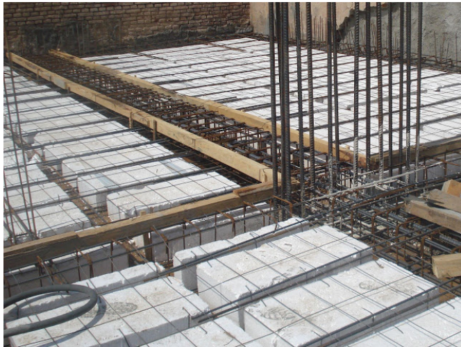
Imagen 20. Losa aliviada con bloque de pómez.
