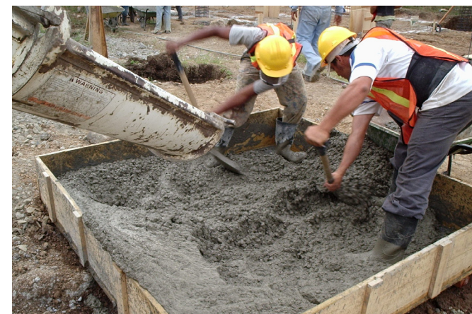
Imagen 24. Mezcla de hormigón.
