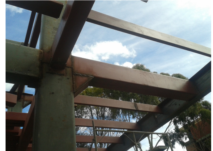
Imagen 17. Vigas de acero estructural.
