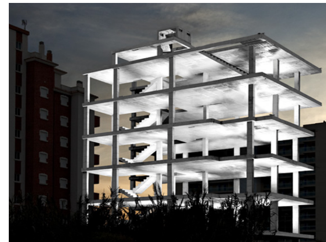
Imagen 23. Edificación en hormigón armado.
