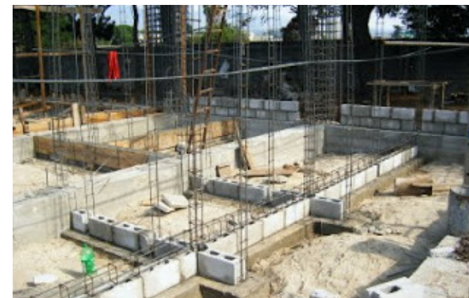
Imagen 9. Vigas de cimentación.
