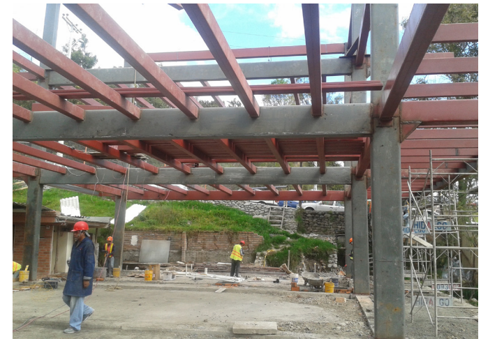
Imagen 30. Columnas, vigas y viguetas de acero estructural.
