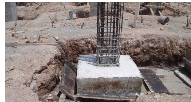
Imagen 8. Zapata de Hormigón armado.
