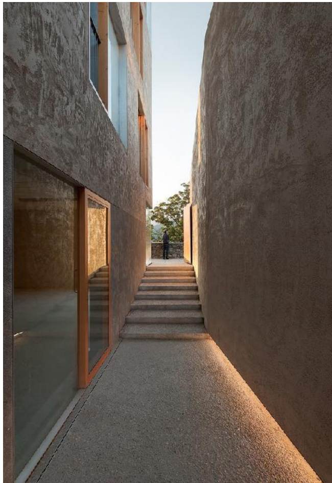
FIGURA 59. Corredor entre Bloques.
