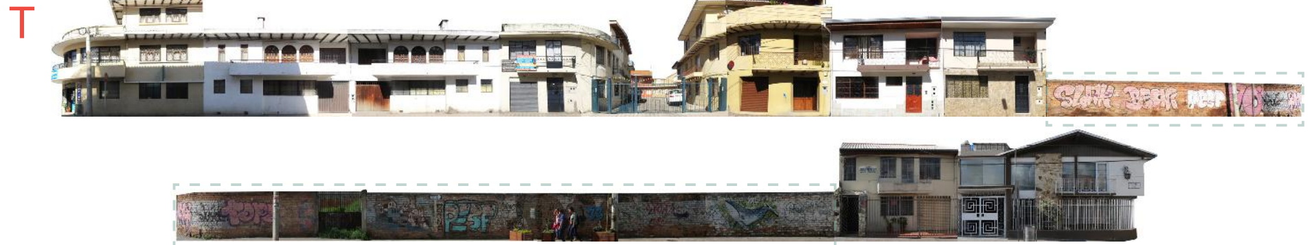
FIGURA 177. Tramo de la Manzana. El tramo está compuesto en su mayoría de construcciones de dos y tres pisos, con cubiertas inclinadas de teja. El lote se encuentra cerrado por un cerramiento de ladrillo y no posee construcciones dentro del mismo.
