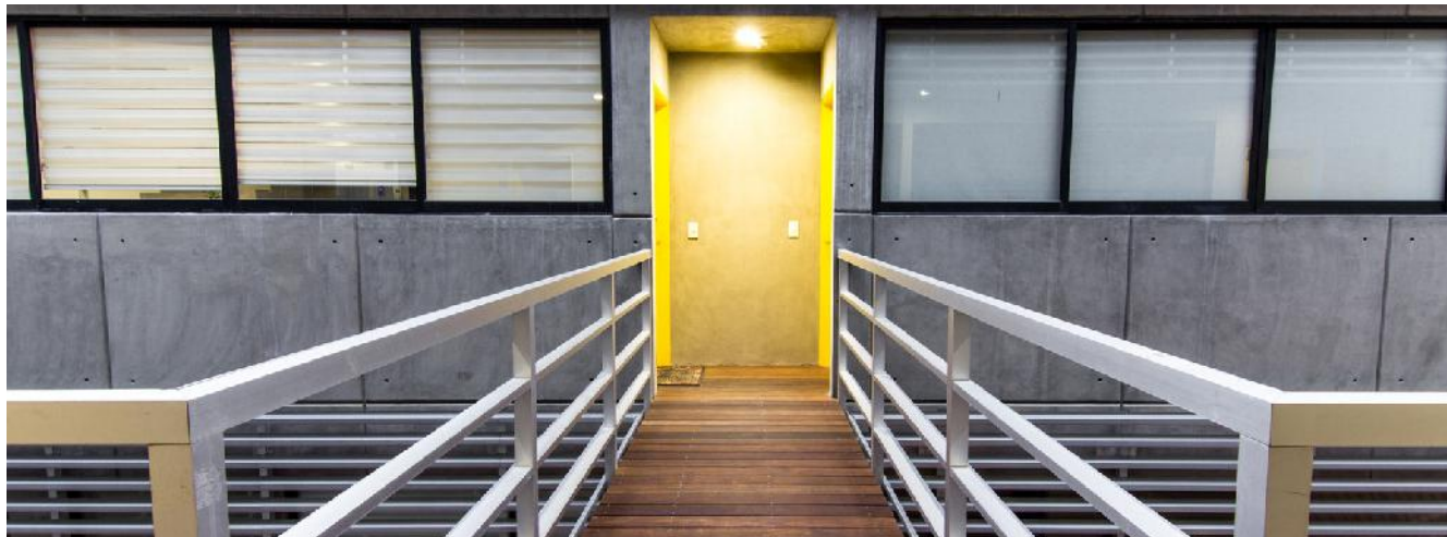
FIGURA 38. Puente que une bloques.
