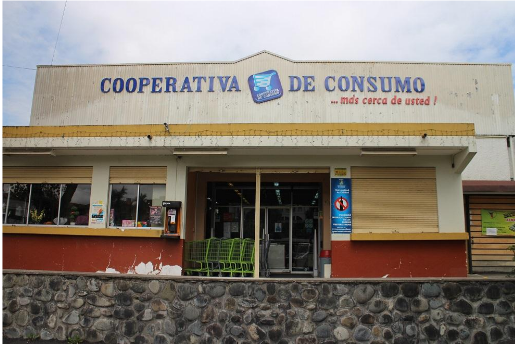
Fachada del local donde funciona la Cooperativa.
