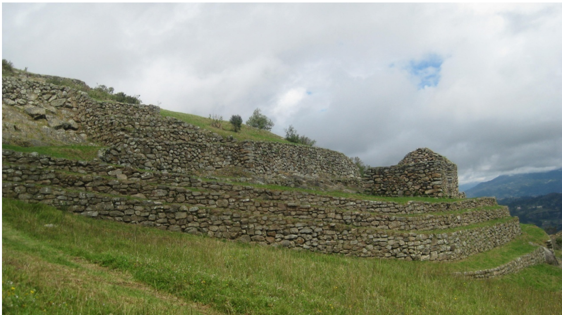
Vista lateral de la Conjunto III, zona habitacional reforzada con terracerías.
