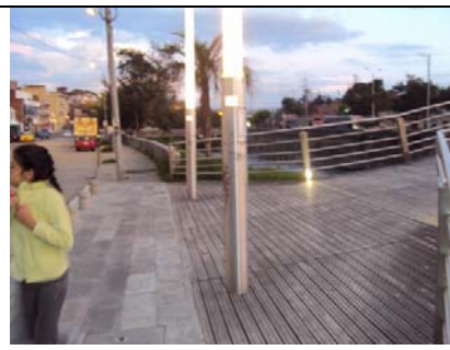
Puente peatonal iluminado
