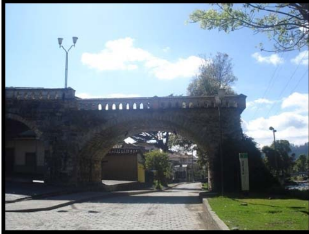
Puente Roto. Agosto 2009. Foto. Eco. Javier Ávila L.
