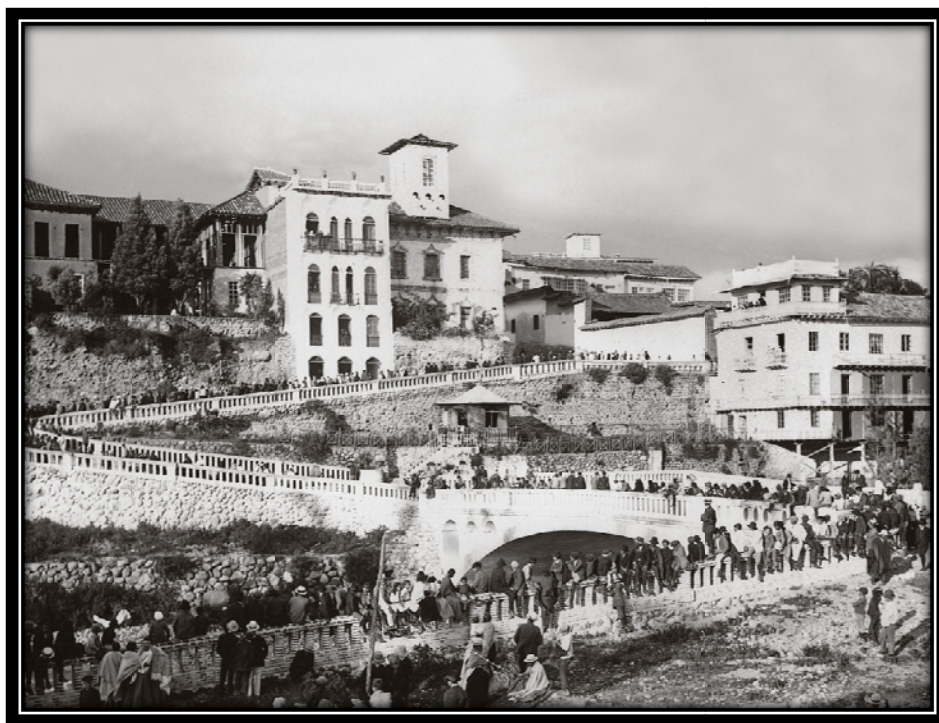
PUENTE CENTENARIO (CH0044) - 1926
