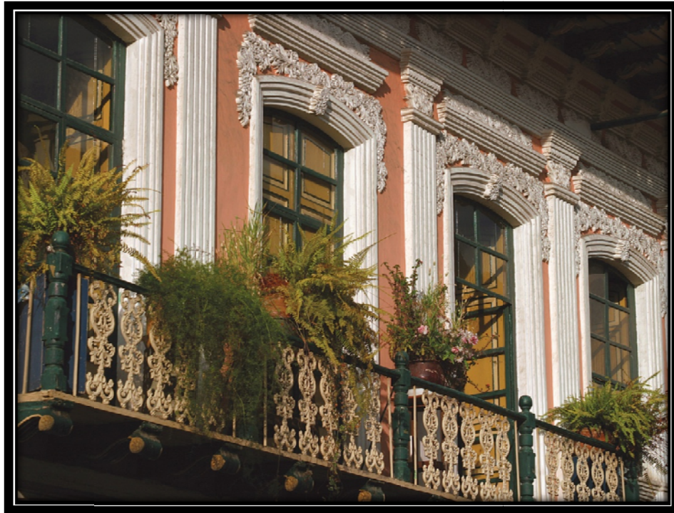
FACHADAS - BALCONES DE HIERRO FORJADO (CH0014) – 06/08/2009
