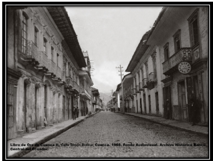
CALLE SIMÓN BOLÍVAR (CH0041) -
