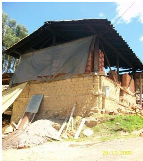
El horno es de adobe sus cimientos de piedra, con una ventana para introducir y extraer el ladrillo, sus pilares son de madera y su techo es cubierto con teja.
