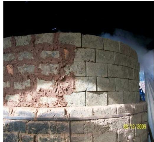
Horneado de ladrillo en un horno redondo formando círculos o filas horizontales con los mismos ladrillos y ajustado con un revestimiento en la parte superior del ovalo, sujetado con varillas de hierro.
