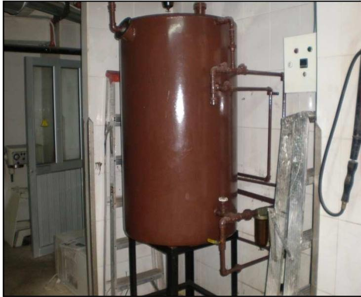
**Foto 2.3: Tanque de diesel ubicado en el cuarto de máquinas (200 gal).**
