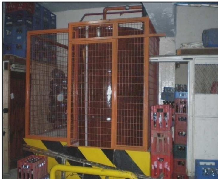
**Foto 2.4: Tanque de diesel ubicado en el parqueadero (1300 gal).**
