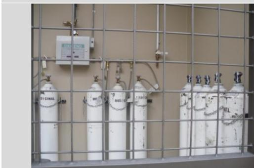
Imagen 29. Almacenamiento de los tanques de oxígeno
