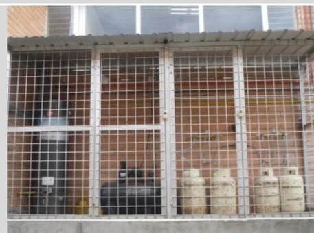
Imagen 30. Almacenamiento de los cilindros de GLP
